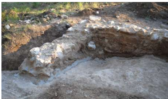
D'esquerra a dreta: 1) Fotografia del procés de segellat de les parts baixes dels murs amb morter de calç. 2) Fotografia del procés de restitució volumètrica d'un dels murs, amb la col·locació d'una filada de pedres lligades amb morter de calç sobre la malla T per diferenciar-ho de les restes originals.
