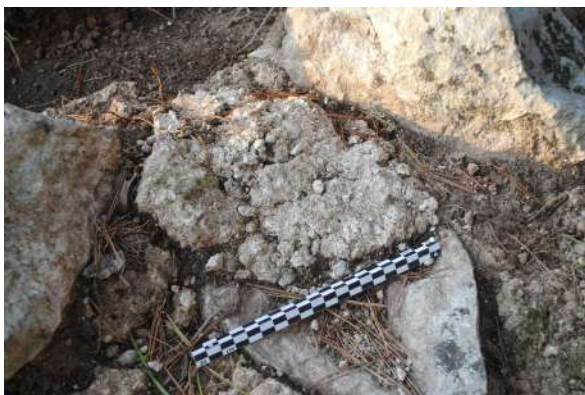
Fotografies del detall de les restes del morter original i del lliscat de l'encofrat amb algunes pèrdues abans de la seva intervenció.
