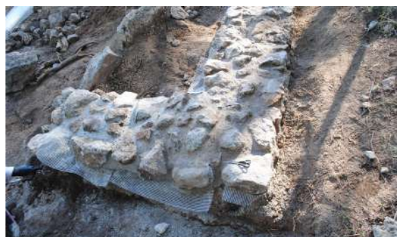
D'esquerra a dreta: 1) Fotografia del procés de segellat de les parts baixes dels murs amb morter de calç. 2) Fotografia del procés de restitució volumètrica d'un dels murs, amb la col·locació d'una filada de pedres lligades amb morter de calç sobre la malla T per diferenciar-ho de les restes originals.
