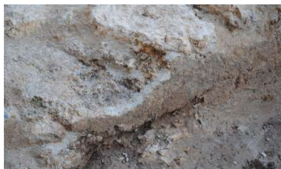
D'esquerra a dreta: 1) Fotografia del procés de segellat de les parts baixes dels murs amb morter de calç. 2) Fotografia del procés de restitució volumètrica d'un dels murs, amb la col·locació d'una filada de pedres lligades amb morter de calç sobre la malla T per diferenciar-ho de les restes originals.
