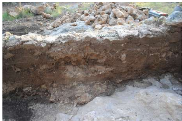
Fotografies del detall de les restes del morter original i del lliscat de l'encofrat amb algunes pèrdues abans de la seva intervenció.
