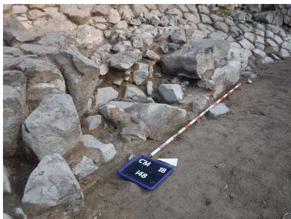
26. Tram de muralla UE 2163
