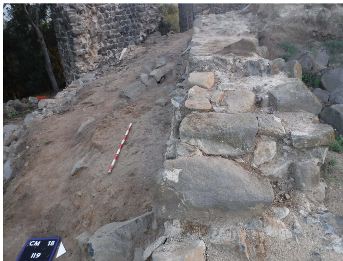
20. Ala oest des del sud, excavat l'enderroc UE 2130.
