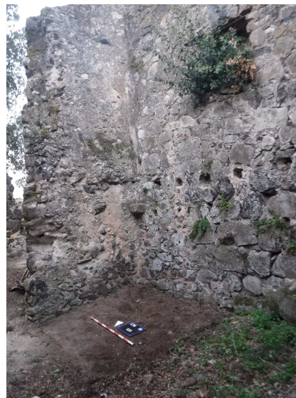
13. Sondeig del sector 33 a l'inici de l'excavació.
