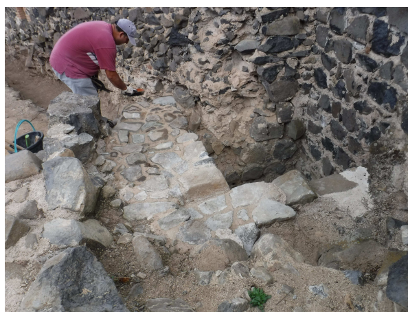
30. Torre NE durant la consolidació
