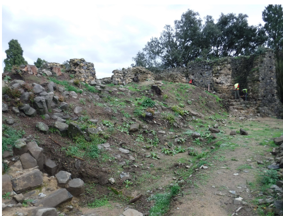
22. Ala sud. Inici intervenció
