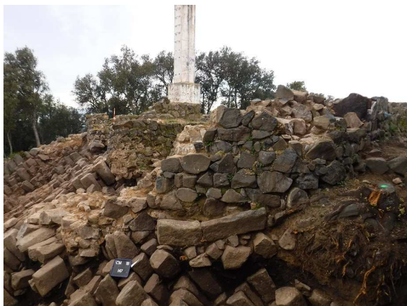
24. Mur UE 2159. Vista frontal.
