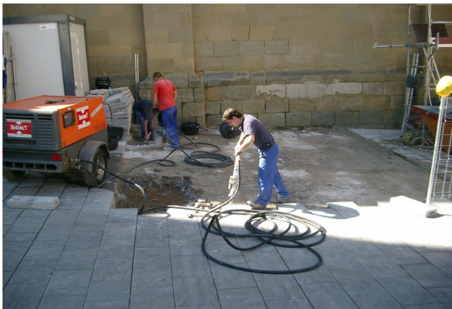
Treballs d'extracció del paviment actual (ue.16)
