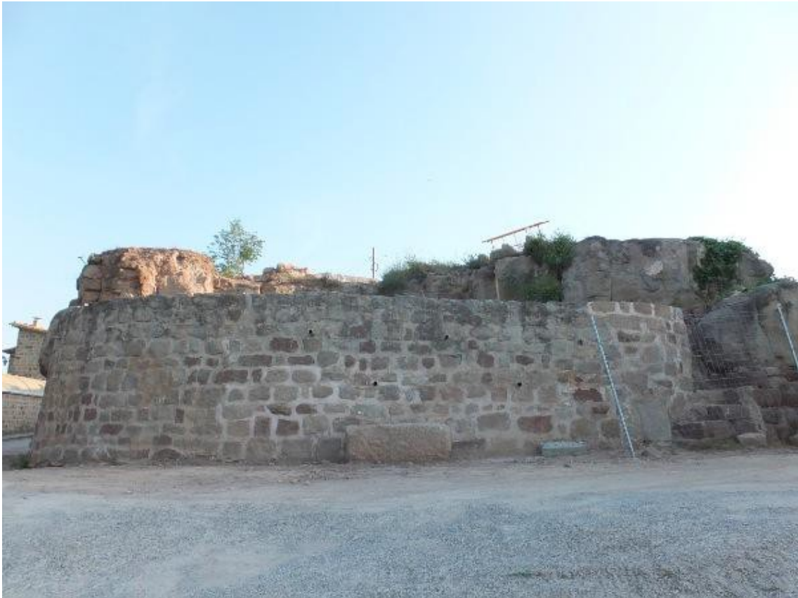
Figura 5: Vista del castell des de ponent, un cop enretirada la plataforma de formigó i les casetes de telecomunicacions
