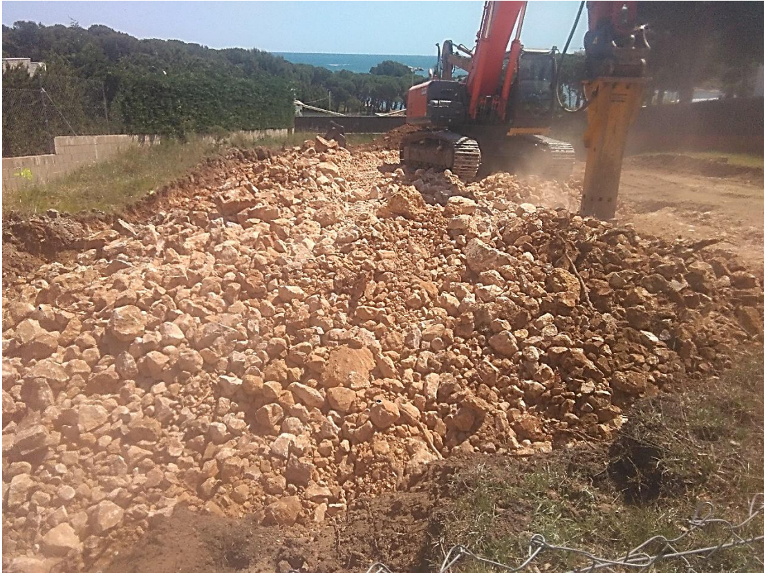
Fig. 15. Treballs de picament de la roca gairebé finalitzats.
