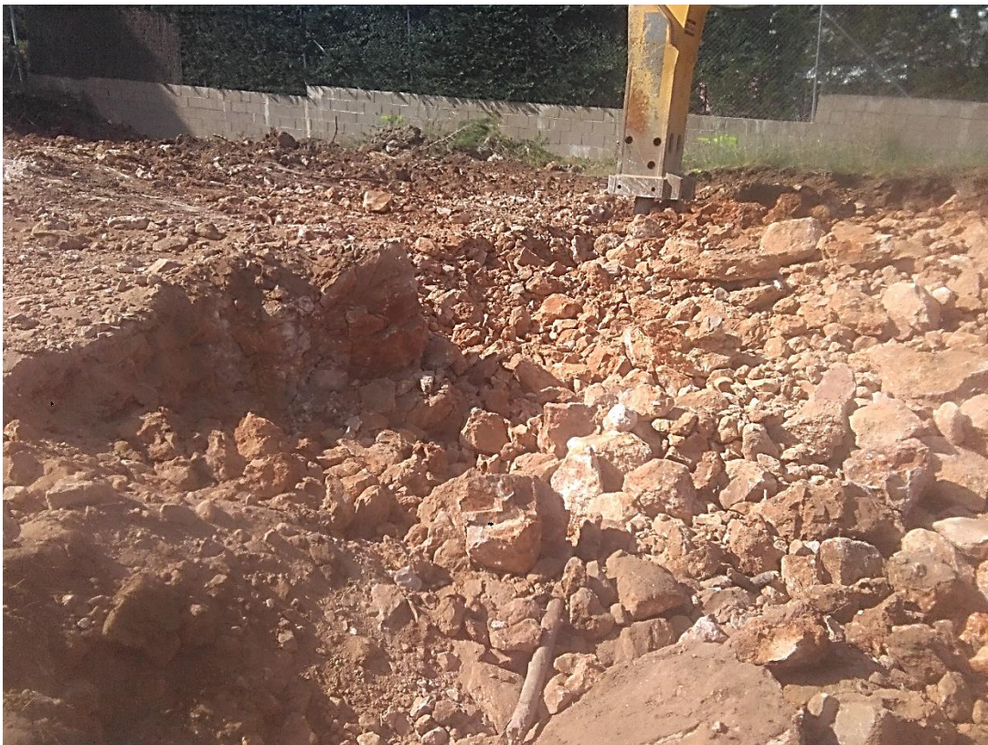
Fig. 14. Treballs de picament de la roca. S'aprecia la important potència d'aquesta.
