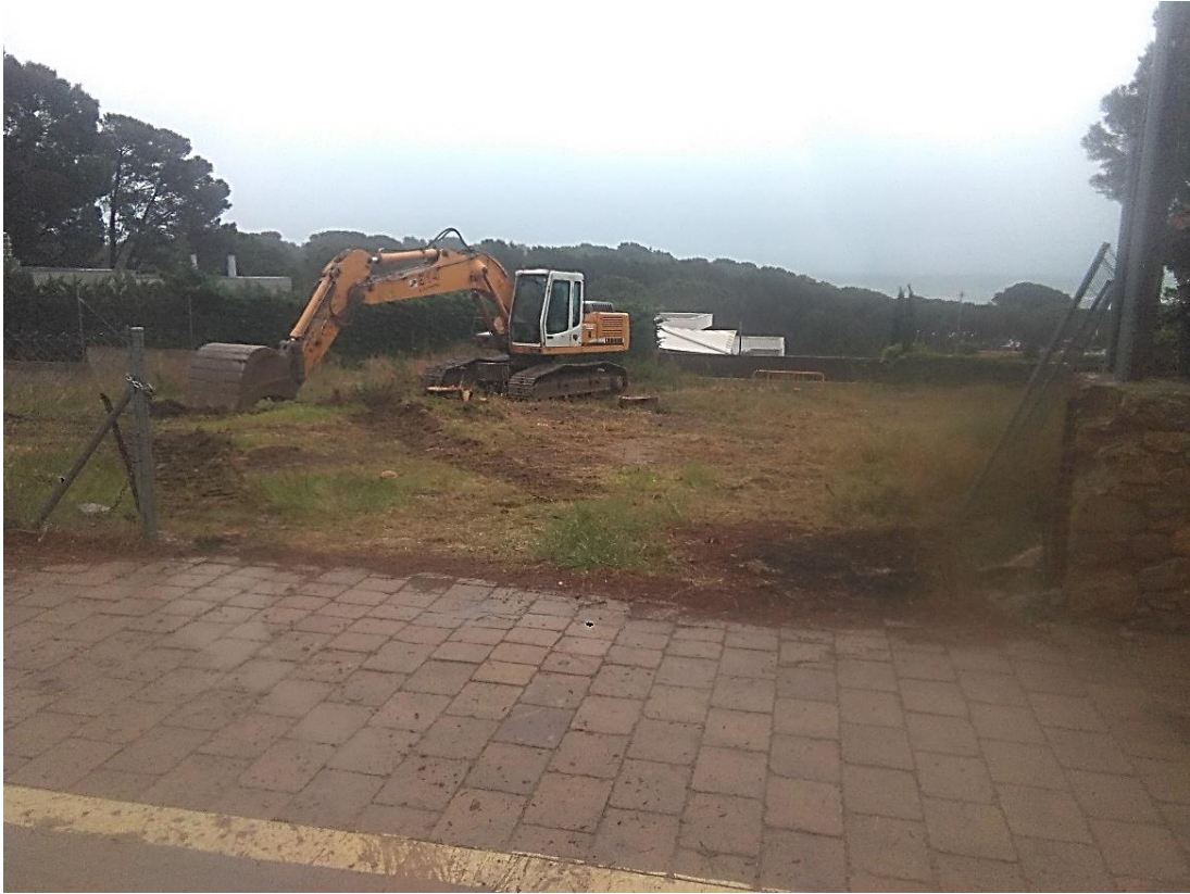
Fig. 7. Estat de la parcel·la abans de la realització de les obres.
