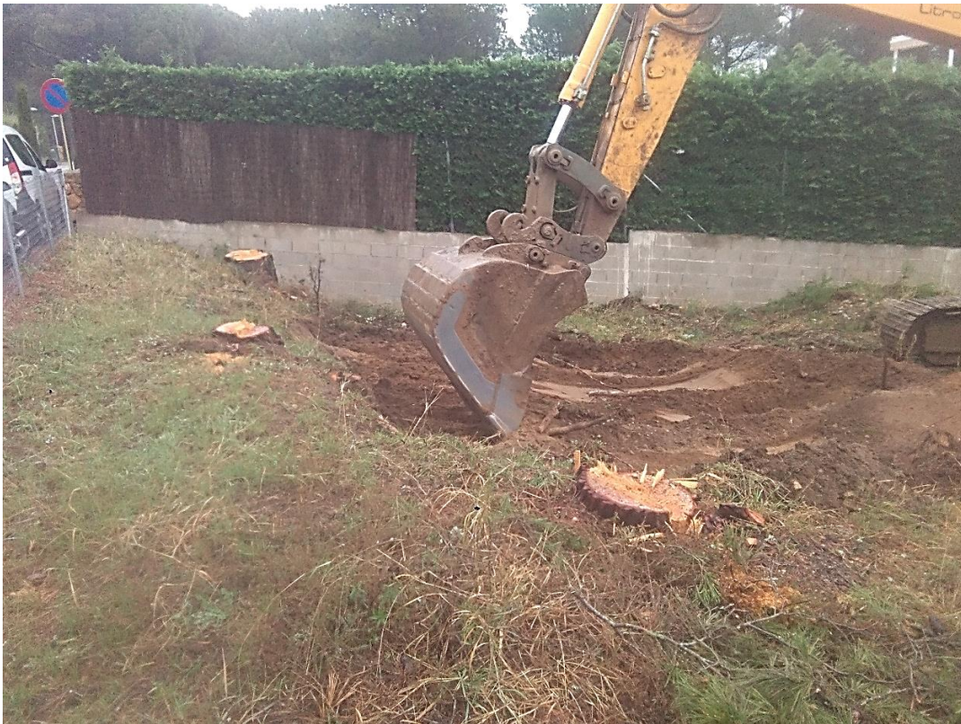
Fig. 8. Inici del rebaix del terreny, al costat oest de la parcel·la.
