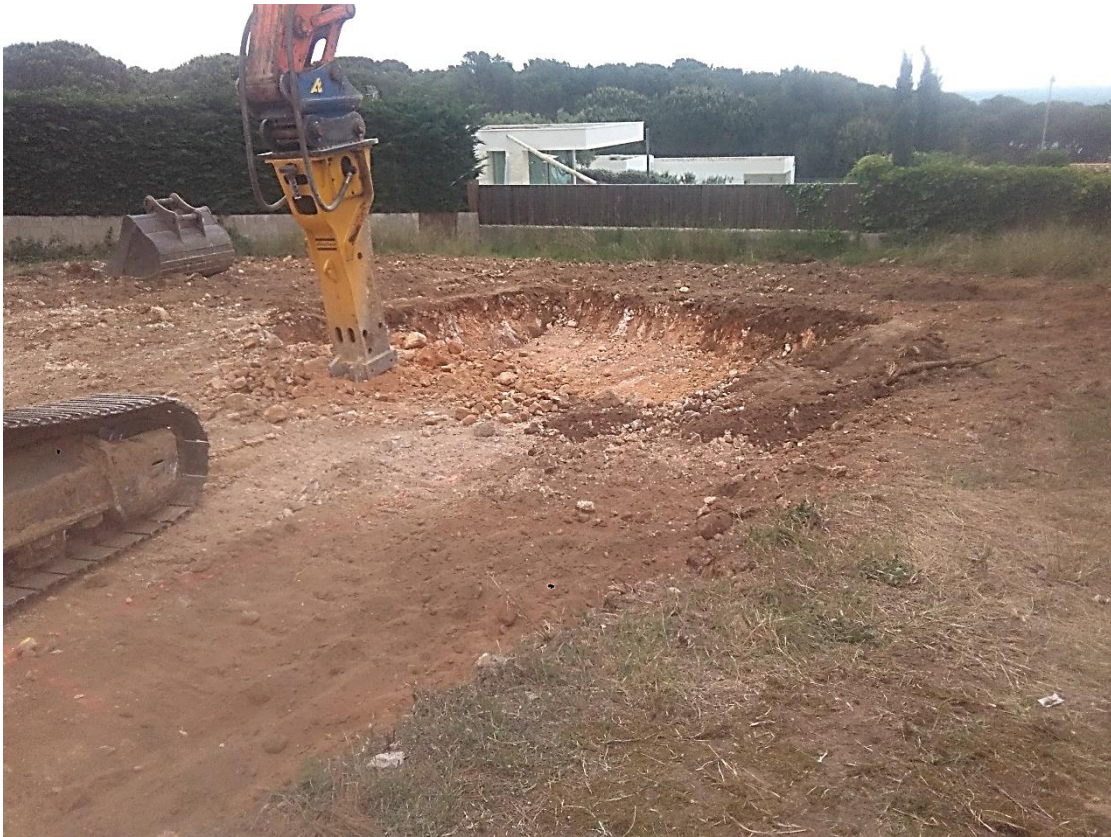
Fig. 17. Inici dels treballs de rebaix del terreny per a la construcció de la piscina a la part est de la parcel·la.
