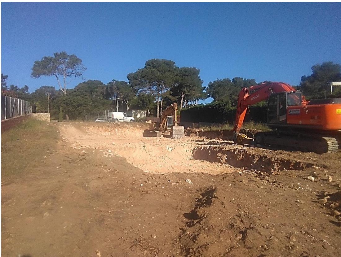
Fig. 20. Vista de la parcel·la amb els treballs de rebaix del terreny finalitzats, des de l'est.
