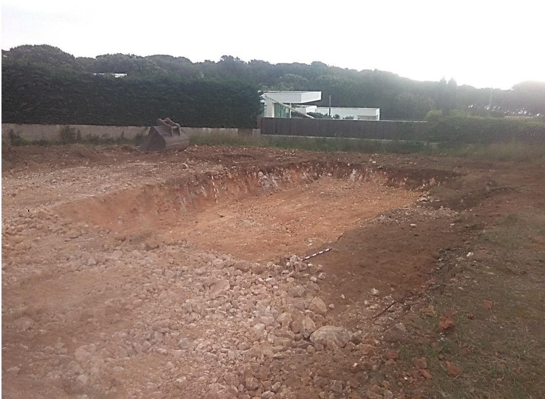
Fig. 18. Treballs de rebaix del terreny per a la construcció de la piscina finalitzats.
