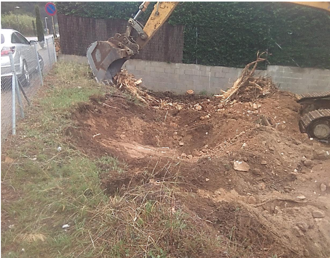
Fig. 10. Arrencament de les arrels dels arbres presents al costat oest de la parcel·la.
