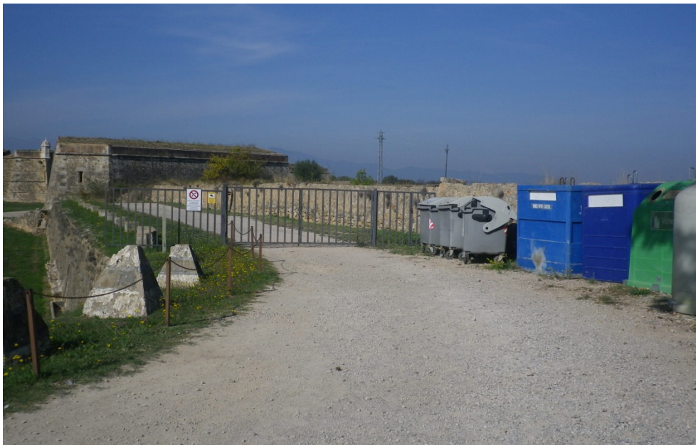
5. Porta que tanca el pas a la rampa de vehicles
