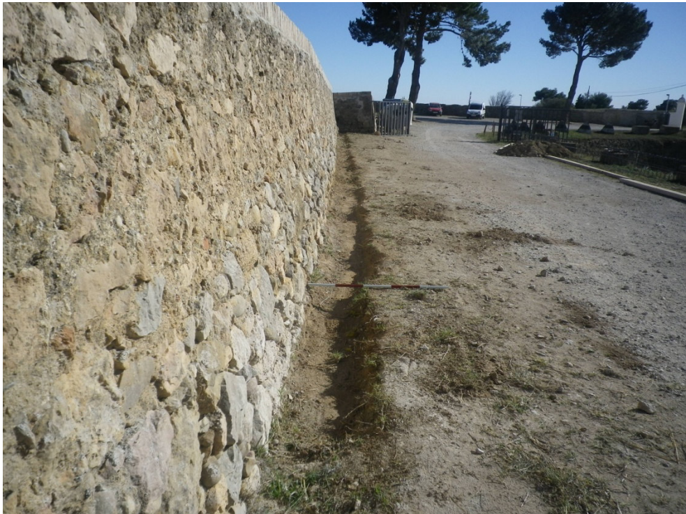
22. Rasa realitzada sobre UE 40.000
