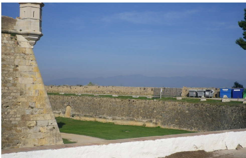
6. Porta que tanca el pas a la rampa de vehicles i tram de parapet del camí cobert al darrere
