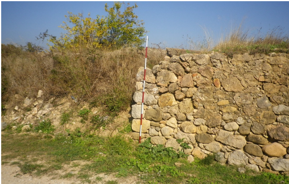
8. Terres davant del camí cobert de la plaça d'armes afectada per l'ampliació de la rampa
