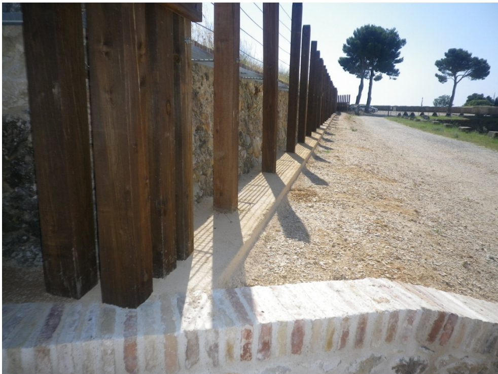
45. Aplicació de les terres estabilitzades amb calç
