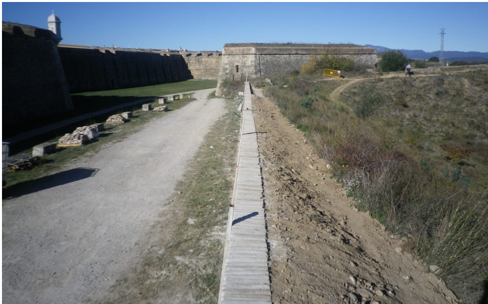
20. Sardinell restituït sobre el parapet
