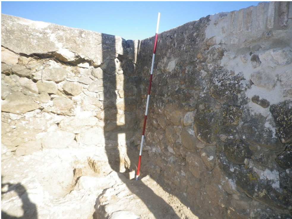
35. Mesurament de la profunditat de l'emplaçament de l'estaca a l'andana
