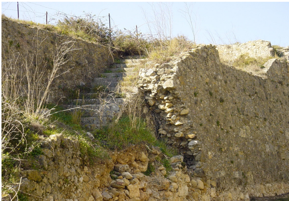
2. Filat a l'accés a una de les escales que porta al fossat
