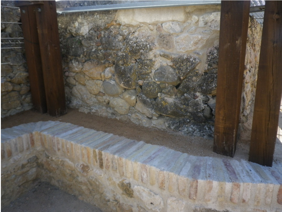
44. Aplicació de les terres estabilitzades amb calç
