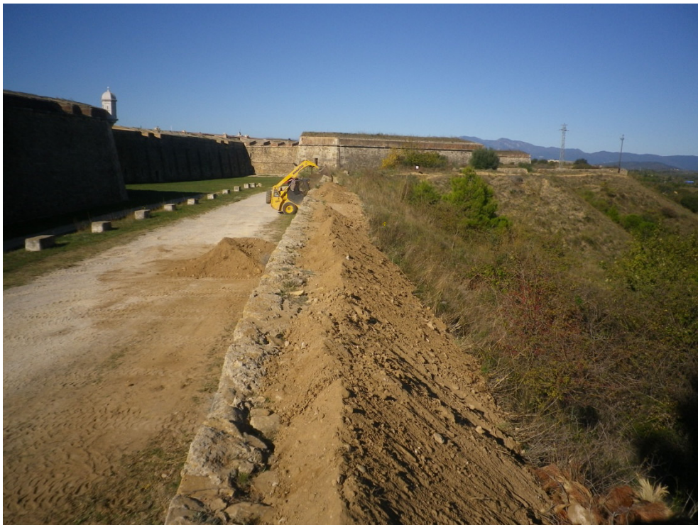
19. Reposició de terres al coronament del glacis
