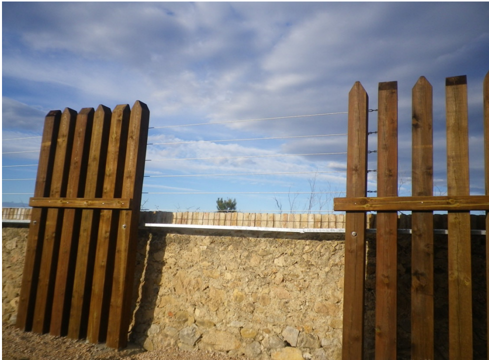
25. Tram d'estacada amb reixat i cablejats instal·lats
