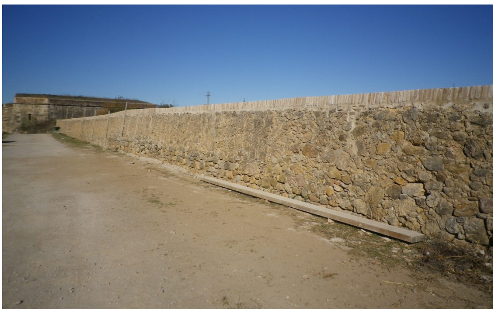
21. Parapet sanejat i amb el sardinell restituït
