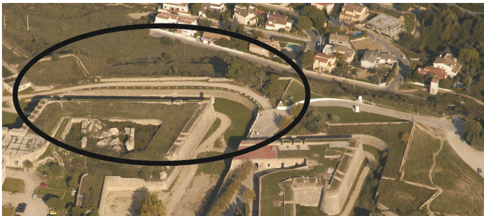
4. Imatge aèria recent on apareix el tram de camí cobert modificat
