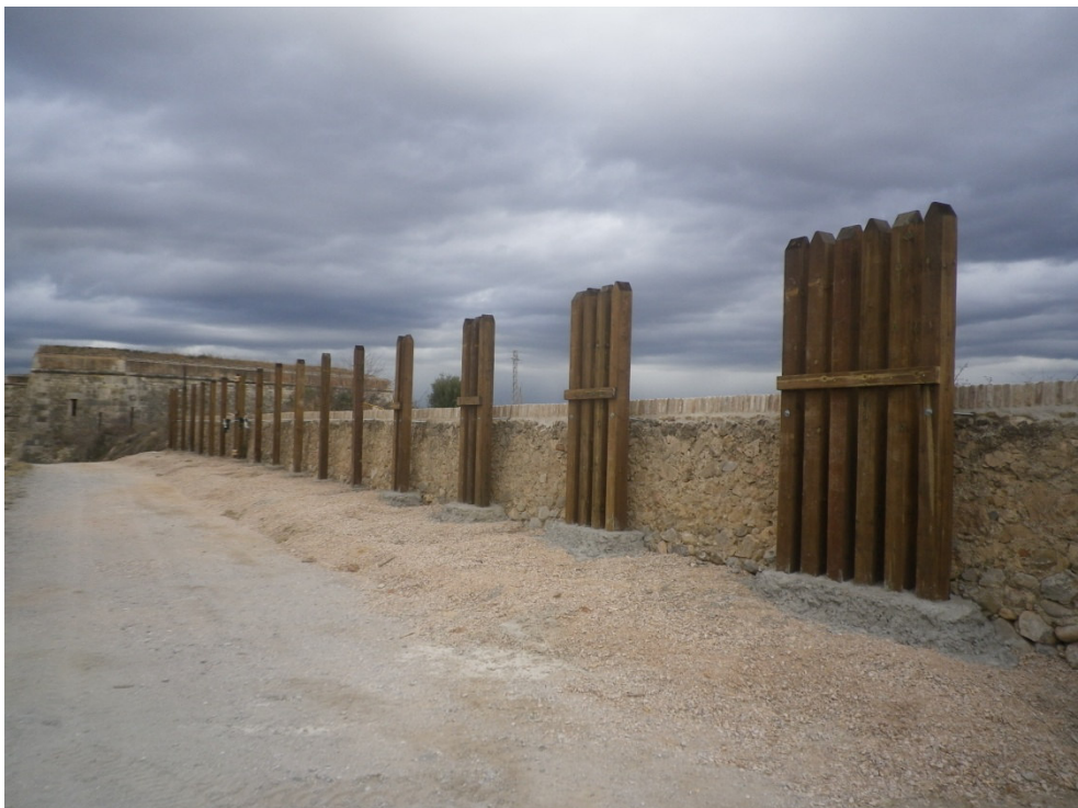
24. Tram d'estacada discontinua fixada sobre la banquetta a mig formar
