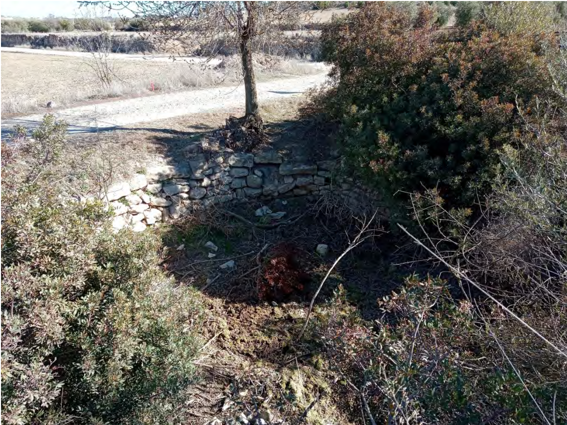
Fig. 23: PI-09, dipòsit circular de pedra.
