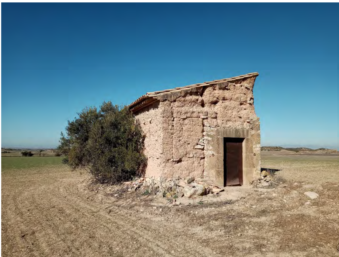
Fig. 20: Cabana del Damià, des del sud-est.
