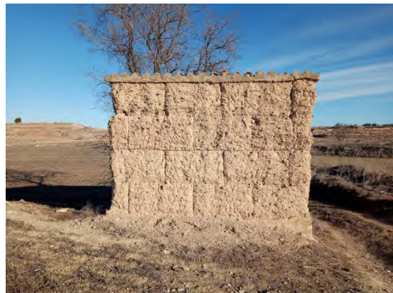
Fig. 16: cabana de tàpia, vista de la façana sud.
