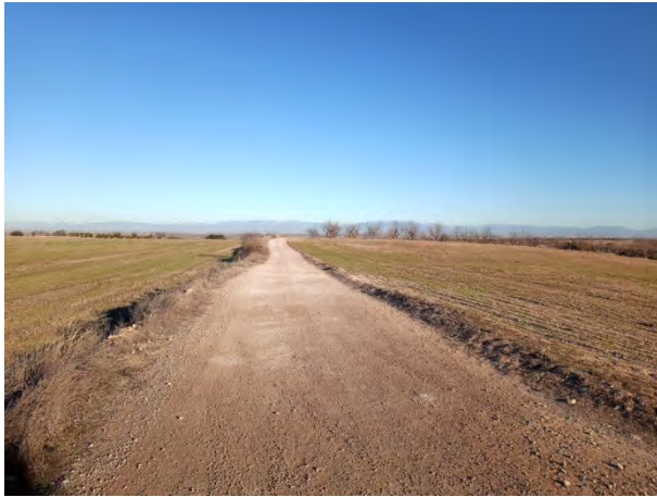
1. Ramal 11 – oest, des del sud.
