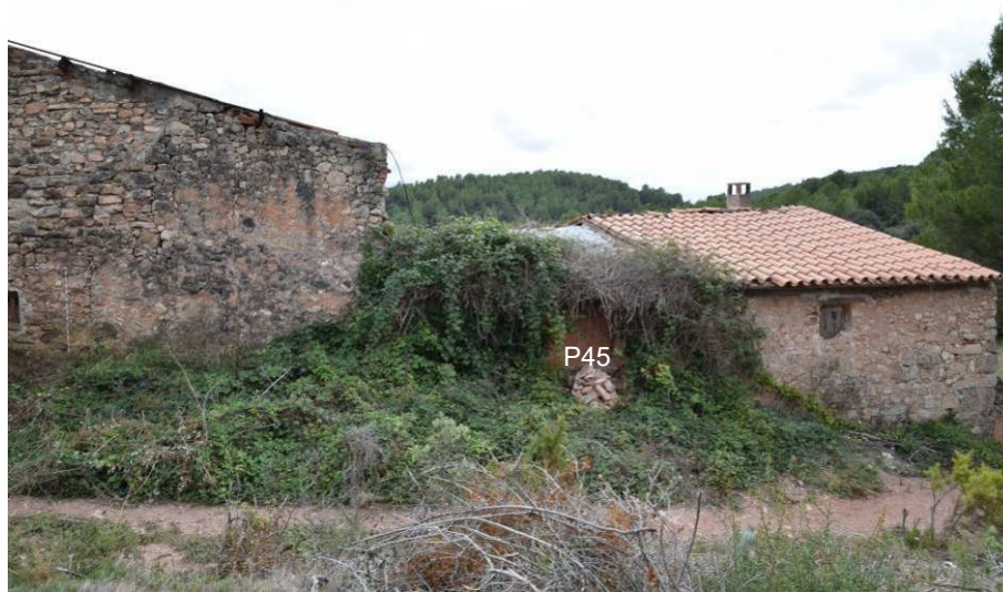
48. Detall de la façana posterior/N E7, on es pot veure el tapiat de totxanes i ciment del finestral P45 del primer pis de l'àmbit PIX. També és evident el canvi en l'alçada de la coberta, degut a l'esglaó que marca el terreny natural entre els àmbits del costat est i els de l'oest, a cota més baixa.
