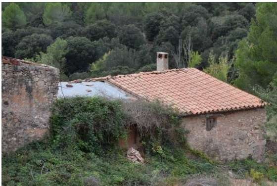
59, 60. Vista general i detall dels àmbits IX i X des del costat nord (esquerra) i a l'angle NW, on destaquen els carreus i grans blocs de reforç cantoner.
