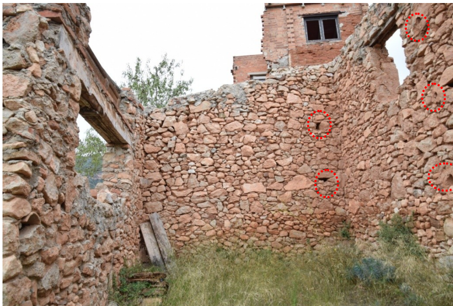
134. Detall de la façana N, on es pot veure la inclinació conservada de la coberta. Indicats els encaixos de l'entramat o element mòble adossat a la façana E, amb reforç cantoners a l'angle de les parets N i S.
