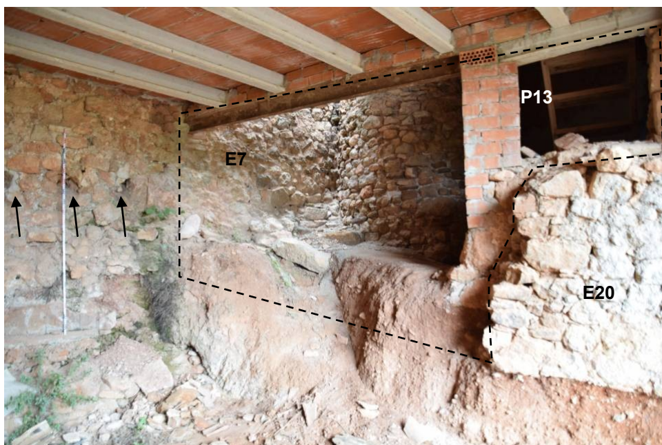
43. Detall de l'àmbit BVI (dreta) des de la zona baixa del terreny a l'àmbit IX. Al fons es pot veure la façana posterior/nord E7, que mostra continuïtat entre ambdues zones del sector A (la zona alta i la zona baixa del terreny). Indicat el tancament original de la paret E20, substituïda per uns pilars de totxanes i ciment i una biga de ferro on recolza el nou forjat del pis de l'àmbit PIX.
