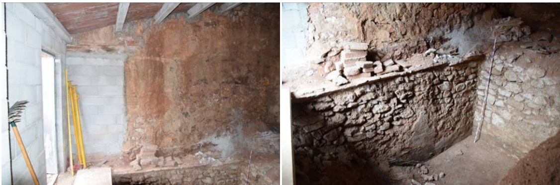
97, 98. Detall de la paret oest, corresponent a la façana oriental de la segona fase E3, on s'obre la porta lateral P2, ara tapiada amb blocs de formigó. En la part inferior es troba la fossa sèptica E5-, que apareix en detall a la imatge dreta.
