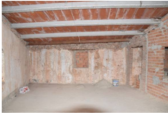
57, 58. Detall de la façana nord E7 des de l'interior de l'àmbit X, a nivell de planta baixa (esquerra) i pis (dreta), amb la finestra tapiada P45.
