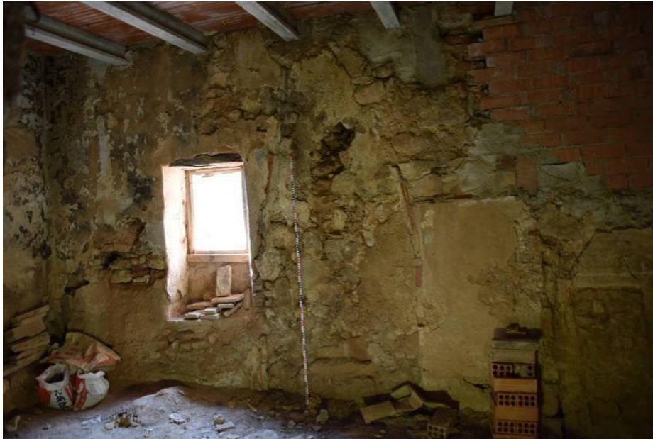
33. Detall de la paret occidental E20, en el tram on la planta de l'edifici fa un reclau i queda un tros de façana lateral amb la finestra P14.
