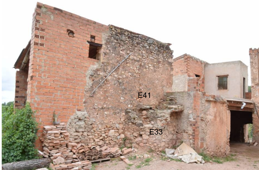
119. Vista lateral de l'àmbit XV, on es pot veure com la paret nord recolza damunt l'estructura del pou E33.
