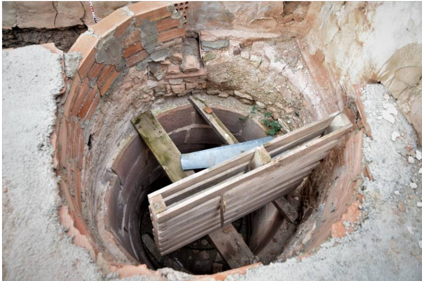
39. Detall des de la part superior del cup E15 de l'estat en què es troba actualment. Es poden veure els cairons que folren interiorment l'estructura.
