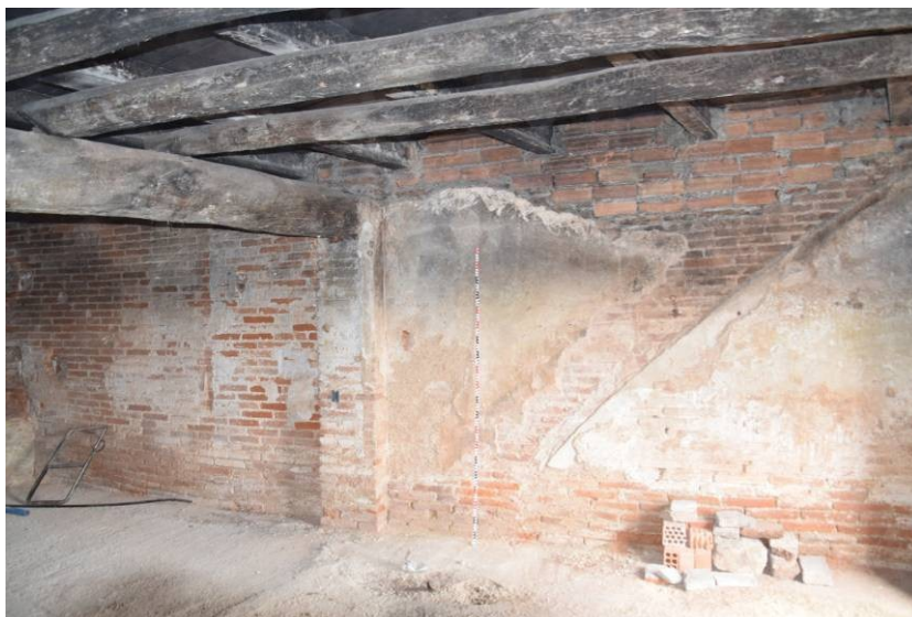
102. Detall de la paret E de l'àmbit X –E25- obrada amb maons plans. Indicada l'empremta de l'escala d'accés al pis, actualment desapareguda.
