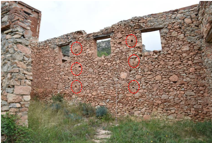
133. Detall de la façana interna del costat oriental, amb les finestres P39, P40 i P41 (d'esquerra a dreta) situades en la part elevada de la paret, just sota la coberta. Visibles els encaixos de l'entramat o estructura mòble adossada a aquesta paret (indicats).
