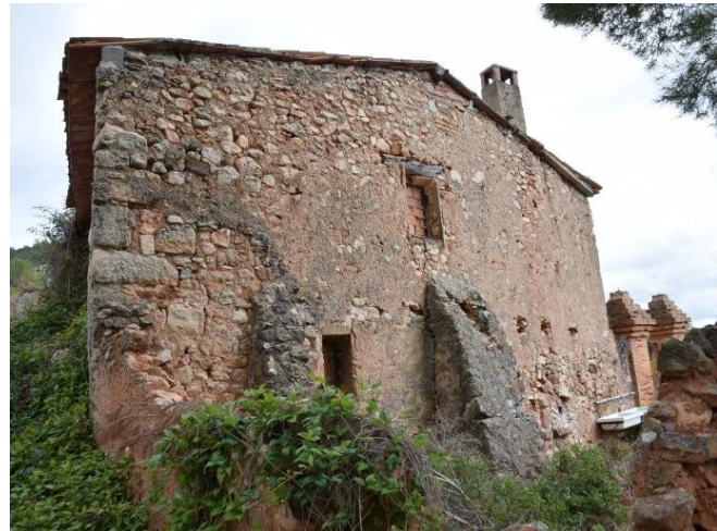
51, 52. Detall de la façana oest de l'àmbit X, on es poden veure les finestres de la planta baixa i els contraforts E22 i E23. Destaca el reforç de carreus i grans blocs de la cantonada NW.
