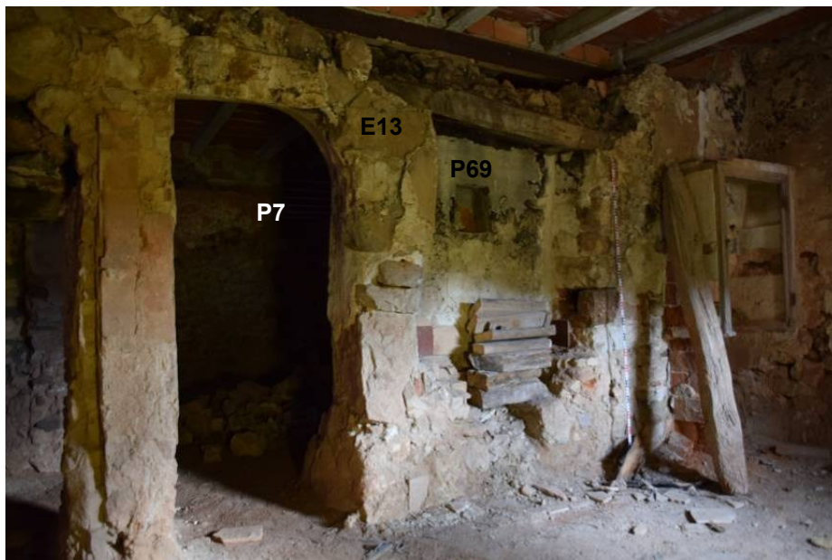
34. Vista de la paret E on es troba la porta que connecta l'àmbit BVI sud amb el vestíbul o àmbit I -P7-, al costat de la qual es conserva un armariet encastat tipus fornícula -P69- fet a la paret E13.
