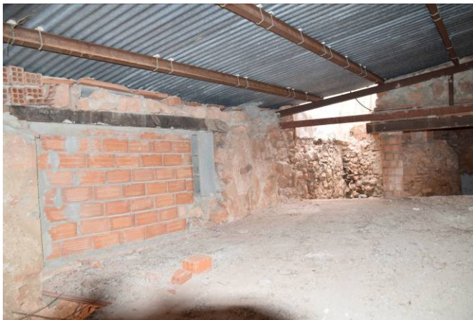
49, 50. Detall del primer pis de l'àmbit IX, on es pot apreciar com el nou forjat va anul·lar el llindar de l'obertura nord P45 i parcialment la porta que connectava amb l'àmbit PX, la P44 (a la dreta).
