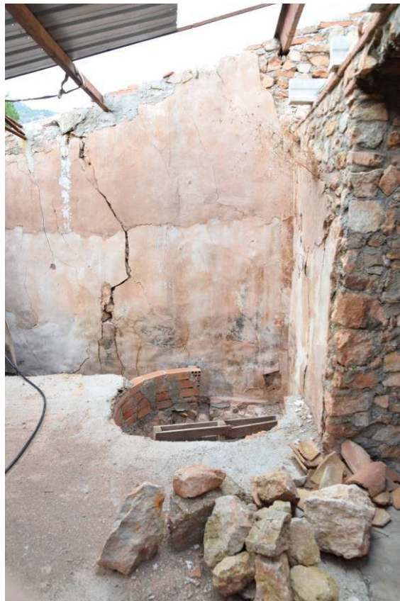
66, 67. Esquerra: detall de l'escala que connecta la planta baixa amb el pis i les golfes, molt refeta en època recent. Dreta: Detall de l'àmbit PVI amb la part superior del cup E15, refet fins la cota de l'actual forjat amb totxanes i ciment, anul·lant la boca superior d'entrada de líquids. A la seva dreta la porta d'accés a l'àmbit PV.
