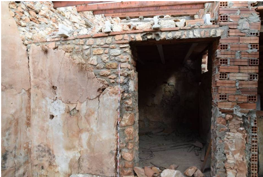
68. Detall de la paret de maçoneria E13, que separa els àmbits PVI i PV. La porta de connexió –P48–, manté únicament el muntant esquerre/N, força retocat/reatat amb ciment. El del costat oposat actualment està definit per un pilar de totxanes i ciment.
