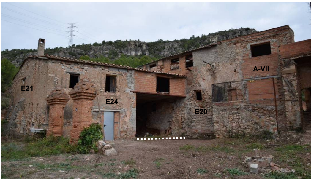
16. Detall de la zona baixa del sector A, on es pot veure el tram de façana sud E24 parcialment enderrocada durant les reformes més recents a l'alçada de l'àmbit IX (traçat restituït en discontinu). Tot i això, encara es conserva l'empremta del seu tancament contra la paret lateral del mur de contenció dels àmbits superiors E20. A la dreta, el cos afegit durant una reforma corresponent a l'àmbit VII.
