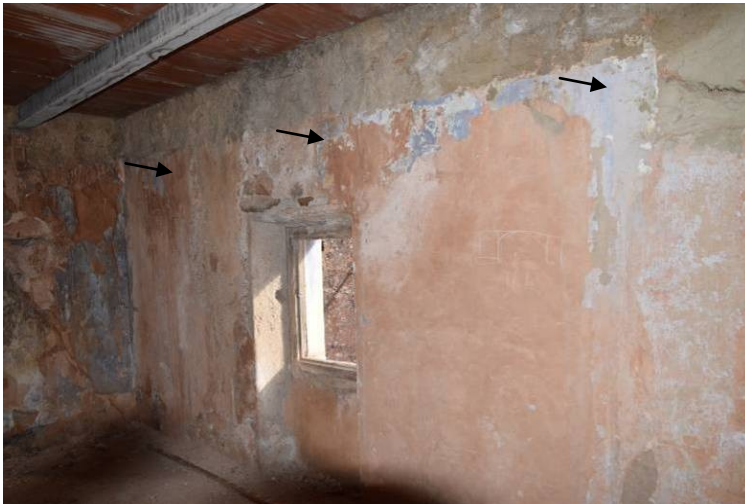
82, 83. Detall de la paret de façana sud E2, amb la finestra P20 de manera general i en detall. La part ombrejada sense pintura vermellosa correspon a la posició del trespòs original del pis de golfes, substituït per un de fornigó (indicat amb fletxes).
