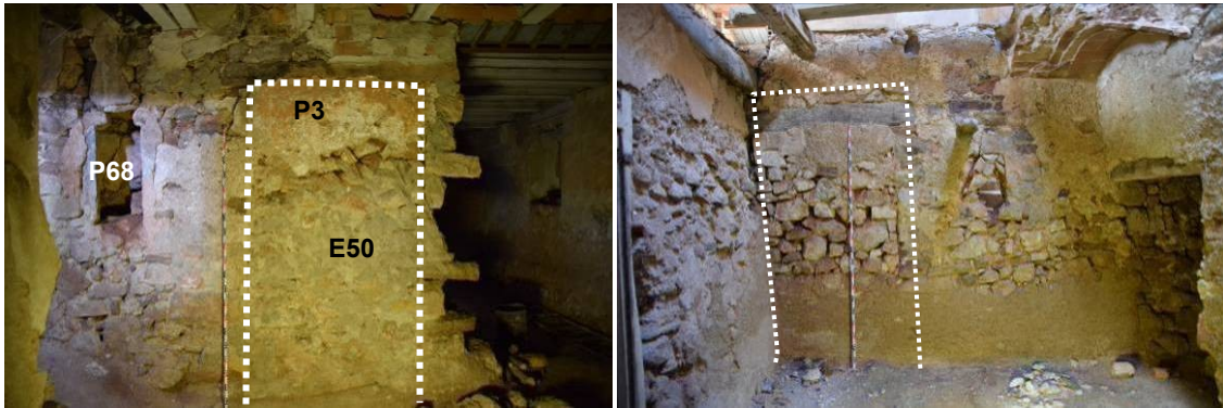
27, 28. Esquerra: detall de la façana lateral E6 des de la cara W, on s'obria originalment la porta P3 (tapiada posteriorment amb maçoneria –E50-) i una petita fornícula en la cara interna –P68-. Dreta: detall de l'E6 des de l'exterior/E, l'àmbit BIII, on es pot veure la llinda de fusta de la porta tapiada P3 (porta indicada amb trama).
