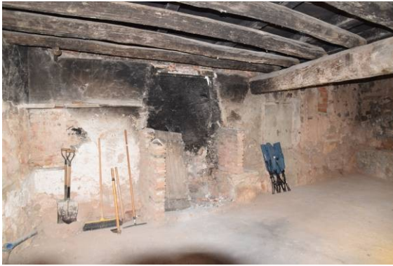
55, 56. Detall de la façana oest E21 des de l'interior de l'àmbit X, a nivell de planta baixa (esquerra) i pis (dreta), amb la finestra tapiada P16.
