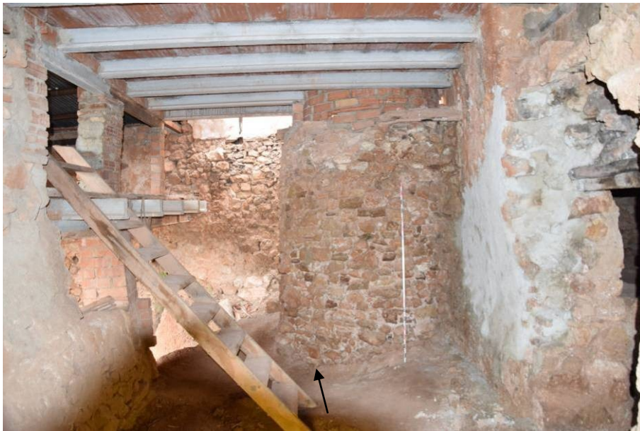
35. Vista de la zona del celler de l'àmbit BVI nord, on es pot veure a la dreta la porta d'accés directe des del vestíbul –P8- i al fons l'estructura externa de maçoneria del cup circular E15 (indicada la posició de la caixa).
