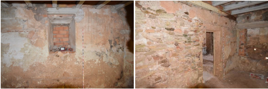
74, 75. Esquerra: detall de la façana sud E2 amb la finestra P52 actualment tapiada. Dreta: detall de l'envà E8 que separa els àmbits BII i BIII, amb la porta P4.
