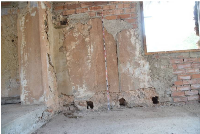
62. Detall de l'angle SW de la façana a l'àmbit PVI, on es pot veure el negatiu de l'embigat original de la casa, sobre el que recolzava el paviment del primer pis. La paret occidental E20 ha estat pràcticament refeta amb totxanes i ciment.
