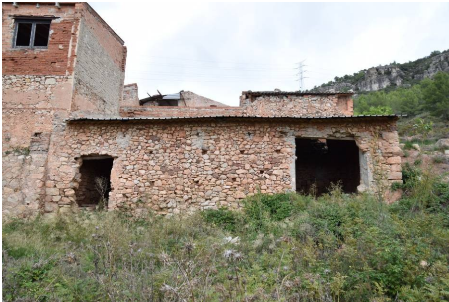
114. Vista general de la façana sud de l'àmbit XVII, amb la porta P30 a la dreta i la P31 a l'esquerra.
