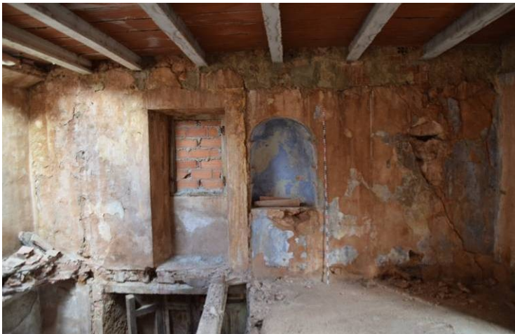
84, 85. Esquerra: Vista general de la paret oriental de l'àmbit PIII i PII a la seva dreta, amb l'armariet tipus fornícula P21 i la finestra P22, oberta a la façana de l'àmbit PIV al seu costat esquerre. Dreta: detall de l'armariet encastat tipus fornícula P21 i de l'empremta de l'envà enderrocat (indicat) que dividia els àmbits PII i PIII.
