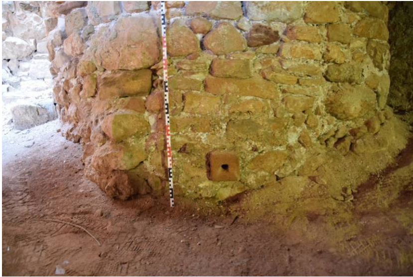
38. Detall de la cara sud del cup, on es pot apreciar la posició de la boixa per a la sortida de líquids
