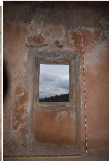
82, 83. Detall de la paret de façana sud E2, amb la finestra P20 de manera general i en detall. La part ombrejada sense pintura vermellosa correspon a la posició del trespòs original del pis de golfes, substituït per un de fornigó (indicat amb fletxes).
