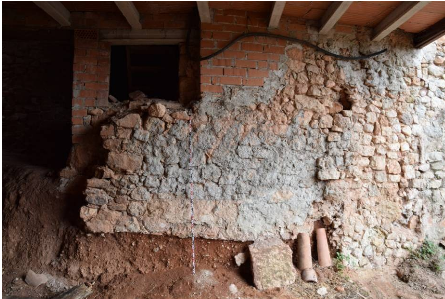
46. Detall de la paret est de l'àmbit BIX –E20-, que el separa de l'àmbit VI. Es pot veure el rebaix que de la cota original, feta amb mitjans mecànics per l'anterior propietari.
