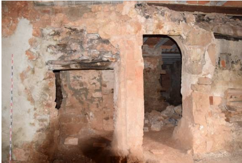
26. detall de les portes de la paret esquerra/W des de l'àmbit BVI –E13-; a la dreta la P7 i a l'esquerra la porta de poca alçada P8 amb llinda de fusta.
