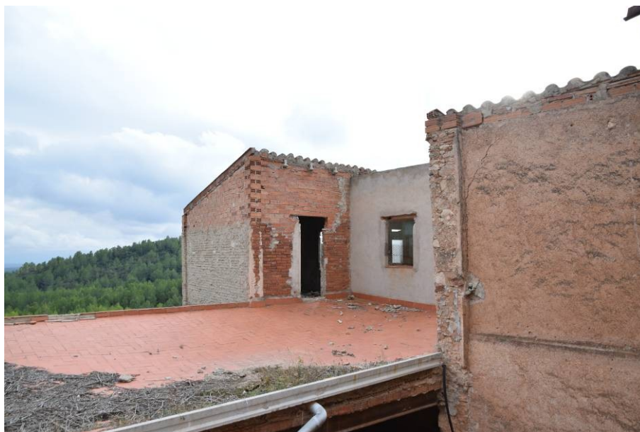
136. Detall del pis superior dels àmbits XIV i XVI. És visible la finestra P60, oberta a la façana E de l'àmbit XIV, i la porta d'accés a l'àmbit XVI –P57- accessible des de la coberta de l'àmbit XIII, habilitada com a terrat. Són visibles les reconstruccions/reformes recents fetes amb totxanes i ciment.
