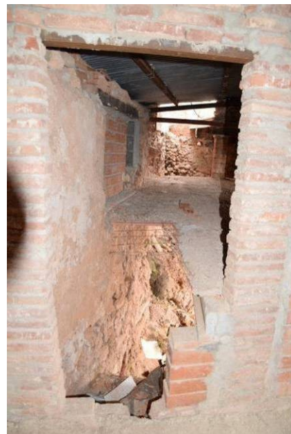
49, 50. Detall del primer pis de l'àmbit IX, on es pot apreciar com el nou forjat va anul·lar el llindar de l'obertura nord P45 i parcialment la porta que connectava amb l'àmbit PX, la P44 (a la dreta).
