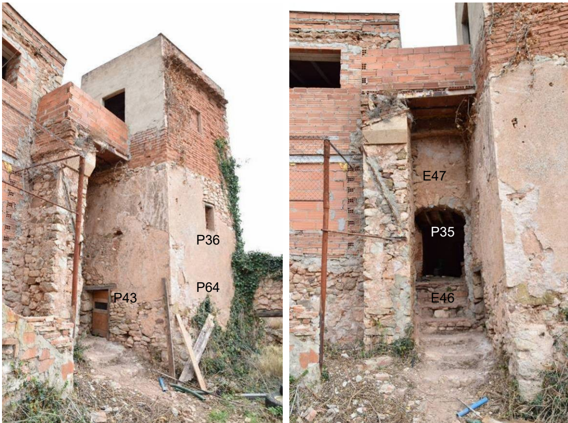
123, 124. Esquerra: Vista general de l'àmbit XIV, amb la porta d'accés a l'espai soterrani P43, i en la cara W els finestrals de la planta baixa en la part superior –P36- i del soterrani en la inferior –P64-. Dreta: detall de la paret que tanca l'espai entre els sectors A i B en la façana occidental del conjunt, deixant un petit passadís-espai d'accés a la zona baixa, definit per l'arc P35 i les escales E46.
