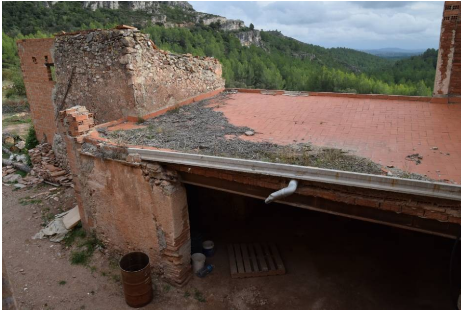
130. Detall de la coberta de l'àmbit XIII, transformada a finals del segle XX en un terrat.
