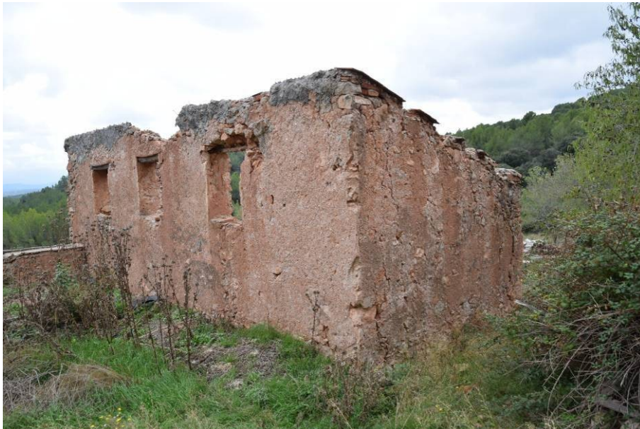
132. Detall de la façana E amb el tram de façana N a la dreta. Es pot veure la inclinació conservada de la coberta a un vessant, i les finestres més altes que amples P39, P40 i P41 (de dreta a esquerra).
