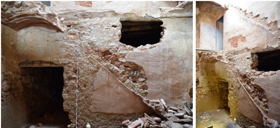
78, 79. Detall de la paret nord E9, on es pot veure la porta P5 d'accés a l'àmbit BIV (a l'esquerra), i les restes de les escales d'accés al primer pis i a les golfes sobre volta catalana -E27-. També restes del trespòl amb sistema de bigues i revoltons.
