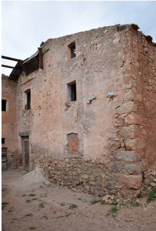
13, 14. Vista general i de detall de la façana principal E1. Esquerra: el cos/àmbits del costat dret, actual cantonada, corresponen a una ampliació posterior. Dret: Visible el parament de maçoneria, i també la porta principal d'accés –P1- construïda originalment amb muntants de carreus i llinda de fusta.
