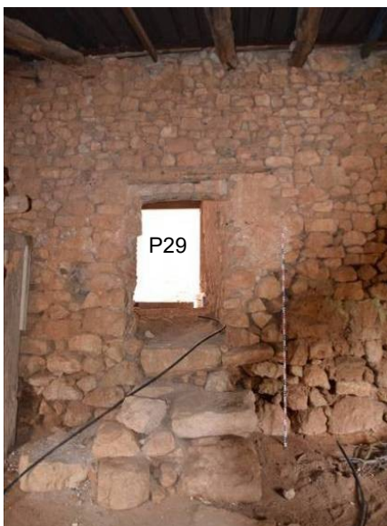
117, 118. Detall de la porta P29 des de l'interior (esquerra), on es pot veure el sistema d'esglaons fets amb grans blocs de pedra, i des de l'exterior de l'àmbit XVII a la foto dreta.
