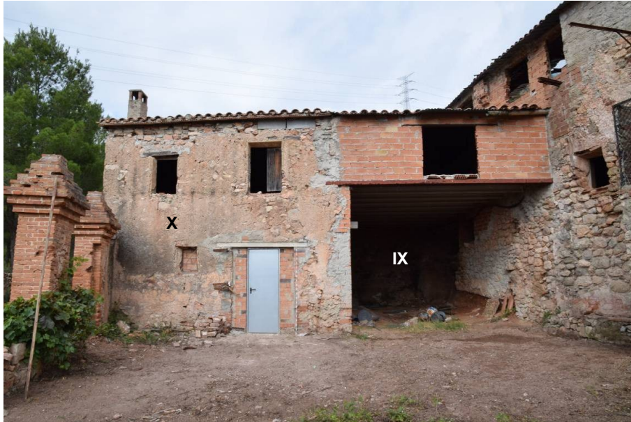
44. Vista general dels àmbits situats en l'extrem occidental, a una cota inferior pels condicionants del terreny. A l'esquerra l'àmbit X, a la dreta el IX, molt alterat per les darreres reformes.
