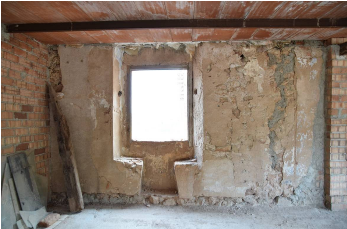
65. Detall de la finestra amb festejador P19 que presideix l'espai de l'àmbit PI, construïda de manera solidària a la façana E1.
