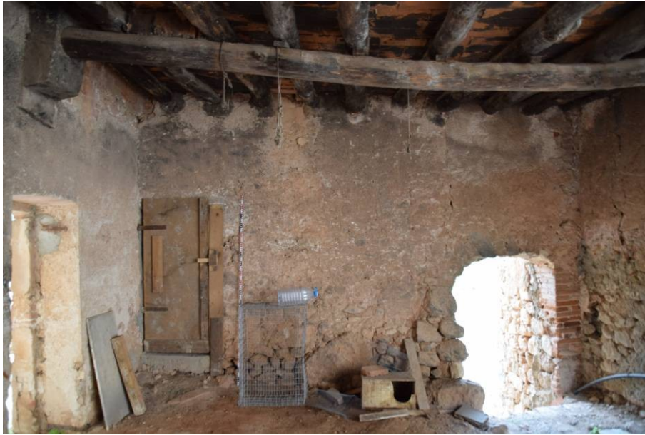
125. Detall de la paret E47, on s'obre de manera solidària la porta P33 que dona accés a l'àmbit XIV P33 (esquerra) i el pas a l'exterior-zona baixa dels sectors A i B: l'arc rebaixat P35.
