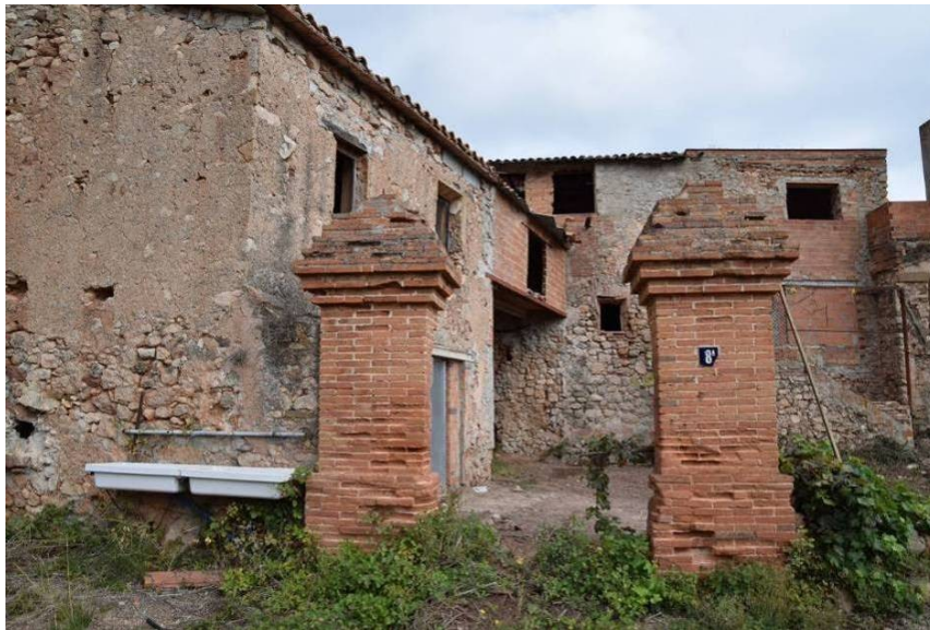
101. Detall de la tanca perimetral pel sector W, amb la portalada d'accés emmarcada pels dos grans pilars motllurats de maons plans.
