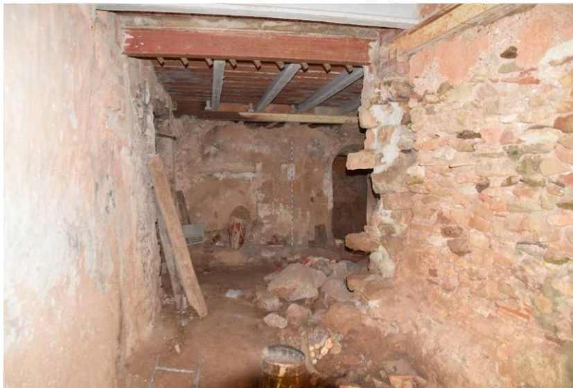
73. Detall de l'accés a l'àmbit BII des del vestíbul –àmbit BI-, on actualment es troba la paret de tancament –antiga façana lateral E6- totalment enderrocada. A la dreta l'envà E8 que separa els àmbits BII i BIII.
