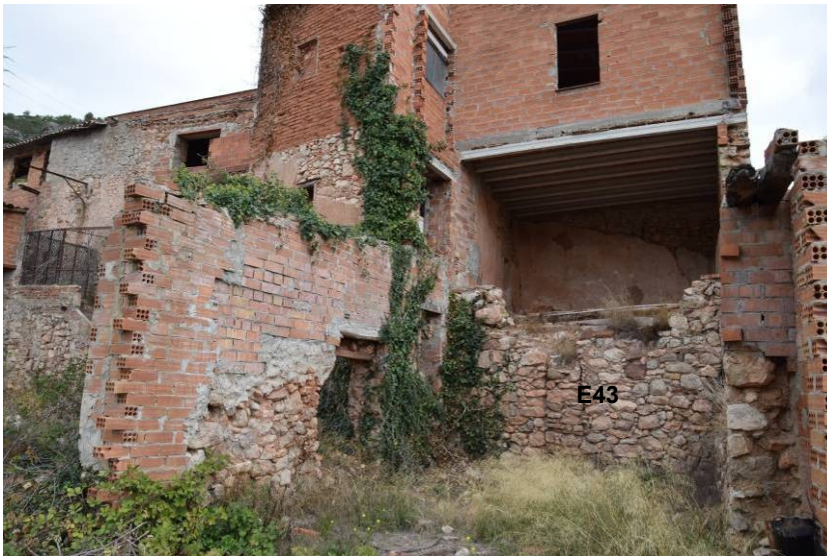
120. Detall de l'àmbit XVI. El tram superior de la paret per la cara W-E42- gairebé no es conserva, però sí el tram inferior que reforça l'estructura del cup E44, una paret a mode de contrafort/talús -E43-, també visible en la cara sud.
