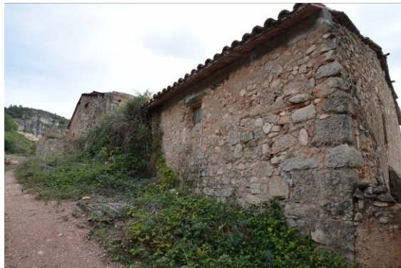
59, 60. Vista general i detall dels àmbits IX i X des del costat nord (esquerra) i a l'angle NW, on destaquen els carreus i grans blocs de reforç cantoner.
