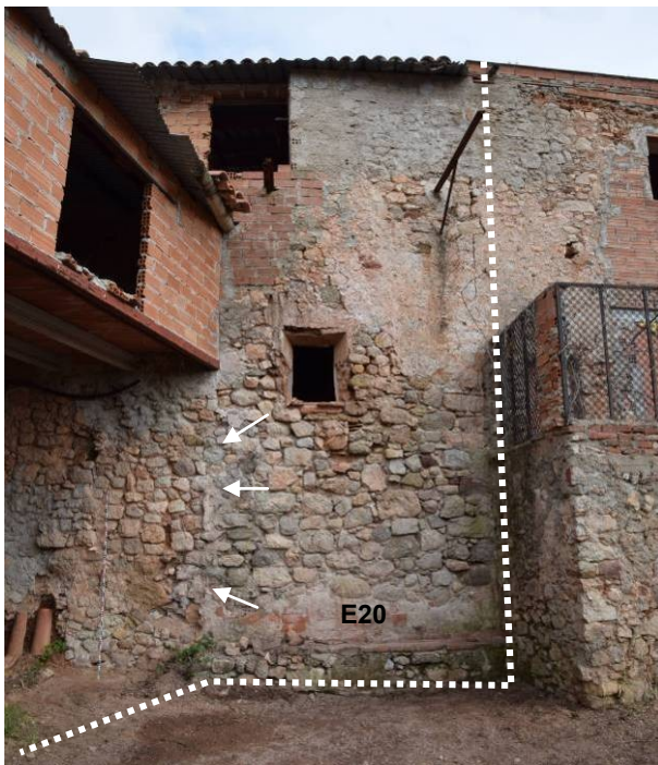
17. Detall del reclau de la façana meridional, amb el mur de contenció E20 que delimita els àmbits de la zona elevada en primer terme. Indicada l'empremta del tancament original de la façana sud de la part baixa –E24-, desmuntada en aquesta zona en les reformes que va fer l'anterior propietari, i en discontinu el traçat original. A la dreta el cos afegit de l'àmbit VII durant una reforma.
