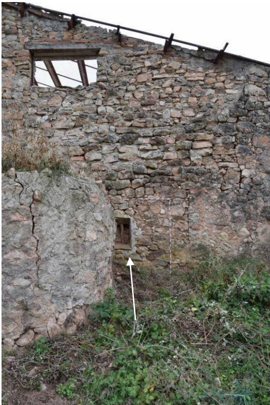
31. Detall de la façana posterior E7 a l'alçada de l'àmbit BV, on es pot veure la finestra P65 amb el forn E10 afegit en una reforma posterior.
