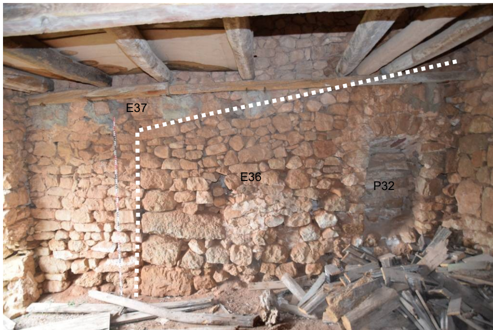
113. Detall de la paret de maçoneria de la primera fase E36, que definia un espai cobert en origen més curt i de menor alçada, amb l'armariet/fornícula P32. Es va mantenir com a fonament de la paret E37, construïda quan es fa l'actual cobert de l'àmbit XVII. Indicada la línia de la coberta original i el límit sud/esquerre.
