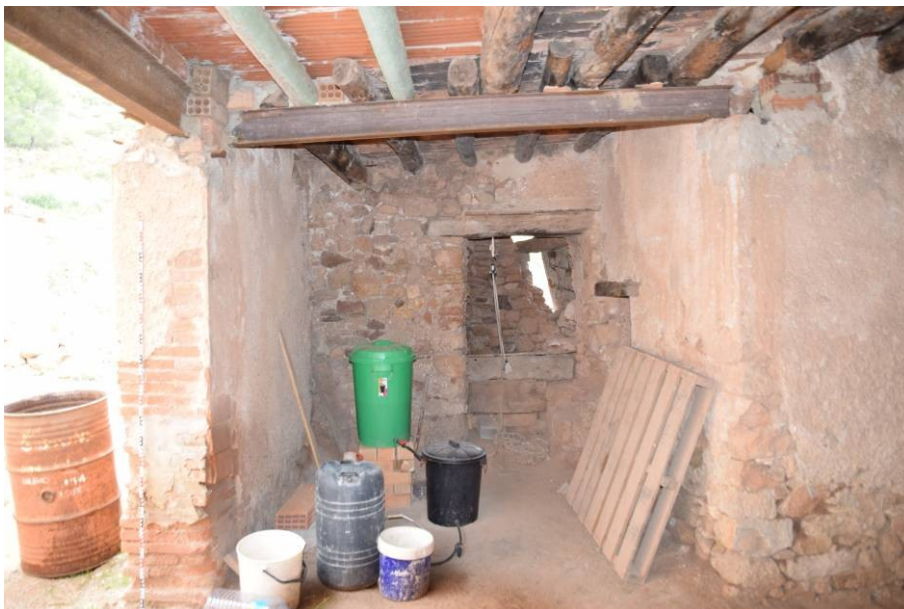
129. Vista interior del cobert que forma l'àmbit XII, amb el pou -àmbit XI- al fons, i la paret amb pilar de maons a l'extrem E16 a l'esquerra. Es pot veure la coberta, substituïda parcialment per bigues de ferro, formigó i peces ceràmiques en data recent.
