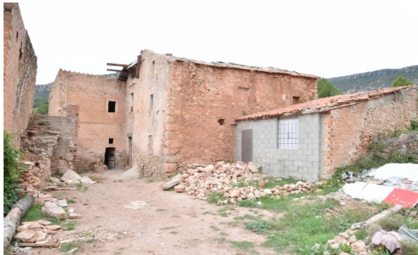
12. Vista general de la zona d'accés a Cal Batllet, amb les construccions del sector A a la dreta, i les del sector B a l'esquerra. Entre ambdues l'àmbit adossat durant una reforma a la façana principal del sector A, l'àmbit VII.
