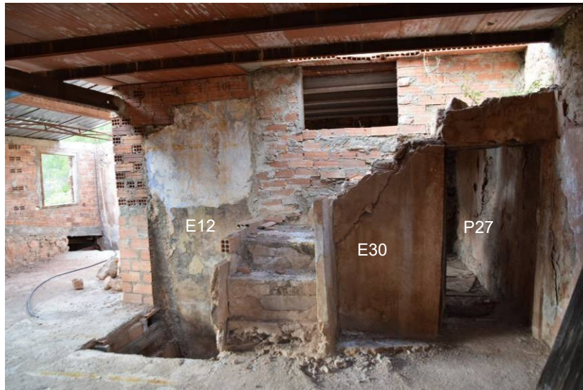
63. Detall de l'escala E30, amb el tram d'accés a les golfes que es conserva, vista des de l'àmbit PI. Al fons l'envà de separació amb l'àmbit PV codificat com E12, on s'obre una porta de connexió entre ambdós espais -P27- a la dreta. Està força reconstruït en data recent amb totxanes i ciment.
