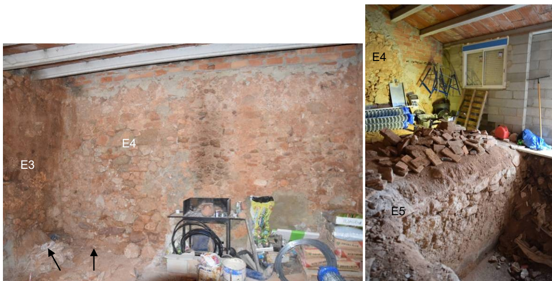
99, 100. Esquerra: tancament N de l'àmbit VIII, amb la façana E3 a l'esquerra; indicats els punts on la roca està aprofitada com a banqueteta. Dreta: detall de l'actual façana sud i l'angle amb la paret lateral nord –E4–, i la fossa sèptica E5 en primer terme.
