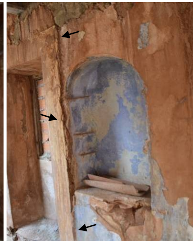
84, 85. Esquerra: Vista general de la paret oriental de l'àmbit PIII i PII a la seva dreta, amb l'armariet tipus fornícula P21 i la finestra P22, oberta a la façana de l'àmbit PIV al seu costat esquerre. Dreta: detall de l'armariet encastat tipus fornícula P21 i de l'empremta de l'envà enderrocat (indicat) que dividia els àmbits PII i PIII.
