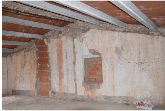
55, 56. Detall de la façana oest E21 des de l'interior de l'àmbit X, a nivell de planta baixa (esquerra) i pis (dreta), amb la finestra tapiada P16.
