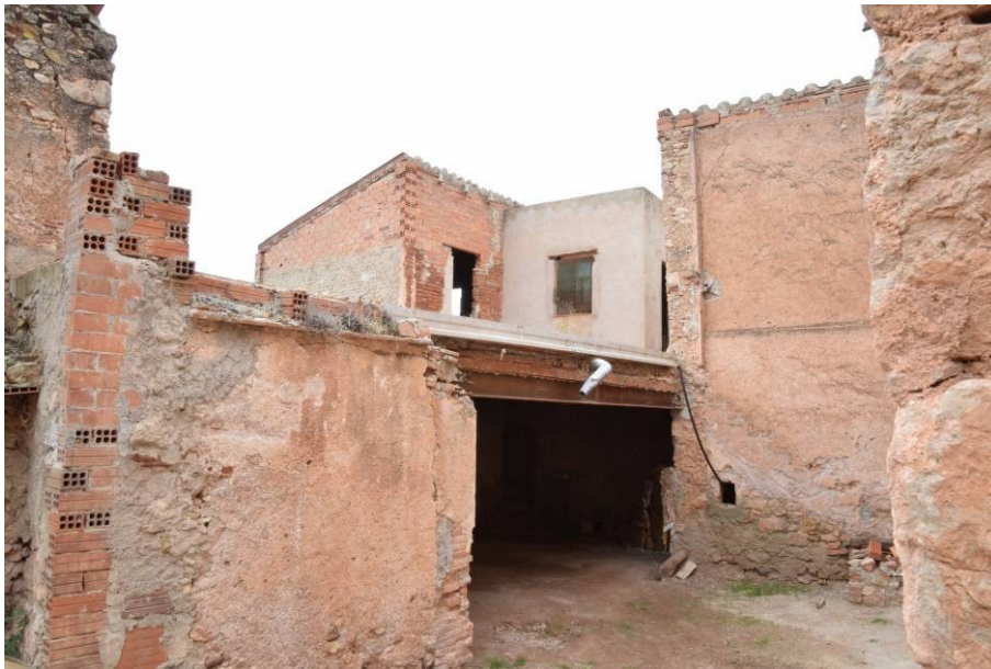
128. Vista de la zona d'accés al cobert de l'àmbit XII. A l'esquerra la paret que s'adossa al pou amb pilar de maons a l'extrem -E16- i a la dreta l'àmbit VII, que actua com a límit occidental de l'accés.
