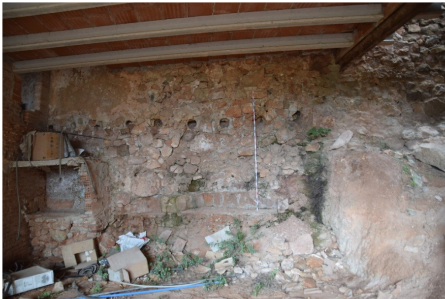
45. Detall del límit nord de l'àmbit BIX-E7-, on és visible el negatiu de l'embigat desmuntat sobre el que es trobava el trespol original de l'estança. Recentment va ser substituït per un nou forjat, que es va disposar vora 1 m per damunt de l'original.
