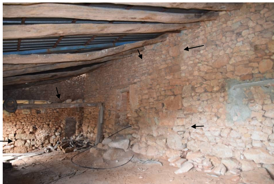
115. Detall de l'interior de l'àmbit XVII. A la dreta es pot veure la junta on recolza la nova paret de maçoneria E38 damunt l'estructura preexistent de l'àmbit XII (indicat), i a l'esquerra la paret E37 sobre el mur de la fase anterior E36 (també indicat).
