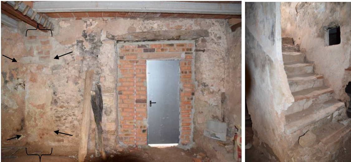
23, 24. Esquerra: detall de la façana E1 des de l'interior de l'àmbit I, on es veu l'estructura interna de la porta amb llinda de fusta P1. A l'esquerra, les fletxes indiquen la zona de l'angle/tancament original, desaparegut quan es desmunta aquest pany de l'E6. Dreta: detall de l'arrencament de l'escala E30.
