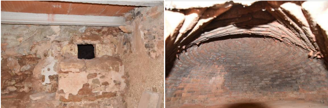
91, 92. Detall de la boca del forn oberta al mur E7 durant la segona fase i de l'estructura interior, amb coberta de cúpula feta amb rajoles ceràmiques.
