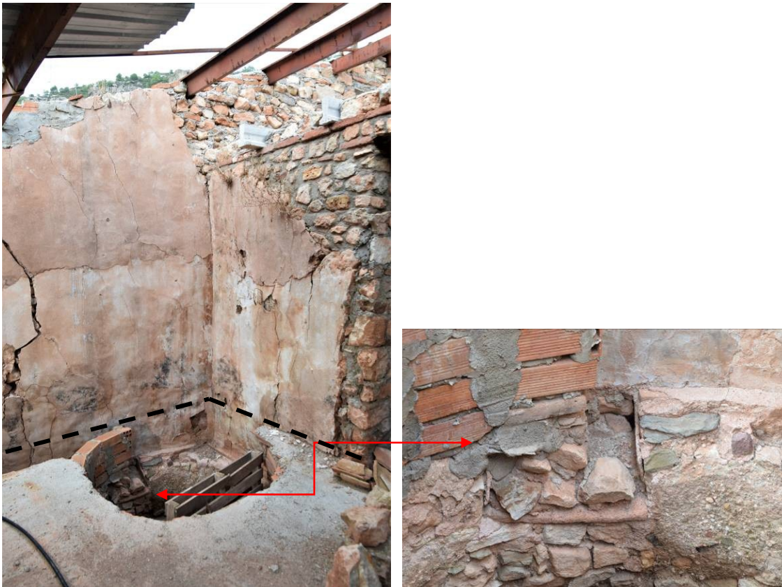
40, 41. Vista general de l'actual part superior del cup E15 en el primer pis, amb la part superior refeta quan es fa l'actual trespol de bigues de formigó. A la dreta detall del punt d'abocament a dintre des de l'exterior de la masia, obert de manera solidària a la construcció de la façana nord E7. Tapiat amb pedres i ciment en l'actualitat. Indicat en discontinu el nivell del trespol original, uns centímetres per damunt de l'actual.
