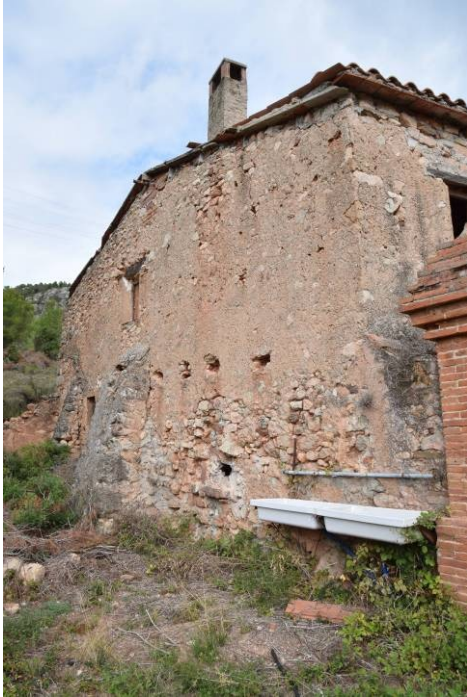
51, 52. Detall de la façana oest de l'àmbit X, on es poden veure les finestres de la planta baixa i els contraforts E22 i E23. Destaca el reforç de carreus i grans blocs de la cantonada NW.
