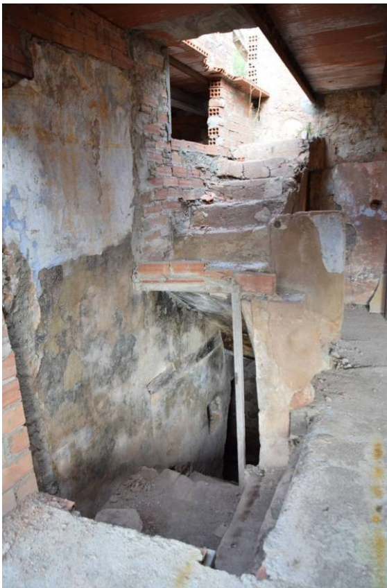
66, 67. Esquerra: detall de l'escala que connecta la planta baixa amb el pis i les golfes, molt refeta en època recent. Dreta: Detall de l'àmbit PVI amb la part superior del cup E15, refet fins la cota de l'actual forjat amb totxanes i ciment, anul·lant la boca superior d'entrada de líquids. A la seva dreta la porta d'accés a l'àmbit PV.
