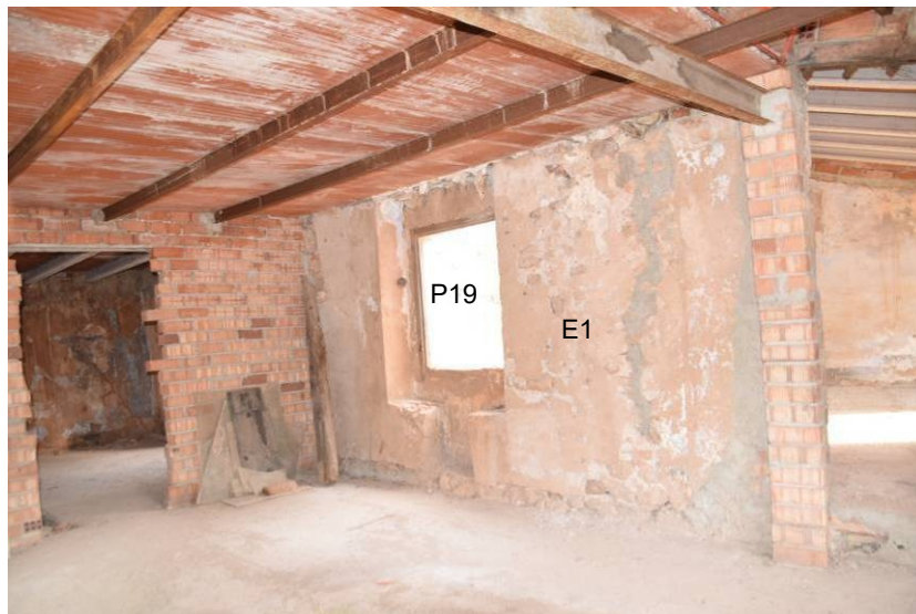
64. Vista general de l'espai situat sobre l'àmbit I. A la part central la finestra amb festejador de la façana P19, i a l'esquerra la paret de totxanes i ciment construïda en la darrera reforma a finals del segle XX.
