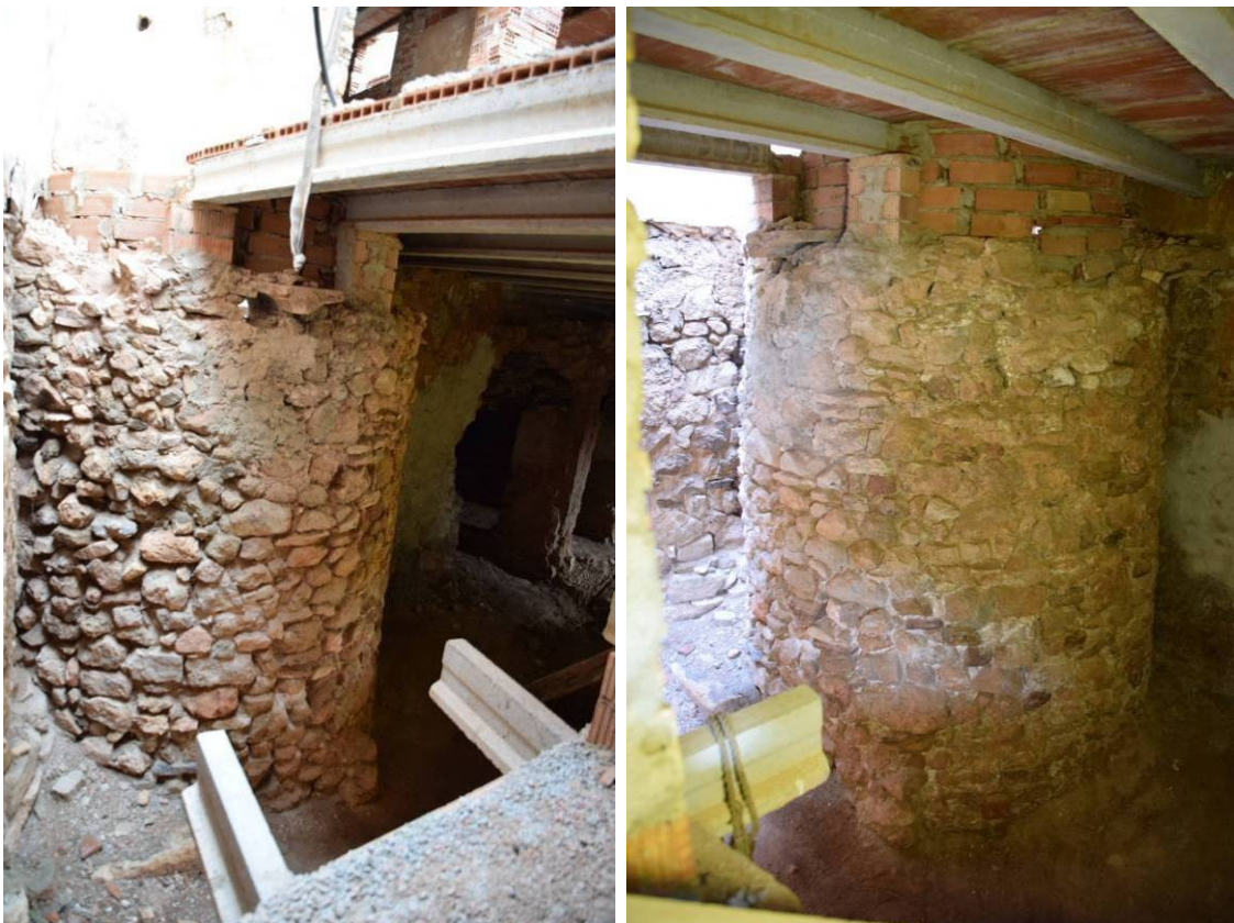
36, 37. Vista de l'estructura conservada del cup circular E15 des del costat oest (esquerra) i sud-oest (dreta). La part superior va ser refeta amb una obra de totxanes i ciment quan l'anterior propietari va fer les últimes reformes, per recolzar-hi el nou forjat de bigues de formigó.
