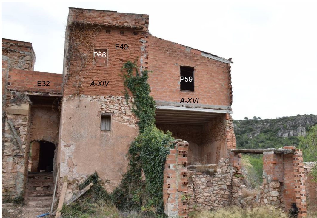
135. Detall de la façana sud dels àmbits XIV i XVI, amb els recrescuts del pis superior obrat en maons plans sobre els murs de maçoneria precedents. A l'esquerra l'empremta de l'escala construïda per accedir al pis superior de l'àmbit XIV. A la dreta l'àmbit XVI, que presenta la façana oest i part de la sud refeta durant les reformes de finals del segle XX.
