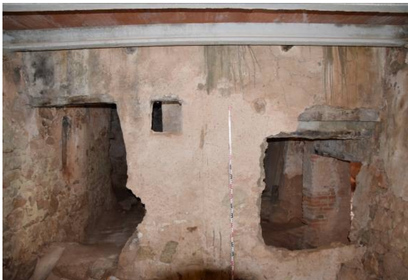
25. Detall de l'envà de maçoneria E12 vist des de l'àmbit BV, amb la porta P46 a l'esquerra/E, i el finestral que dona al darrera l'escala P47 a la dreta/W.
