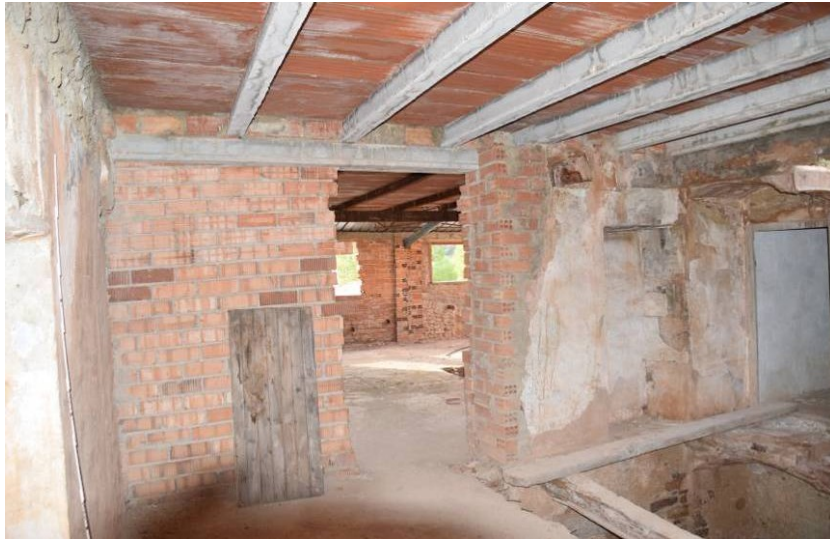
81. Detall de l'àmbit PII amb la paret occidental al fons, pràcticament refeta amb totxanes i ciment durant la reforma de finals del segle XX. A la dreta el tram de paret de maçoneria original E6 que es conserva.
