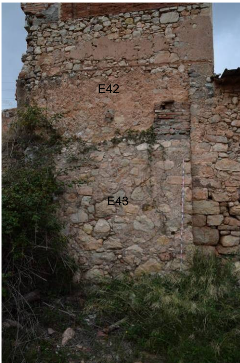
121, 122. Esquerra: detall de l'àmbit XVI per la cara sud, amb el tram de reforç en talús/contrafort E43 en la part inferior. Dreta: detall de l'interior de l'àmbit XVI, amb la zona de la trapa d'accés al cup en el centre, ja tapada amb ciment pels propietaris per evitar accidents.
