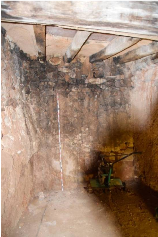
80. Detall de l'interior de l'àmbit IV, amb la paret de façana E3 al fons i la façana nord E29 a l'esquerra. Es pot veure la coberta de bigues i revoltons encara conservada.
