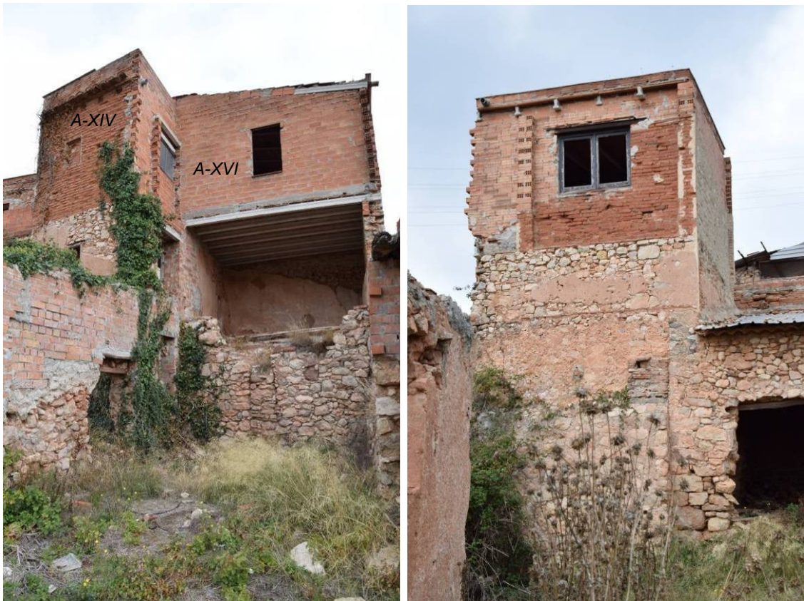
139, 140. Esquerra: detall de la cara oest dels àmbits XIV i XVI, amb el pis superior aixecat durant la reforma d'inicis del segle XX, que a finals del segle XX va ser força refeta i/o reformada. Dreta: detall de la cara sud de l'àmbit XVI, on es pot veure la façana sud del pis superior de maons –E50-, on s'obre la finestra P58; d'ambdues es conserva la part esquerra, ja que han estat reparades durant les reformes de finals del segle XX.
