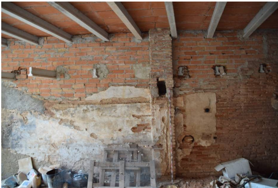
47. Detall de la paret oest de l'àmbit BIX, bastida durant la quarta fase amb maons plans. Són visibles les marques de les bigues del forjat del primer pis, desmuntat per re-aixecar-lo durant la darrera reforma de finals del segle XX. També es va refer parcialment la paret de maons plans –E25- amb totxanes i ciment.
