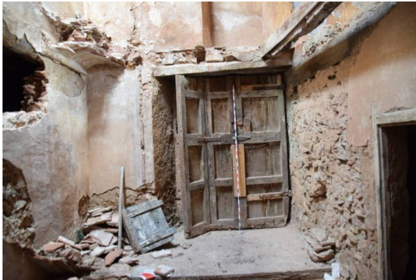
76. Detall de la porta P2, que originalment permetia l'accés directe des de l'exterior a l'àmbit BIII pel lateral est.
