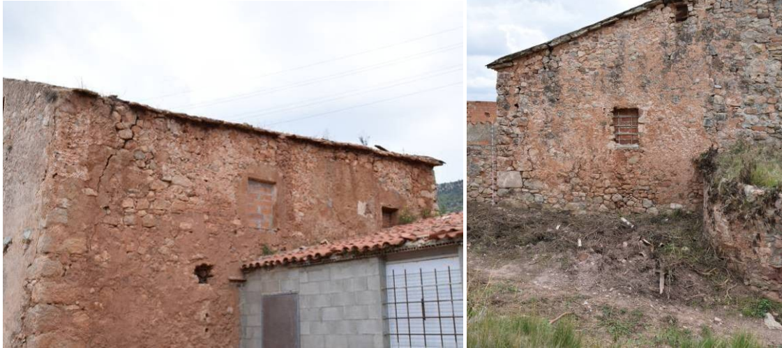
87, 88. Esquerra: detall de la façana lateral E3, on es poden veure les finestres del primer pis dels àmbits PIII –P22- a l'esquerra i del PIV –P51- a la dreta. Dreta: detall de la façana posterior, on es pot veure la finestra de l'àmbit PIV codificada com P49, actualment tapiada.
