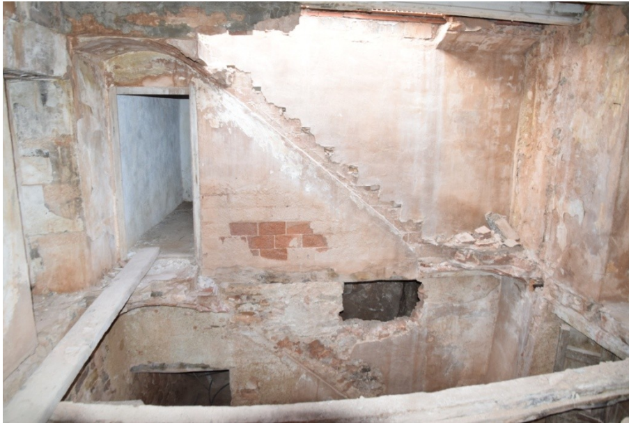
86. Detall de l'àmbit PIII amb la paret nord E28 al fons, on es troba la porta d'accés a l'àmbit PIV , i és visible l'empremta i part dels replans de l'escala en aquest nivell i a nivell de les golfes.
