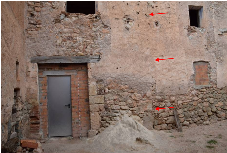
15. Detall de la façana principal E1, amb la porta P1, que presenta algunes reparacions amb maons plans. És ben visible la cantonada original reforçada amb carreus, on es recolza el tram de façana E2, ampliat durant una reforma (indicat).
