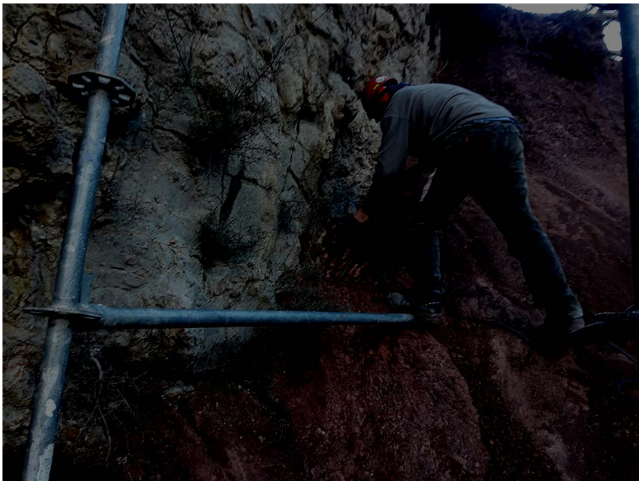
Fotografia 1 Preparació sabata de la bastida
