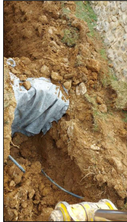
Cobertura amb geotèxtil
