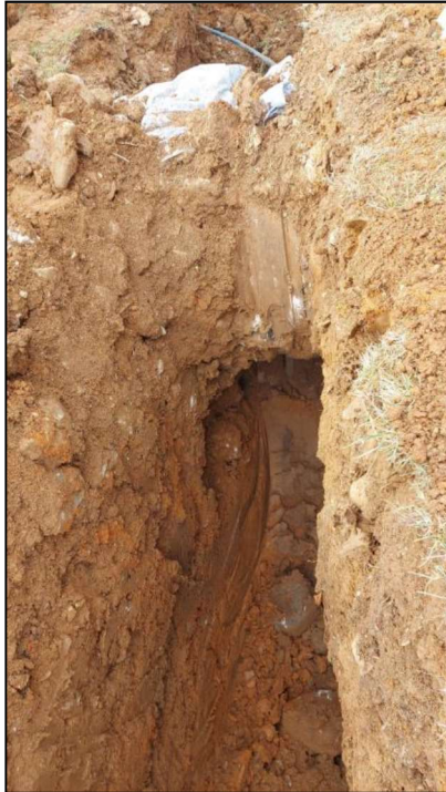
Forat per sota el mur per encabir el tub de drenatge
