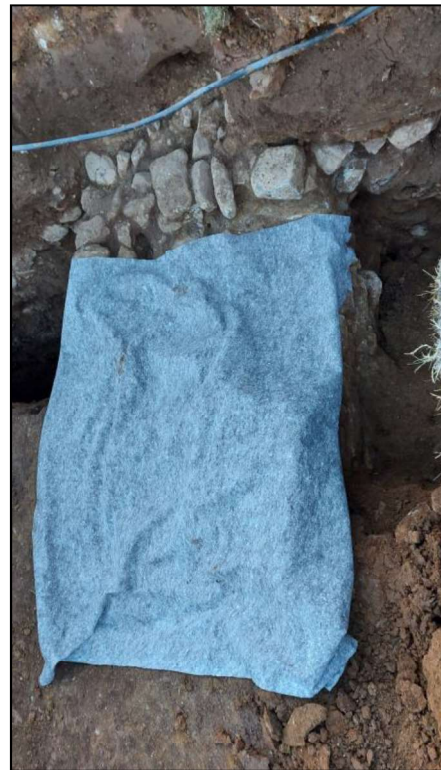
Forat per encabir el tub de drenatge sota UE 1027 i 1028 (esquerre) i cobertura amb geotèxtil (dreta)
