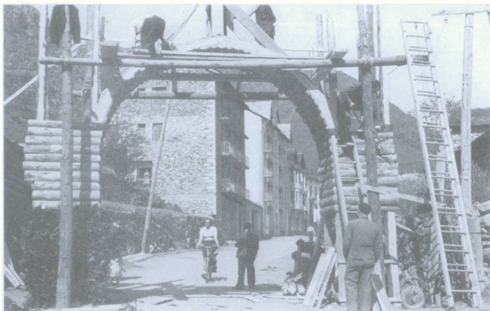
Construcció d'un arc d'autoritat: disseny i plànol de Bartomeu Rebés. (Autor Bartomeu Rebés, Casa Guillemó)
