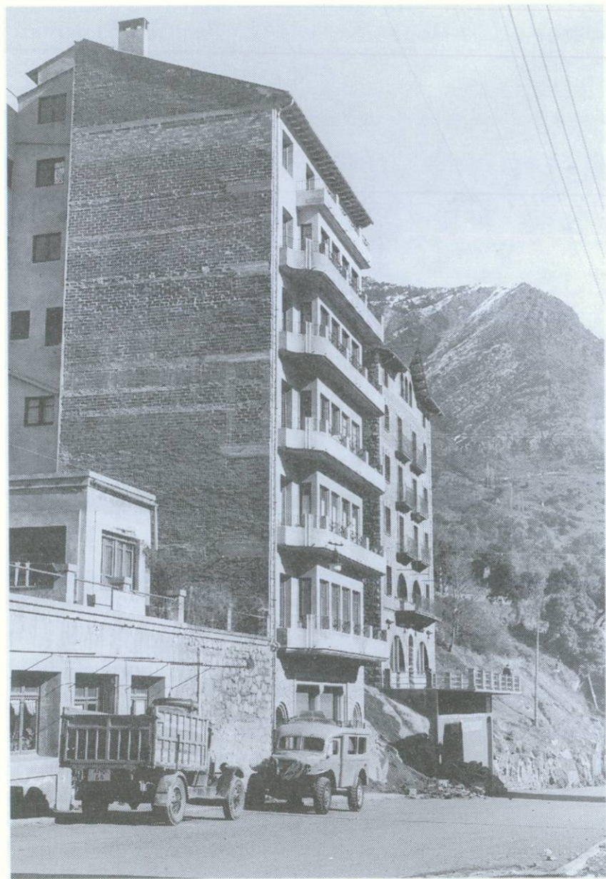
Edificació a Andorra la Vella a l'actual avinguda Meritxell. (Foto Francesc Pantebre i Arqués)
