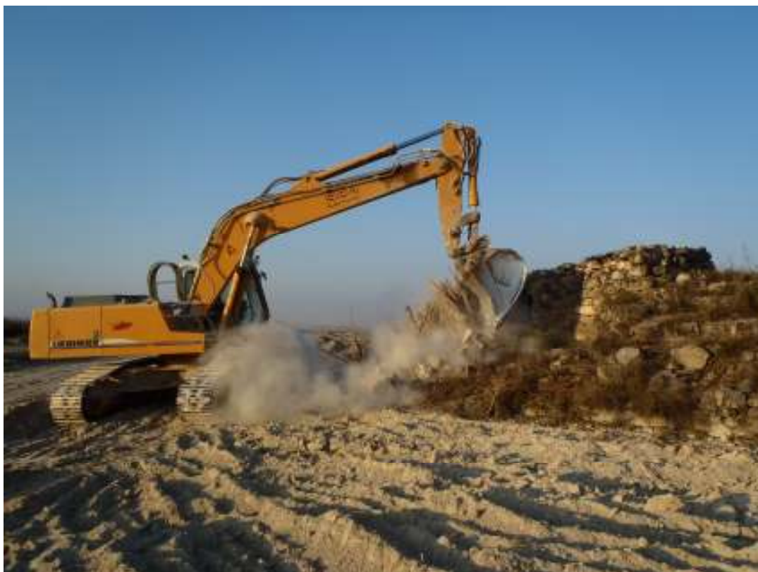
Imatge de la demolició de la cabana d'ús agrícola al PK 67+300
