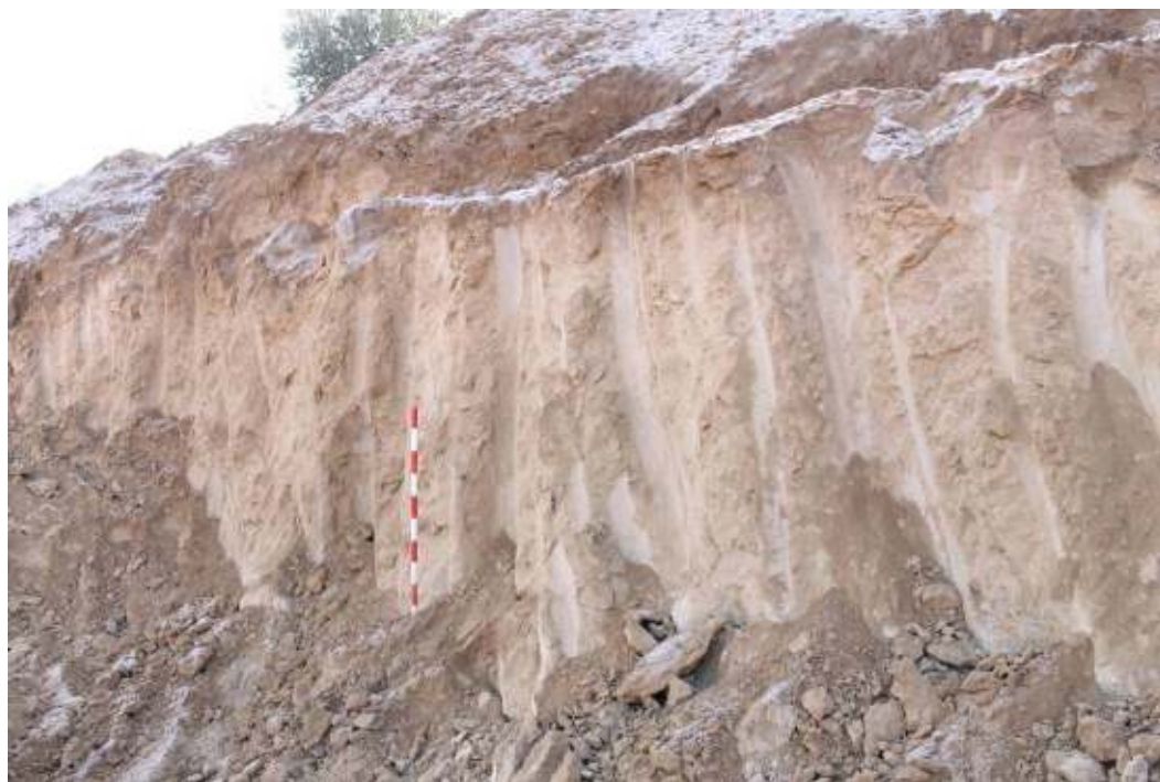
Imatge de la secció dels rebaixos de l'obra un cop extreta la capa de terra vegetal
