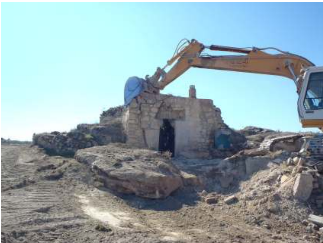
Imatge de la demolició de la cabana d'ús agrícola al PK 67+040
