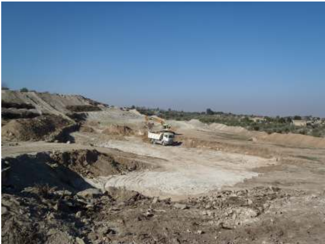
Vista dels treballs d'excavació des del PK 66+780 al PK 67+100
