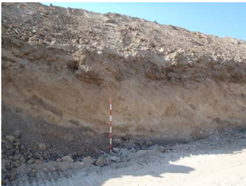
Imatge del tall de l'excavació en el PK 66+700
