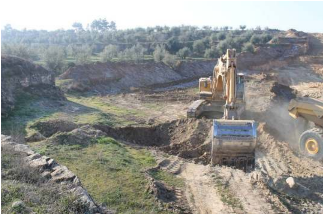
Imatge dels rebaixos de la capa vegetal amb mitjans mecànics
