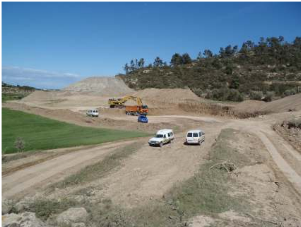
Imatge dels treballs entre els PPKK 63+220 i 63+340 i, al fons, vessant del turó de la Serrania, ja netejat, pròxim al PK 63+200
