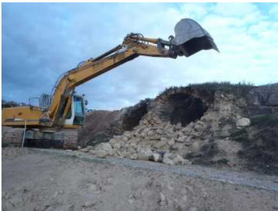
Imatge de l'enderroc de la cabana de volta del PK 78+565
