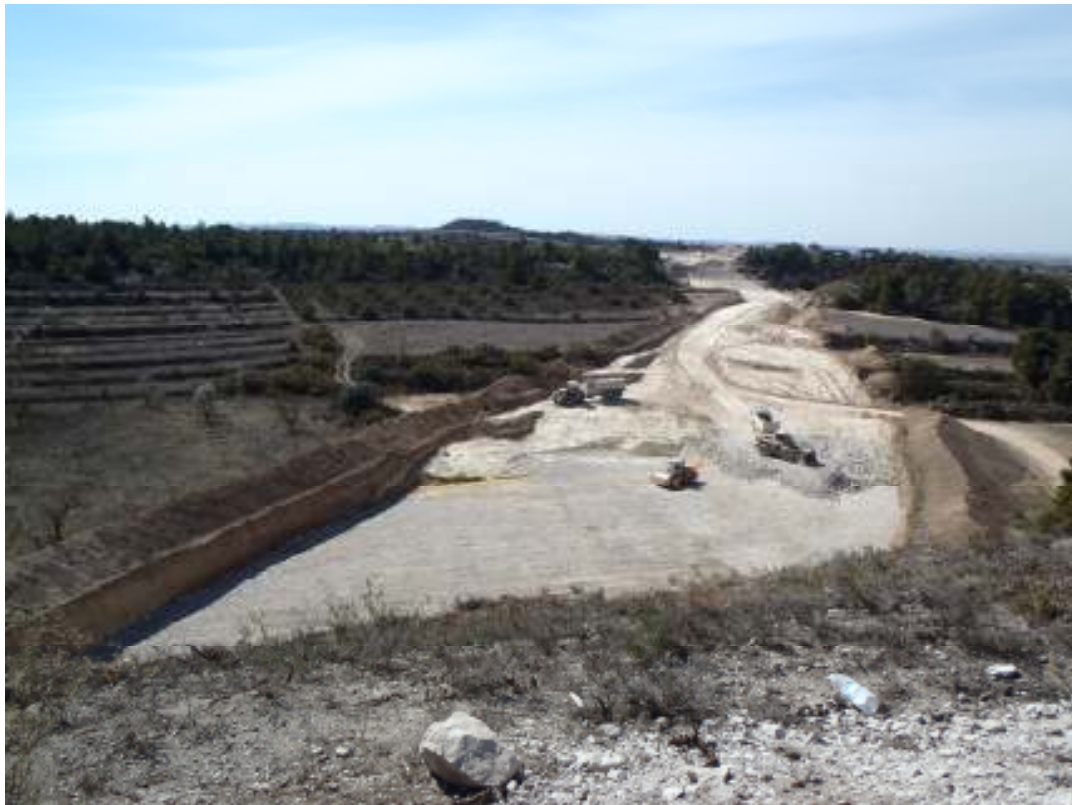
Imatge de la zona excavada sense control arqueològic del PK 65+ 080 al PK 65+700
