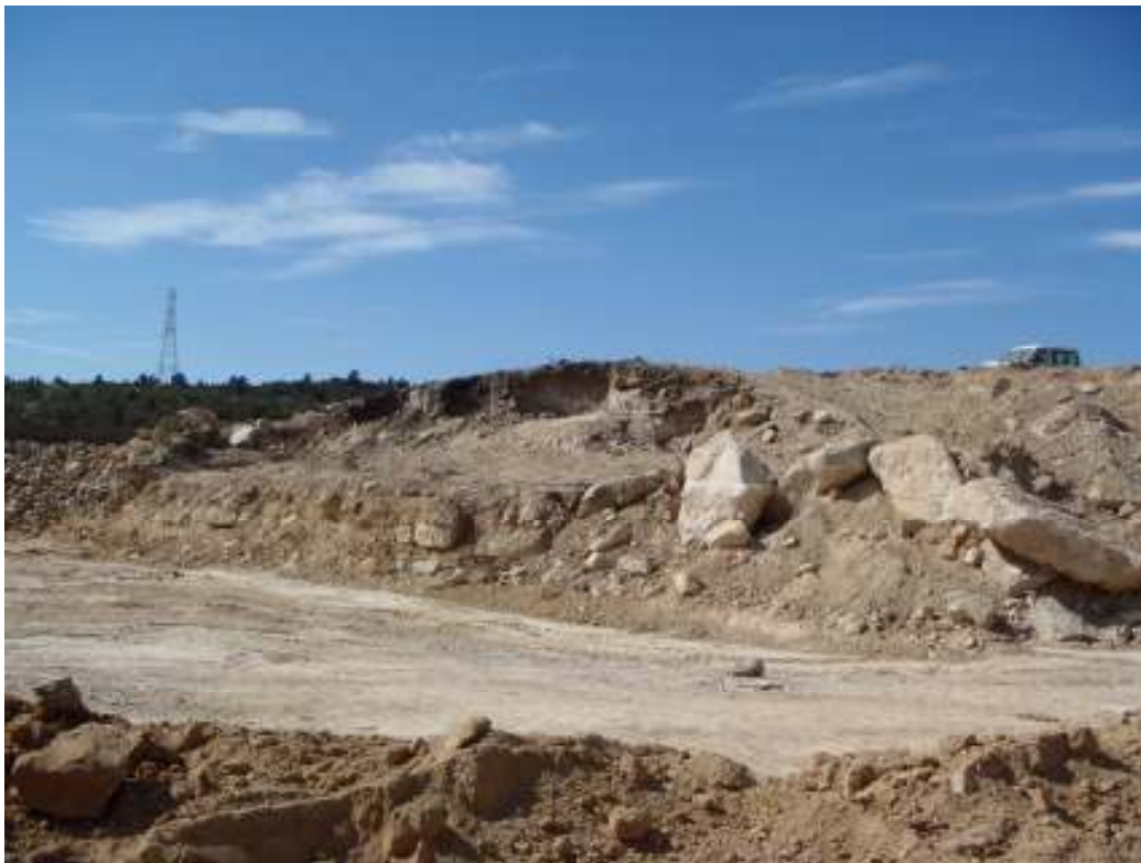
Imatge de la cabana enderrocada al PK 73+200
