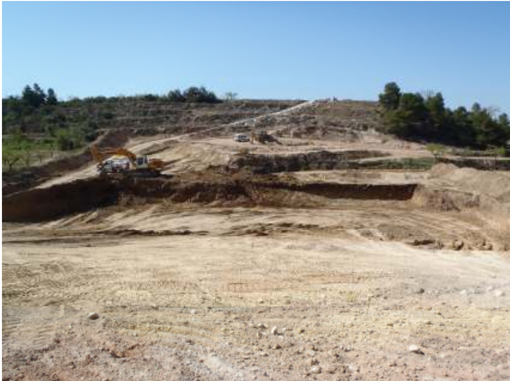
Imatge dels treballs d'excavació de la terra vegetal entre els PPKK 65+870 i 65+730
