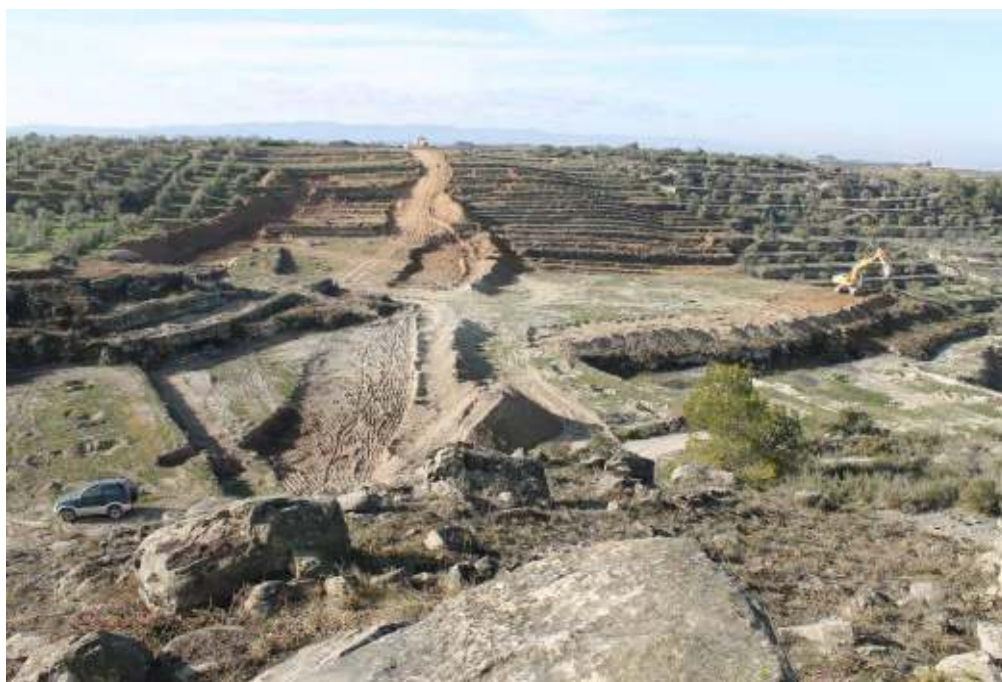
Vista general de la zona afectada, aproximadament al PK 68+535
