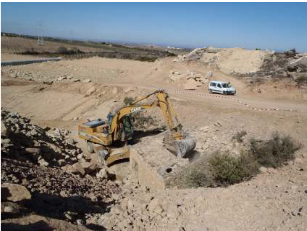
Imatge de la demolició de la cabana situada al 73+800
