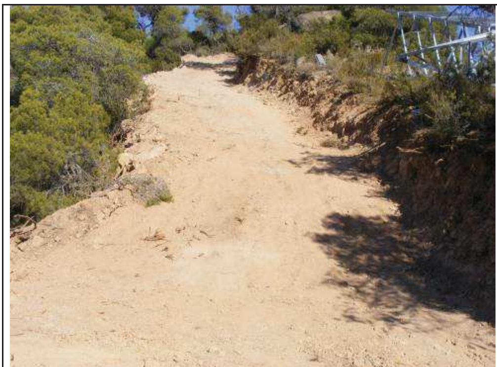
Foto 69: Suport 30, zona rebaixada per la confecció de l'accés a la plataforma.
