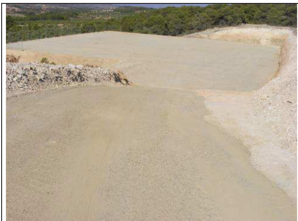
Foto 1: Zona SET Monclues, zona ja construïda.
