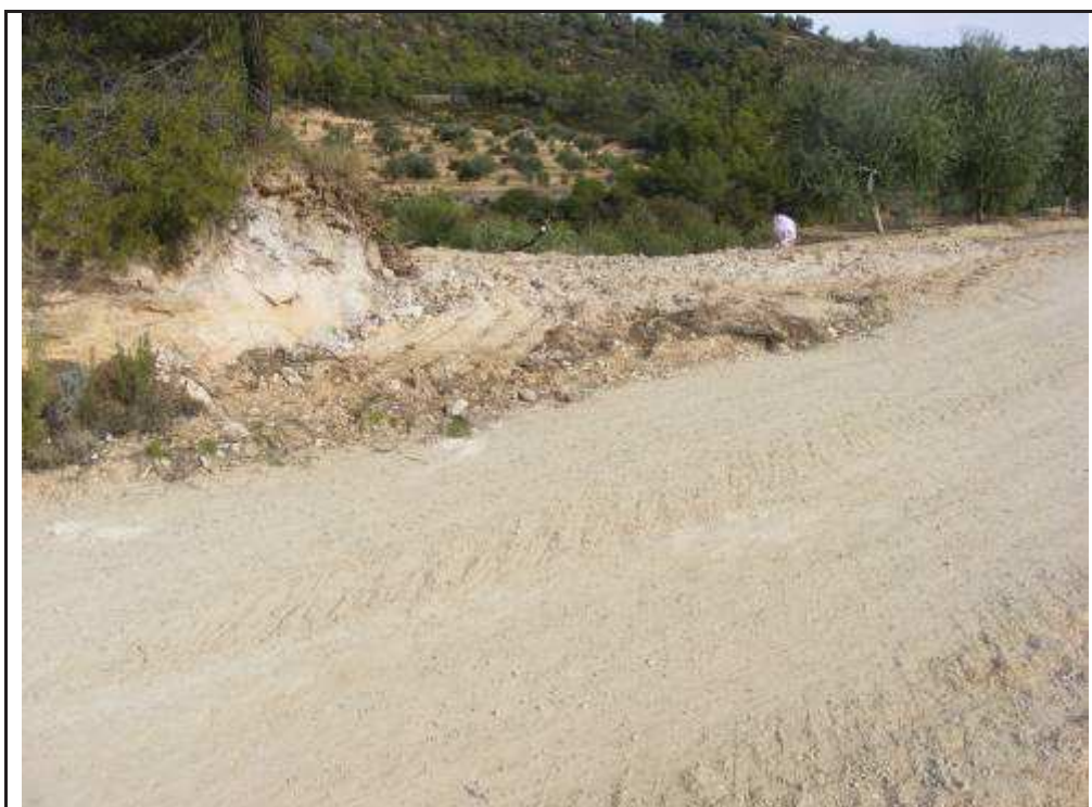
Foto 120: Suport 11, rebaixos per la realització de l'accés a la plataforma des del camí de la Vall de Sant Pere
