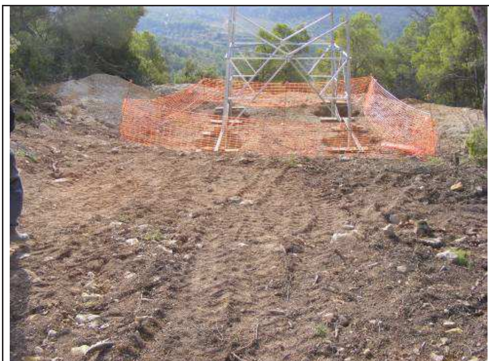
Foto 114: Suport 13, zona talada i terraplenada per la confecció de la plataforma.
