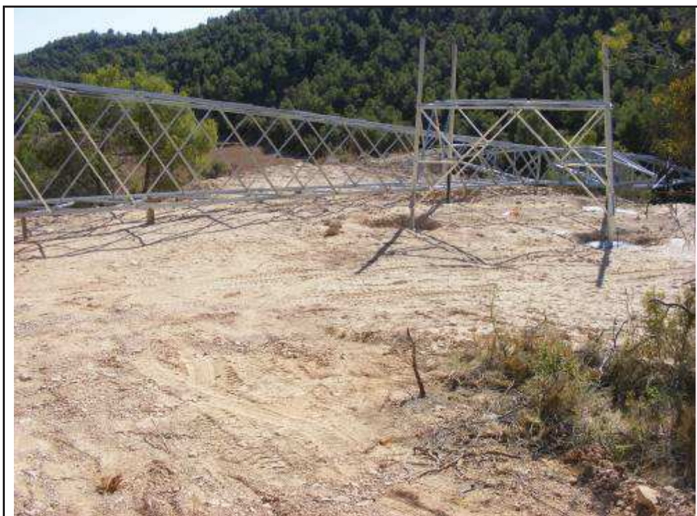
Foto 56: Suport 4, zona amb rebaixos i terraplens per la confecció de la plataforma.
