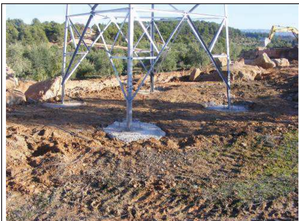
Foto 112: Suport 14, zona talada i aplanada amb l'excavació dels quatre pilars.
