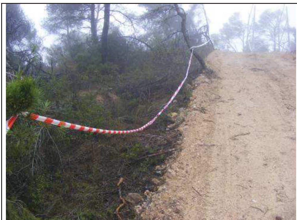
Foto 17: suport 8, terraplenament de l'accés. La trinxera queda separada amb cinta a l'esquerra de la imatge.
