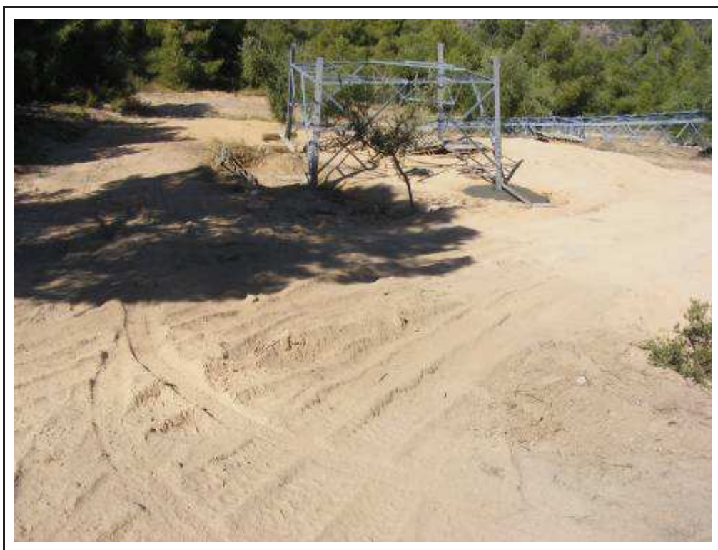
Foto 42: Suport 11, zona desbrossada per la confecció de la plataforma.
