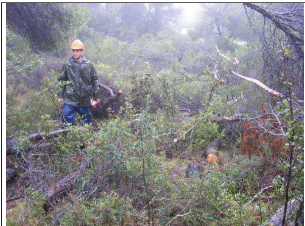
Foto 14: suport 8, delimitació de la zona amb cinta identificativa i tala de l'accés.
