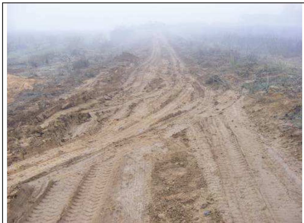
Foto 25: Suport 12, desbrossament de l'accés, zona de terrasses ermes/abandonades.
