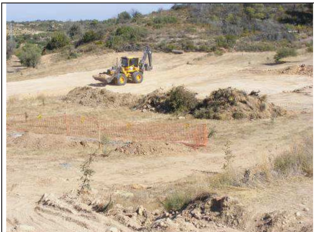
Foto 143: SET de les Rotes, desbrossament i inici dels rebaixos.
