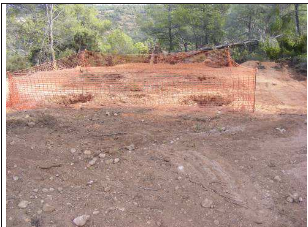
Foto 102: Suport 18, zona talada i terraplenada per la confecció de la plataforma.
