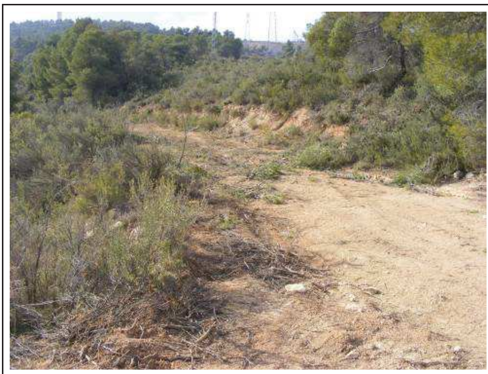
Foto 36: Zona talada entre el suport 14 i el suport 13.
