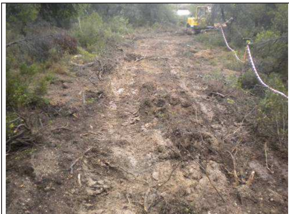
Foto 15: suport 8, desbrossament de l'accés.
