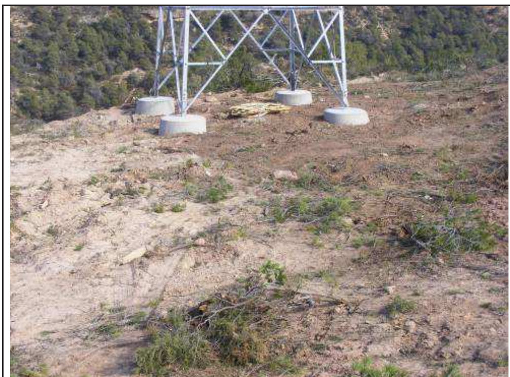
Foto 96: Suport 20, zona explanada per la confecció de la plataforma.
