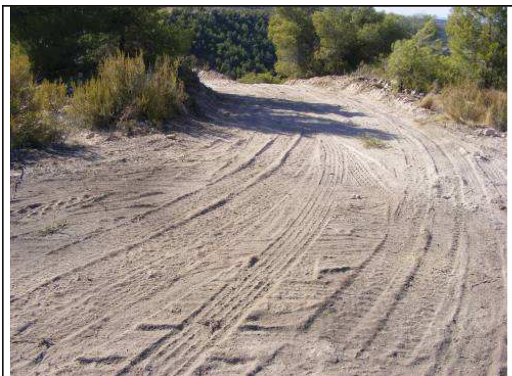
Foto 63: Suport 2, zona rebaixada per la confecció de l'accés a la plataforma.
