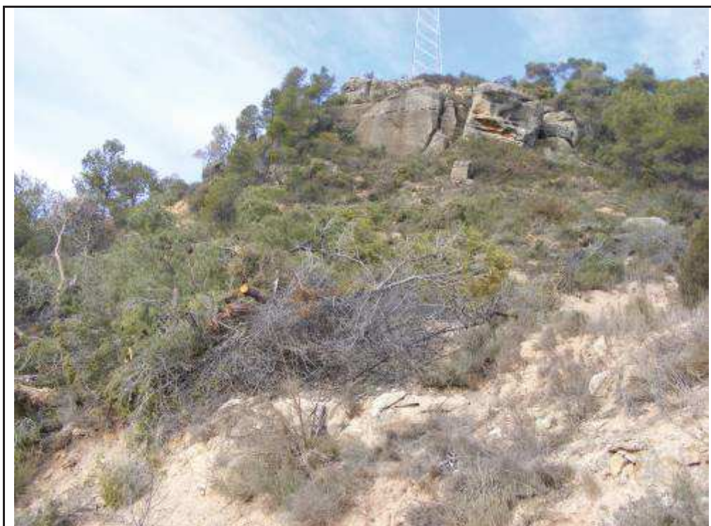
Foto 77: Zona talada entre el suport 27 i el suport 26.
