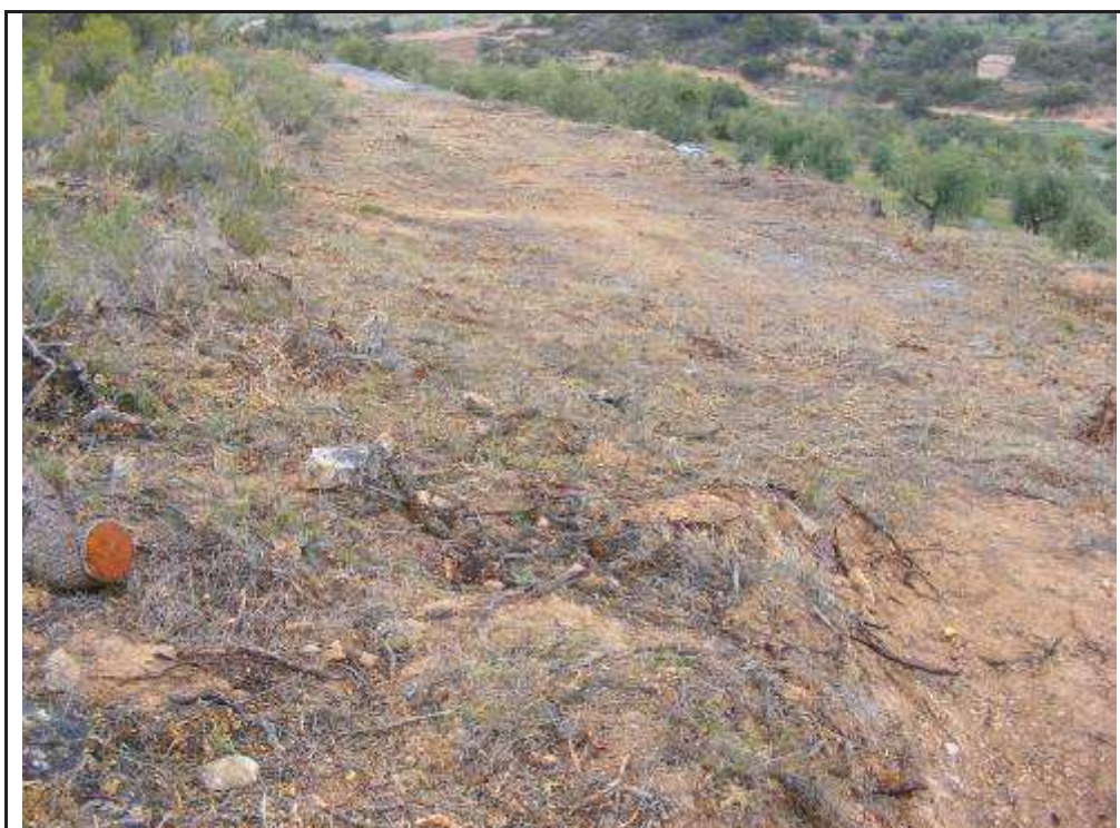
Foto 134: Zona talada entre el suport 5 i el suport 4.
