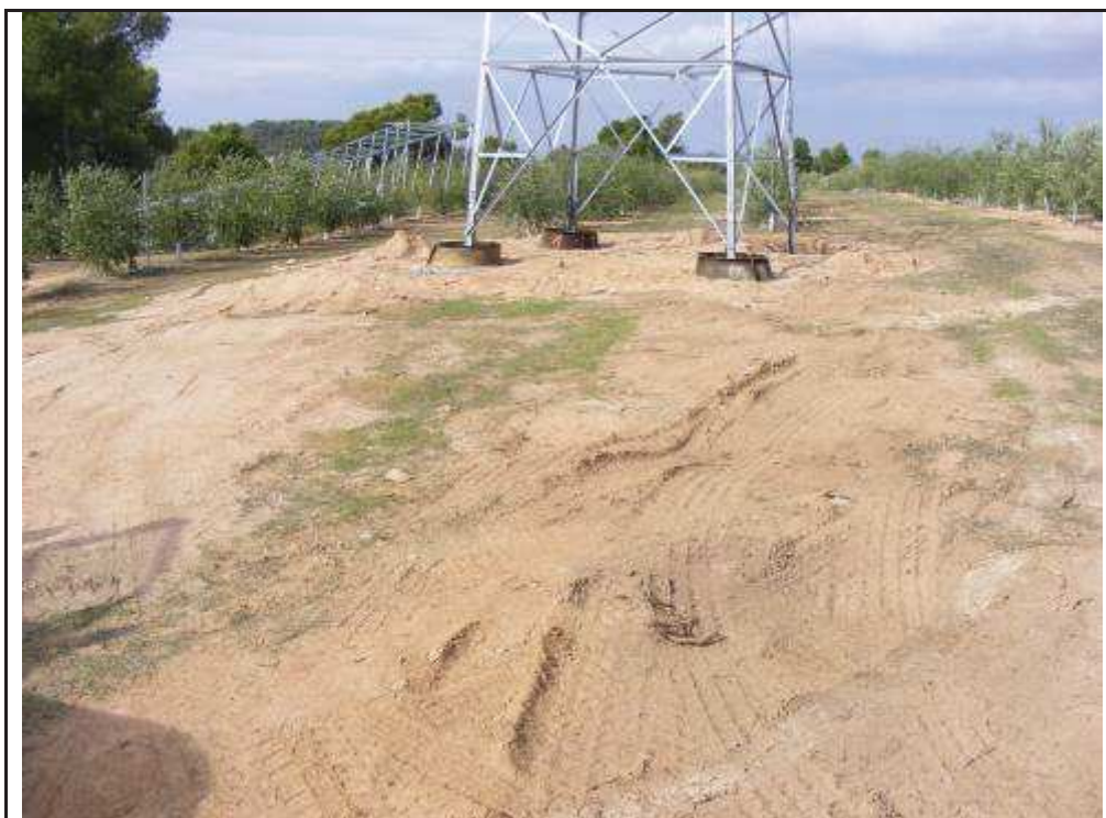
Foto 73: Suport 28, zona talada per la confecció de la plataforma.
