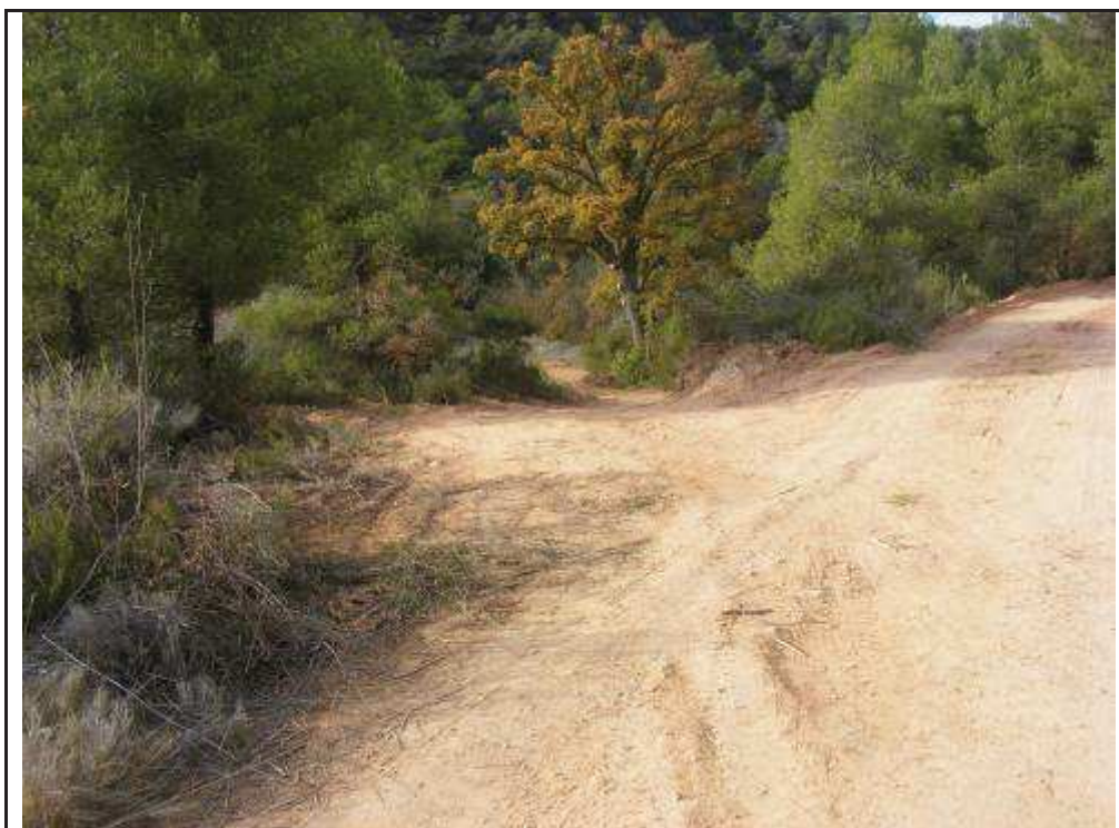
Foto 81: Suport 25, zona talada i desbrossada per l'ampliació i confecció del camí d'accés a la plataforma.
