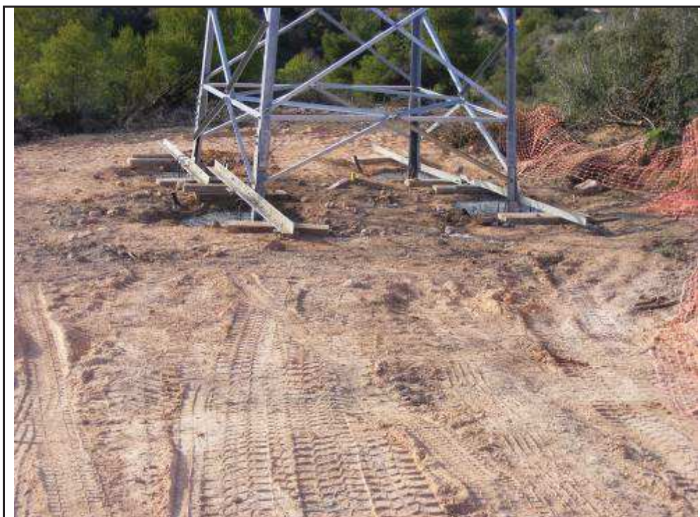
Foto 133: Suport 5, zona talada i aplanada per la confecció dels quatre pilars.
