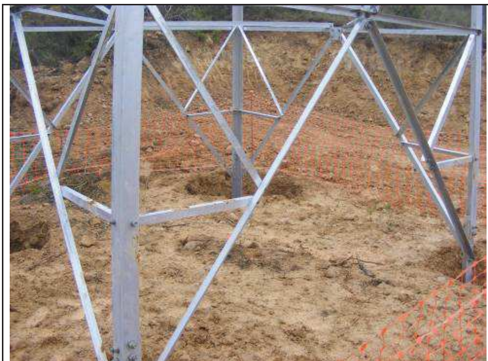
Foto 50: Suport 7, zona rebaixada per la confecció de la plataforma.
