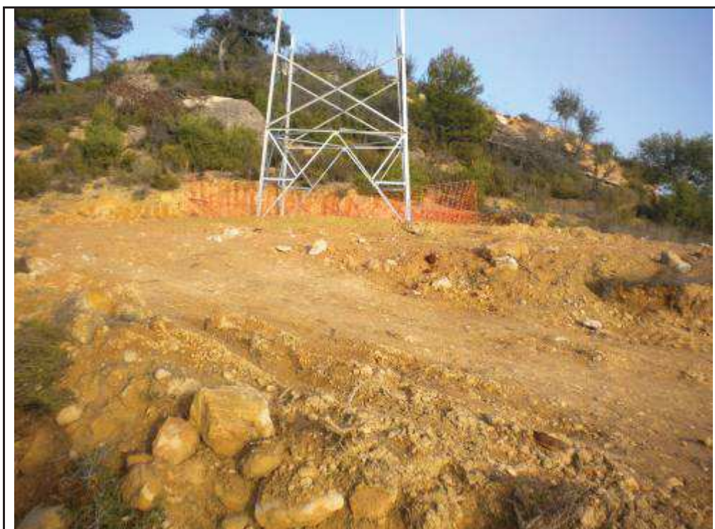
Foto 138: Suport 3, zona talada amb terraplens i rebaixos per la confecció dels quatre pilars, i zona amb rebaixos i terraplens per la confecció de la part final del camí d'accés a la plataforma.
