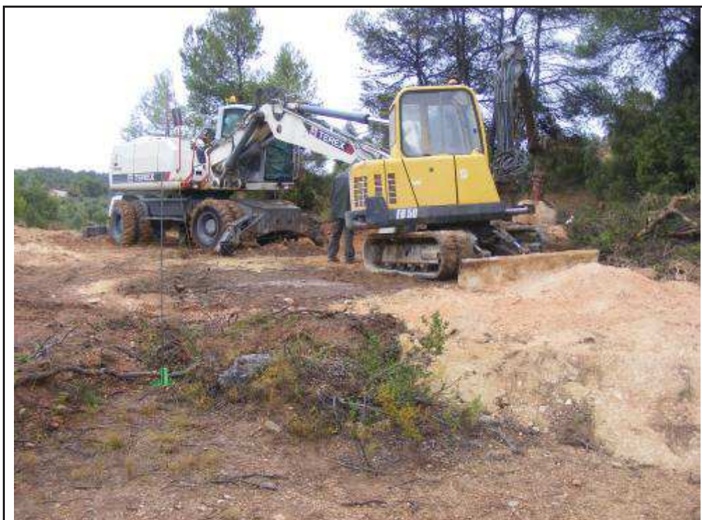
Foto 111: Suport 15, excavació dels quatre pilars.
