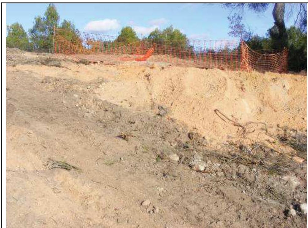
Foto 127: Suport 8, zona talada i desbrossada per la confecció dels quatre pilars. Afloraments de roca.
