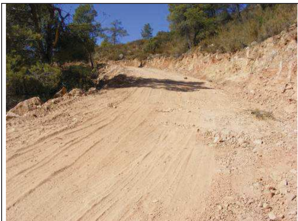
Foto 57: Suport 4, zona rebaixada per la confecció de l'accés a la plataforma.
