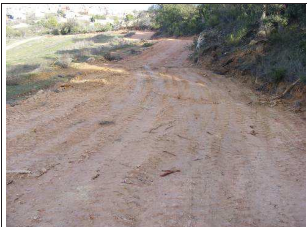
Foto 136: Suport 4, zona talada amb rebaixos i terraplens per la confecció del camí d'accés a la plataforma.
