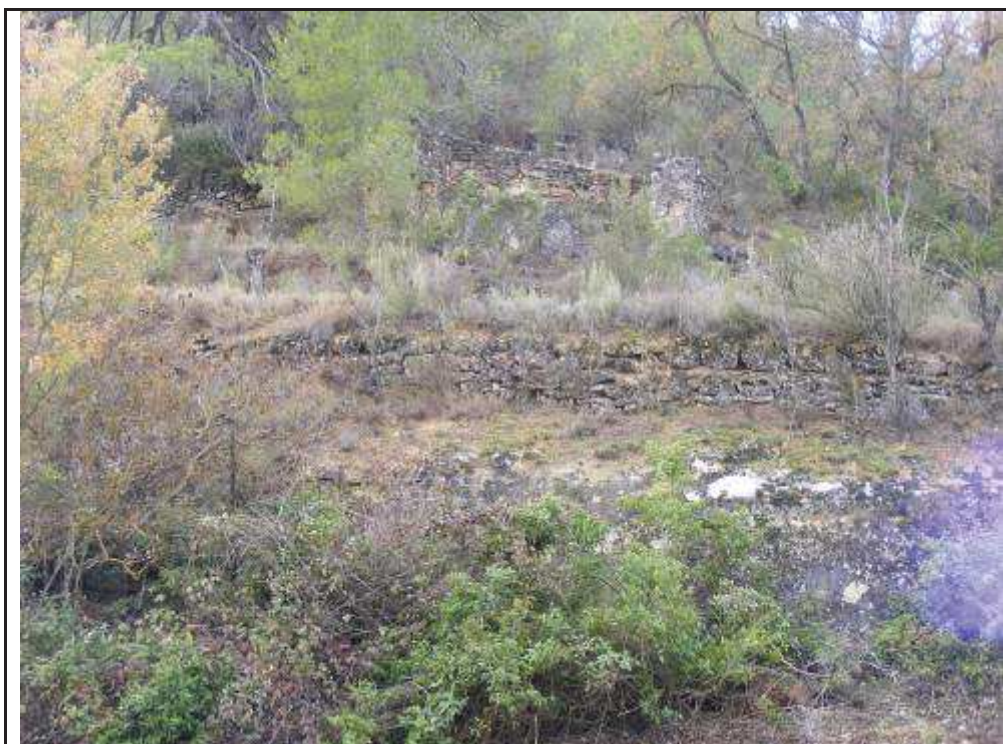
Foto 93:ED 5 cobert construït amb pedra seca
