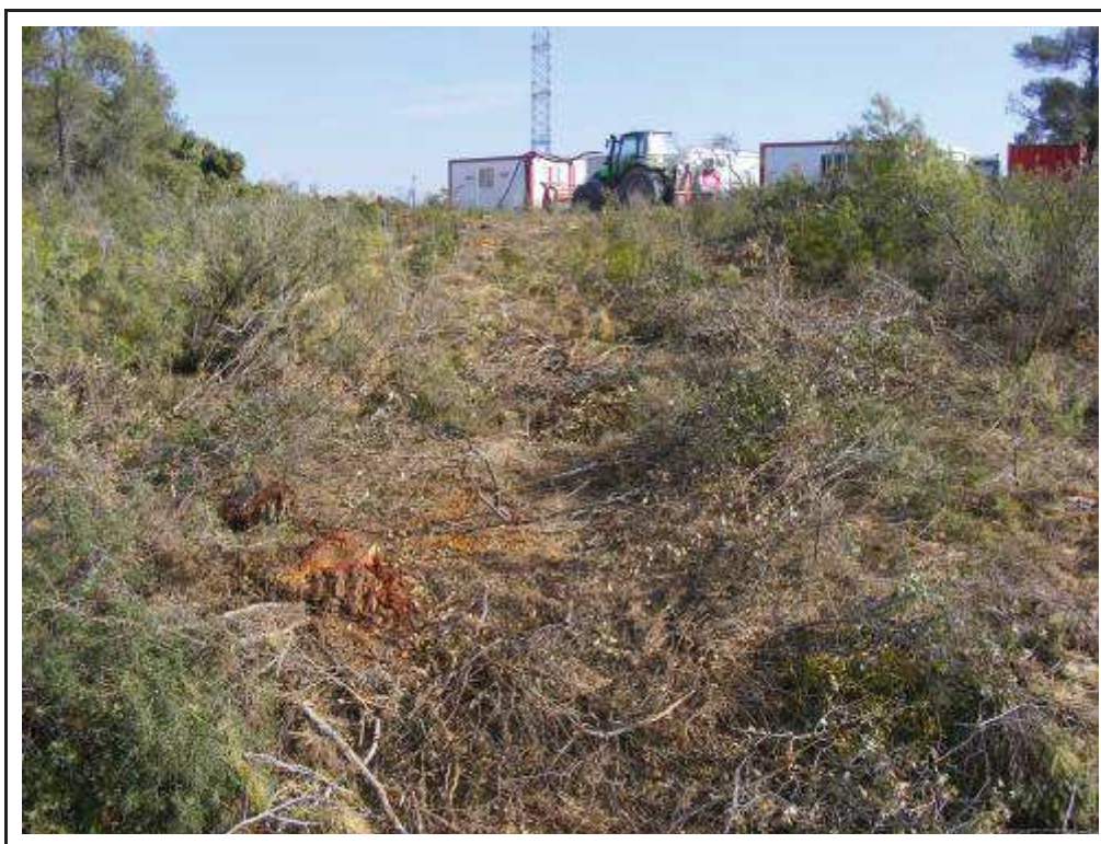
Foto 30: Traçat de la LE Entre els suports 15 i 16, s'ha talat una zona de bosc i matolls.
