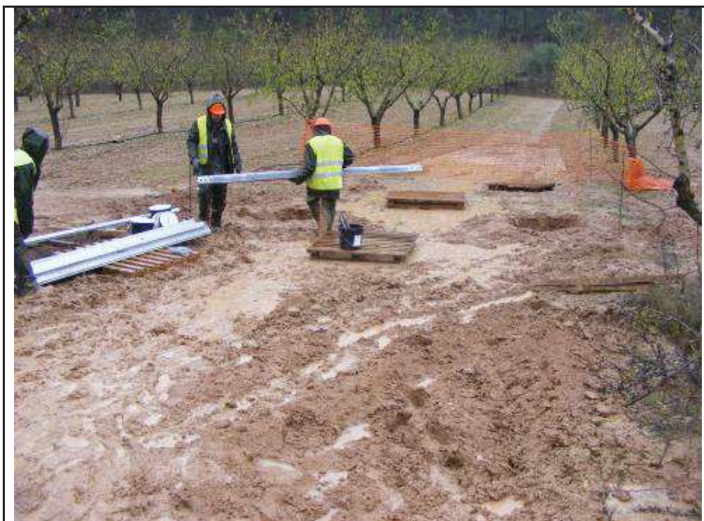
Foto 55: Suport 5, zona desbrossada per la confecció de la plataforma.
