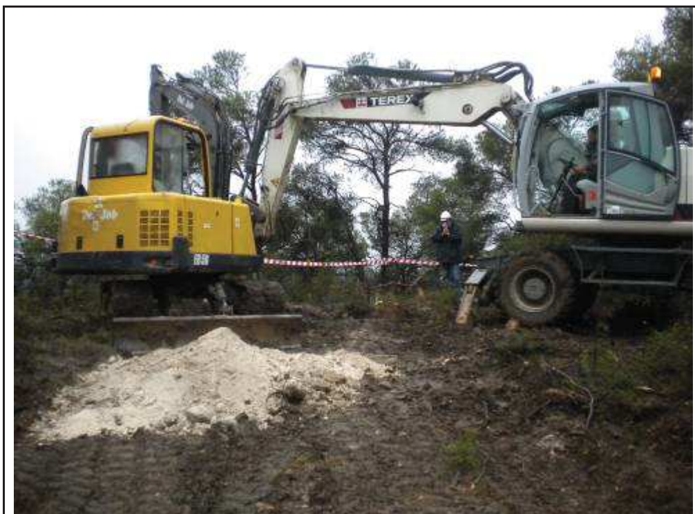
Foto 16: suport 8, excavació dels pilars.
