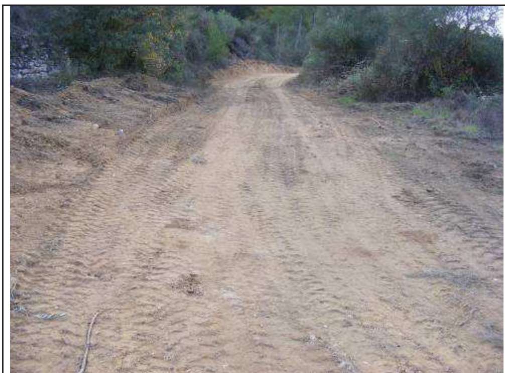
Foto 122: Suport 10, zona talada i desbrossada per la confecció del camí d'accés a la plataforma.
