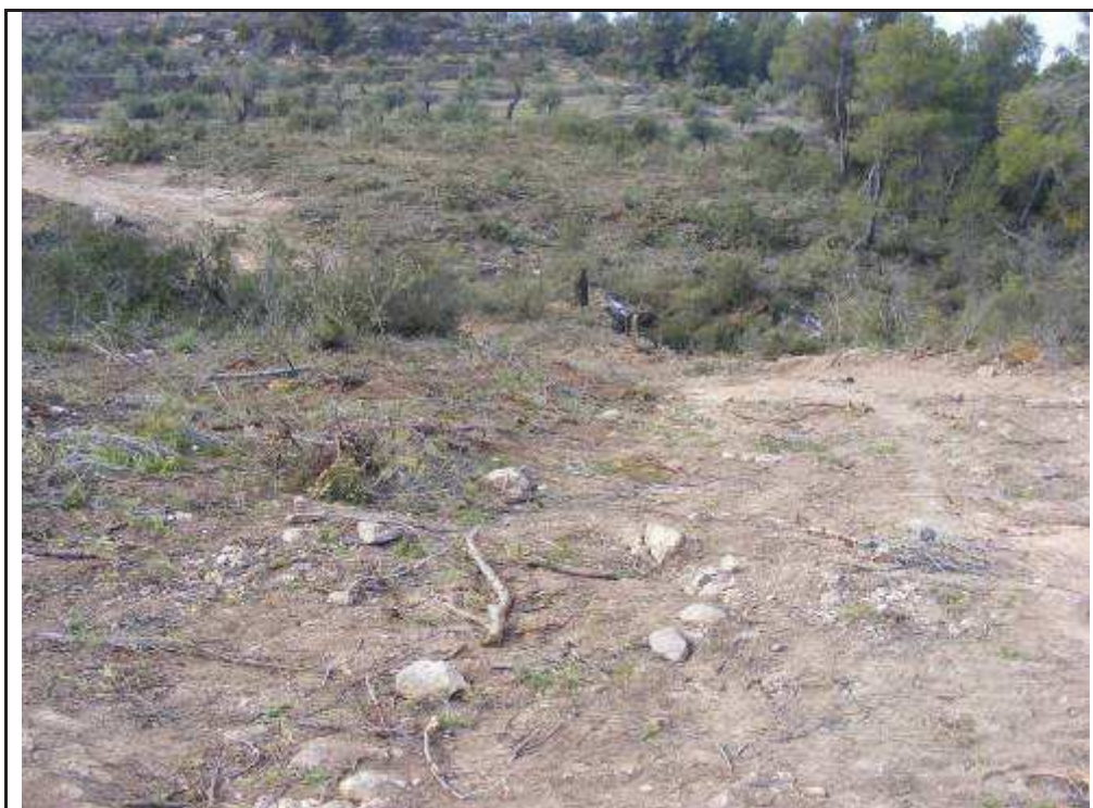
Foto 44: Zona talada entre el suport 10 i el suport 9.
