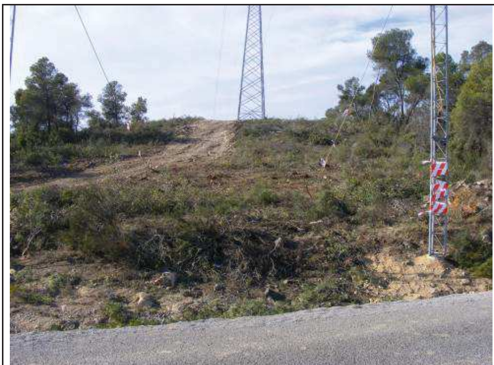
Foto 18: Traçat de la LE Entre els suports 8 i 9, s'ha talat una zona de bosc i matolls.
