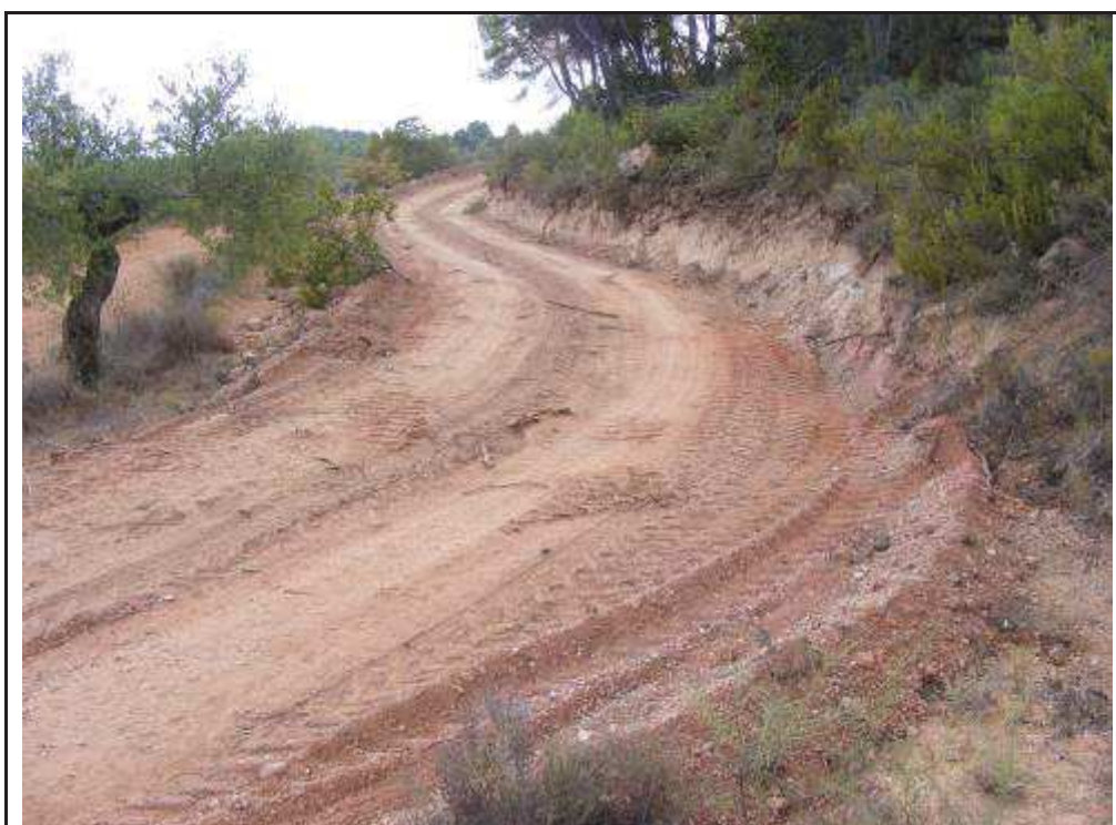
Foto 100: Suport 19, zona amb rebaixos per l'ampliació del camí d'accés a la plataforma.
