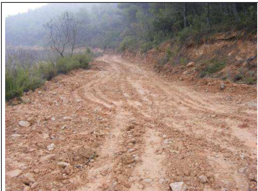
Foto 54: Suport 6, zona rebaixada per la confecció de l'accés a la plataforma.
