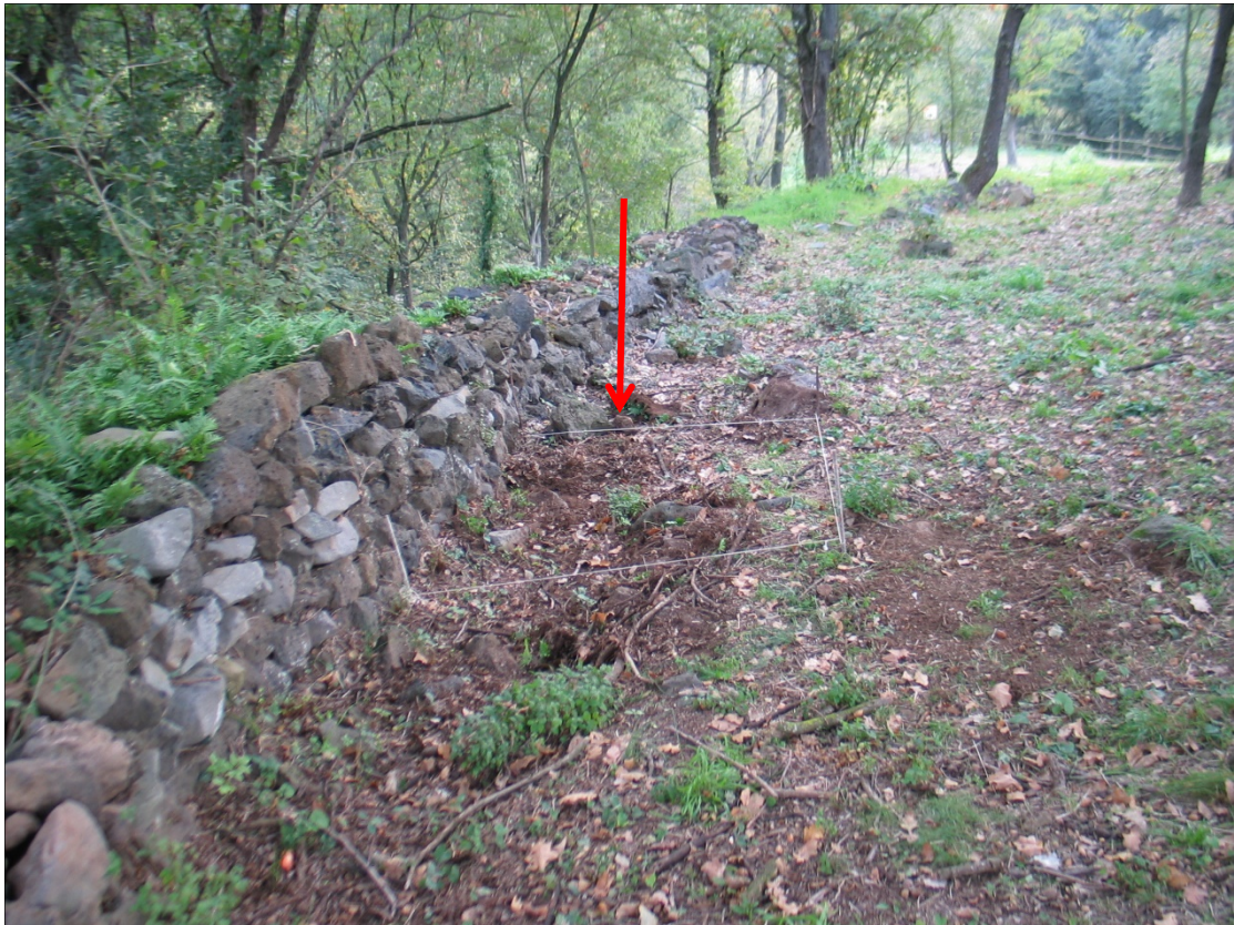
Fig. 26.- Vista de la ubicació de la cala VI abans d'iniciar l'excavació de la mateixa
