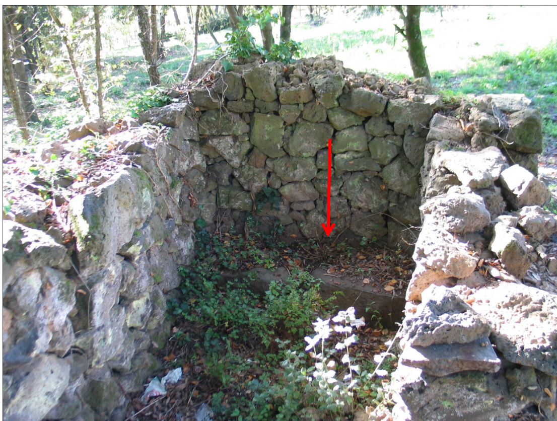
Fig. 42.- Vista interior de la barraca on s'observa la presència de la banqueteta UE 1011
