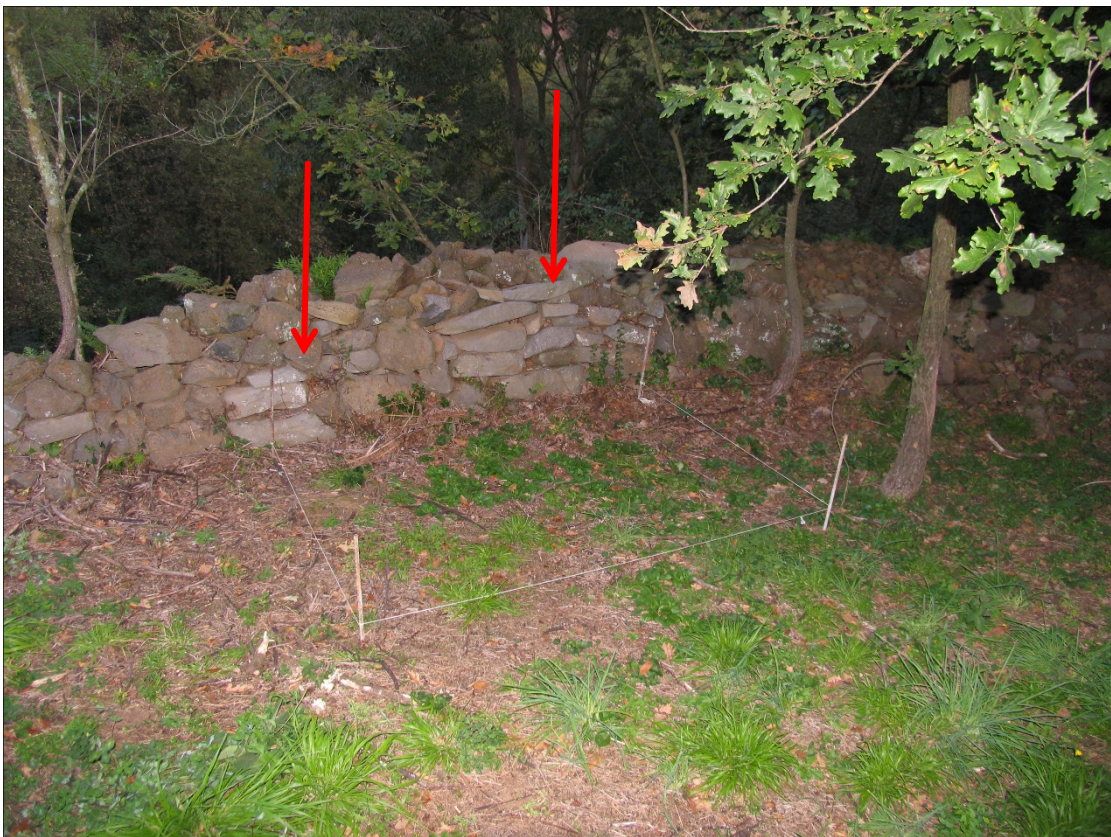
Fig. 37.- Vista de la refacció i possible tapiat (a confirmar) del mur UE 1001
