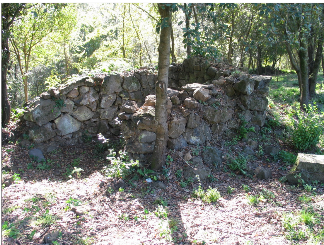
Fig. 41.- Vista exterior de la barraca que conformen els murs UE 1008, UE 1009 i UE 1010
