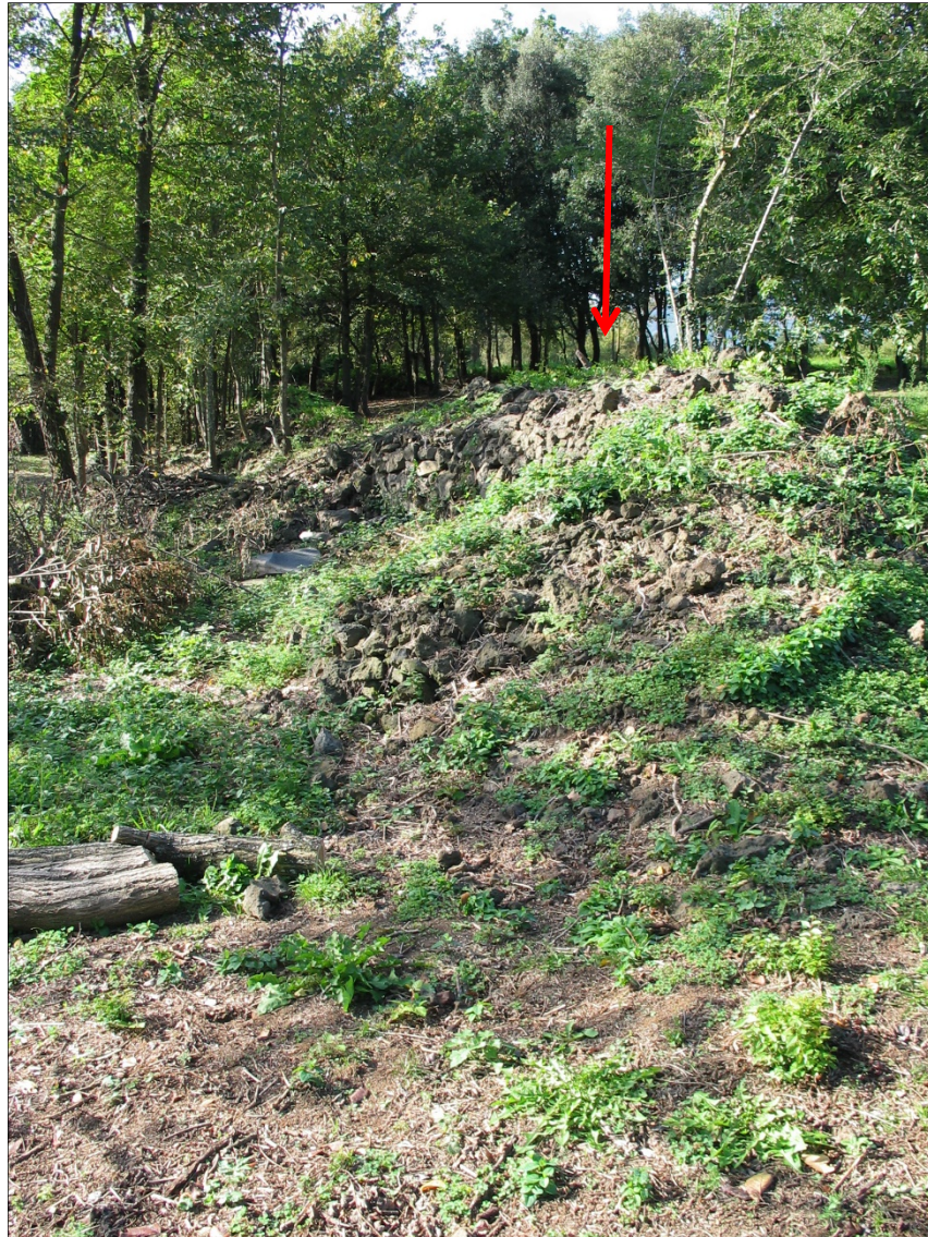
Fig. 43.- Vista de la zona on s'ubica la paret UE 1012
