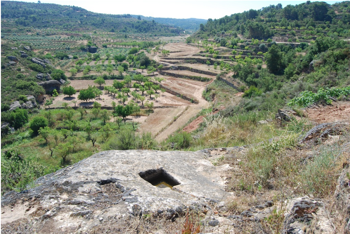
Vista de l'obra de construcció del camí de l'Albagés a Cervià, Vall de la Sisquella, juliol 2011
