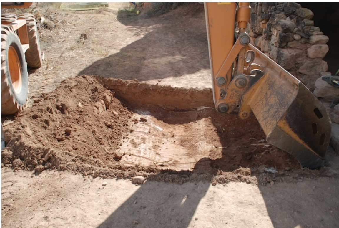
Figura 14. Inici del sondeig amb maquinaria pesada. El sondeig es va iniciar amb pala plana encara que es va haver de canviar pels fragments de visera caiguda.
