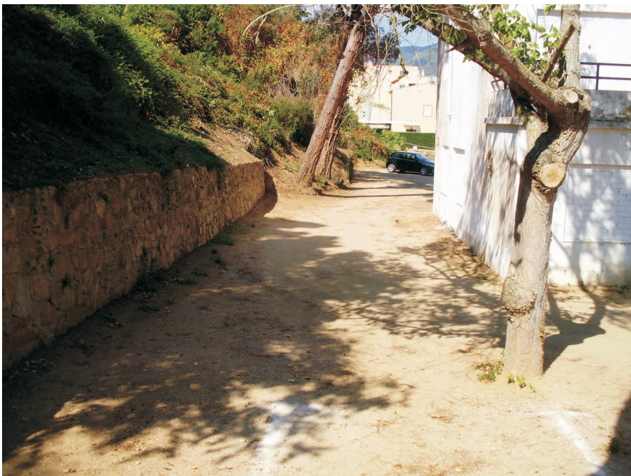
Zona occidental de la finca Acerbi on s'aprecia el desnivell del terreny que no s'ha vist afectat pels treballs d'adequació
