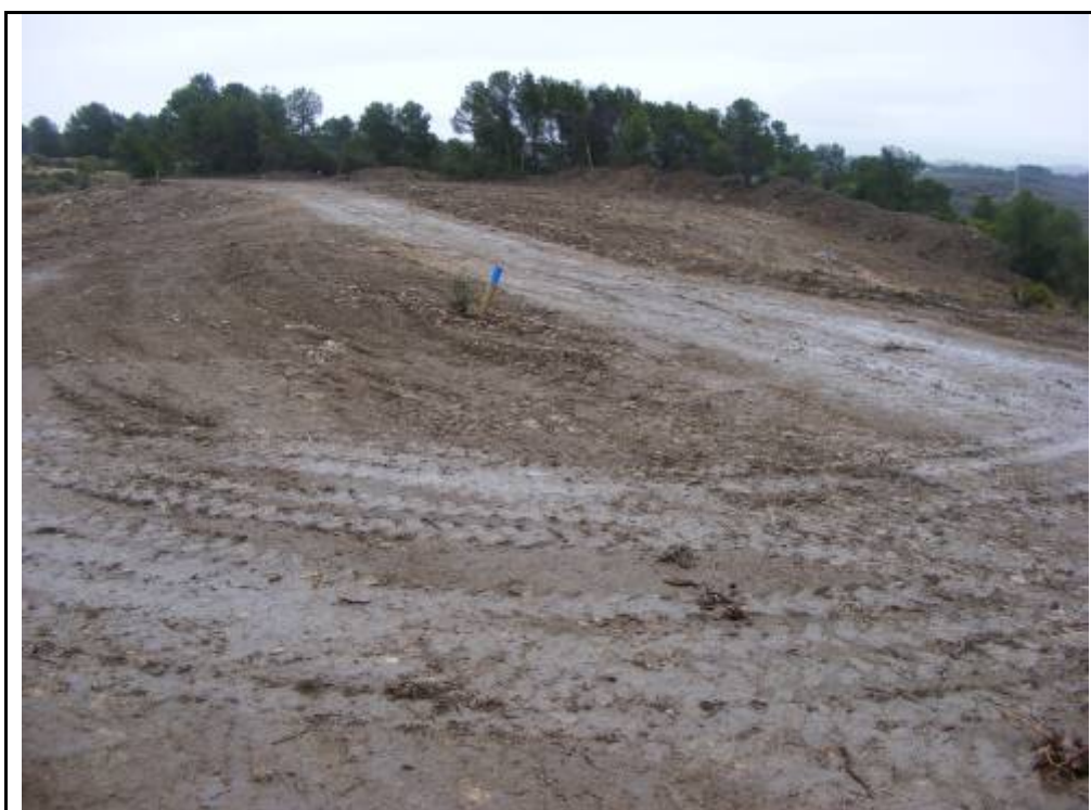
Foto 7: A.G. 4, control del desbrossament d'aquesta plataforma.
