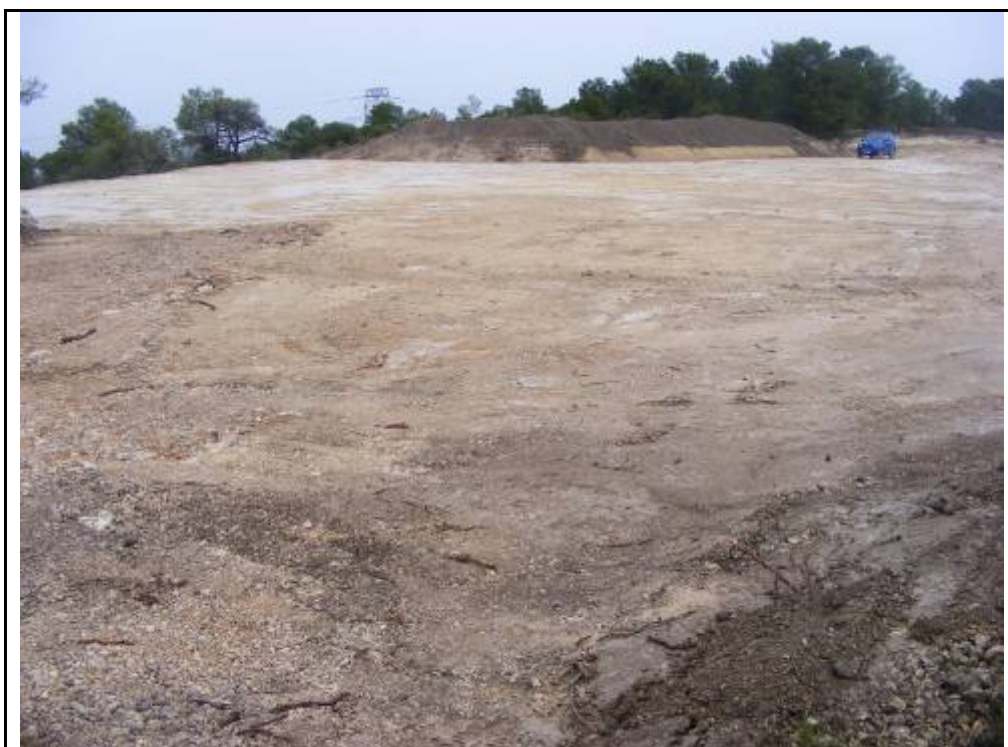
Foto 1: rebaixos a la zona on s'ubicarà l'A.G. 1.
