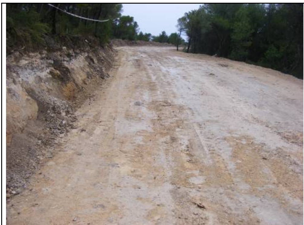
Foto 4: camí entre l'A.G. 2 i l'A.G. 3, zona amb rebaixos per ampliar el camí.
