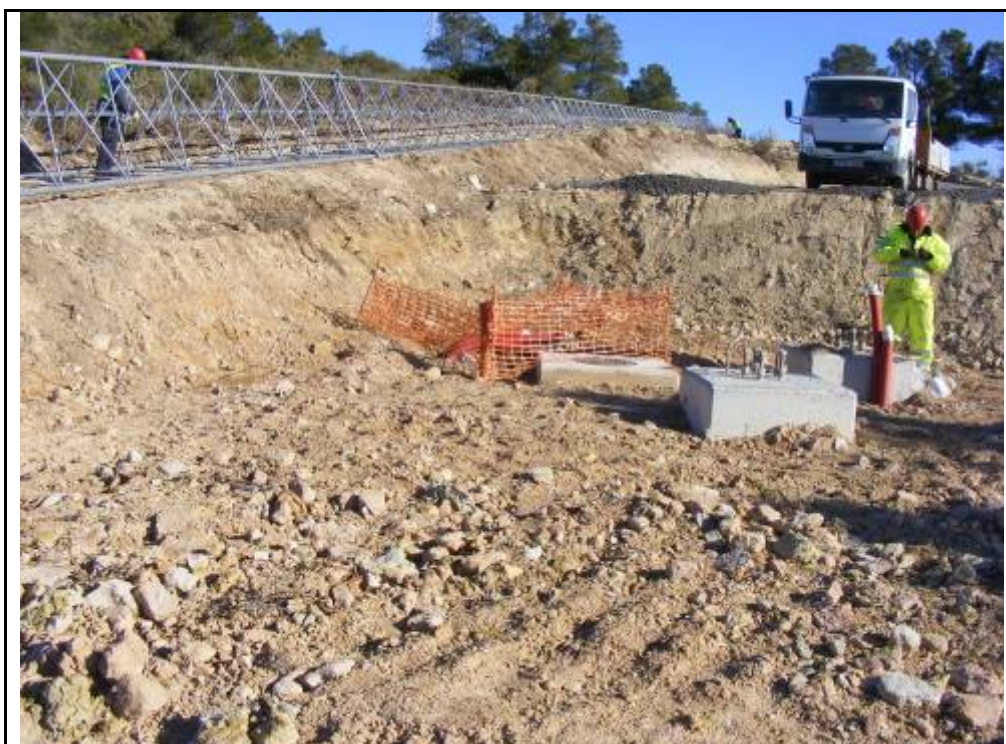
Foto 20: rebaixos a la zona de la plataforma de l'antena de medicíó.
