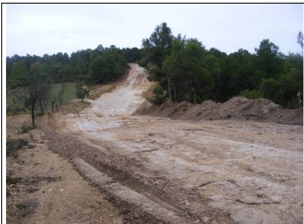
Foto 6: camí entre l'A.G. 3 i l'A.G. 4, zona amb rebaixos per ampliar el camí.
