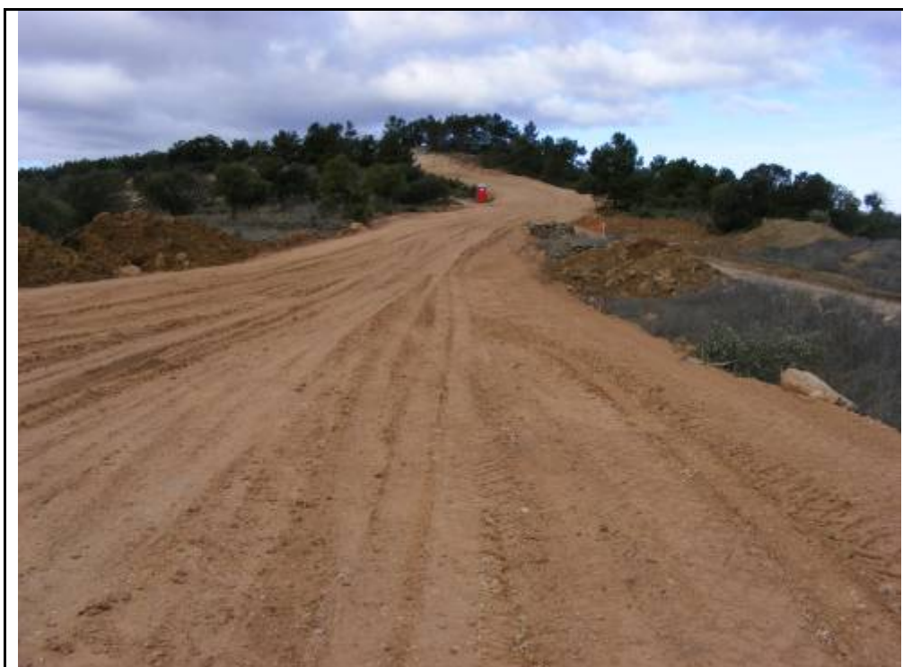
Foto 14: camí entre l'A.G. 6 i el camí d'accés al P.E. (camí de les Girones), zona amb rebaixos per ampliar el camí.
