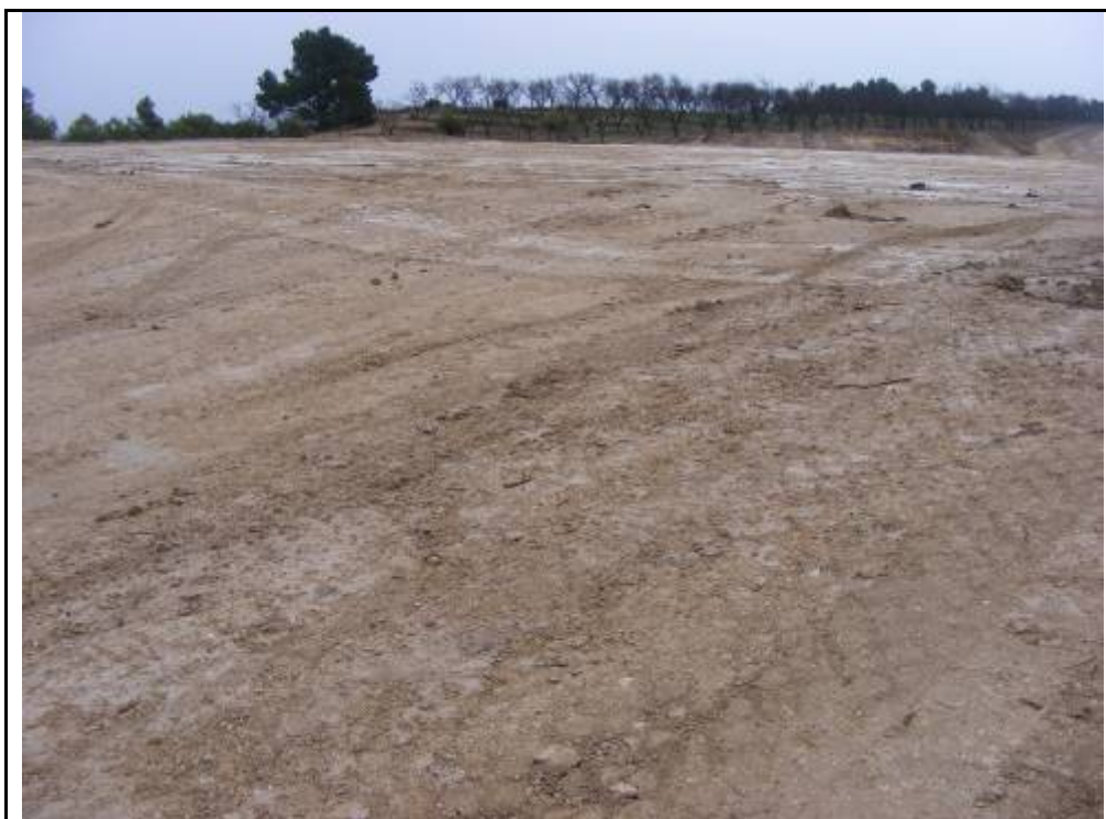
Foto 3: rebaixos a la zona on s'ubicarà l'A.G. 2.
