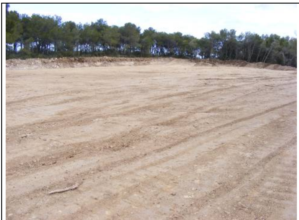
Foto 11: rebaixos a la zona on s'ubicarà l'A.G. 5.
