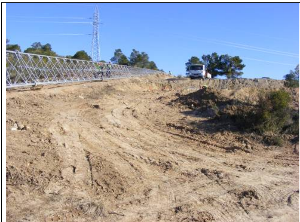
Foto 19: Zona amb rebaixos per la construcció de l'antena de medicíó.
