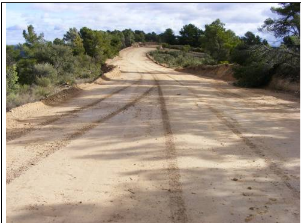
Foto 9: camí entre l'A.G. 4 i l'A.G. 5, zona amb rebaixos per ampliar el camí.
