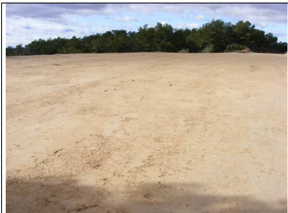
Foto 8: rebaixos a la zona on s'ubicarà l'A.G. 4.
