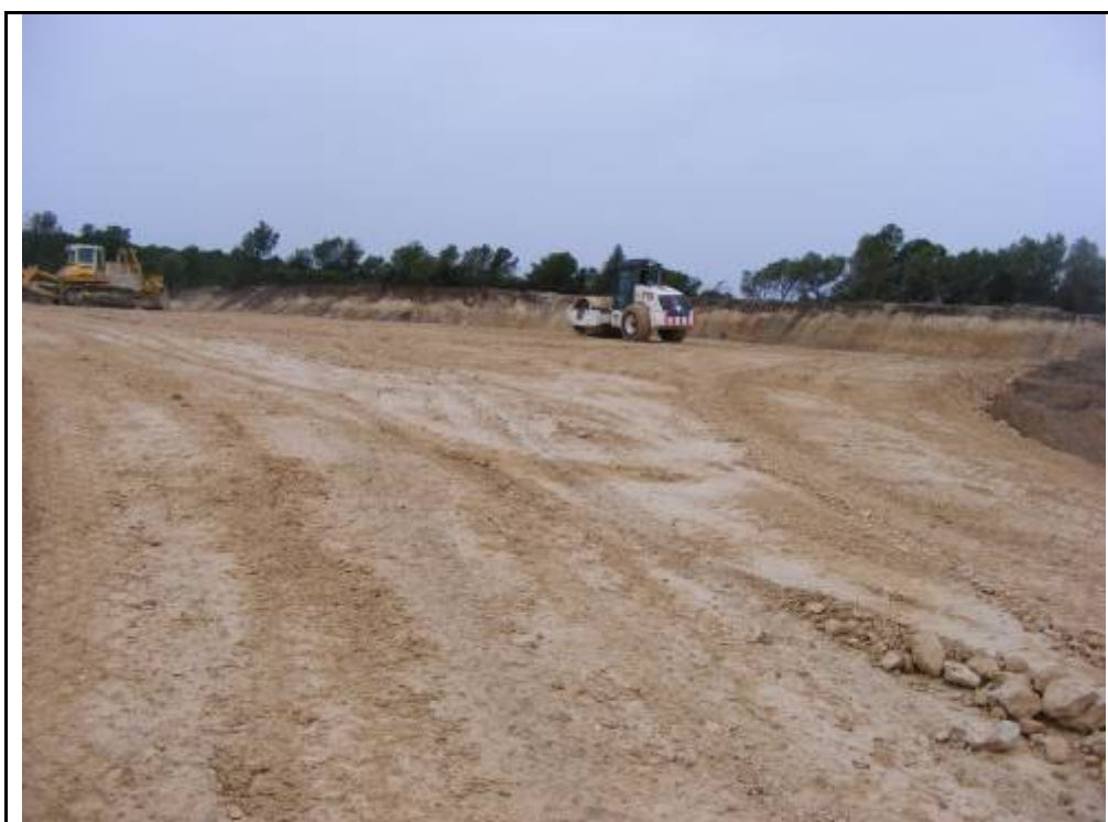
Foto 5: rebaixos a la zona on s'ubicarà l'A.G. 3.
