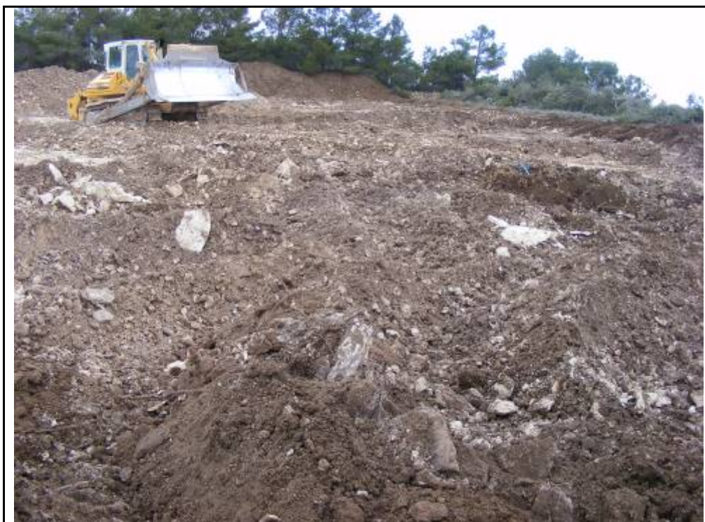
Foto 13: control dels rebaixos a la zona on s'ubicarà l'A.G. 6.
