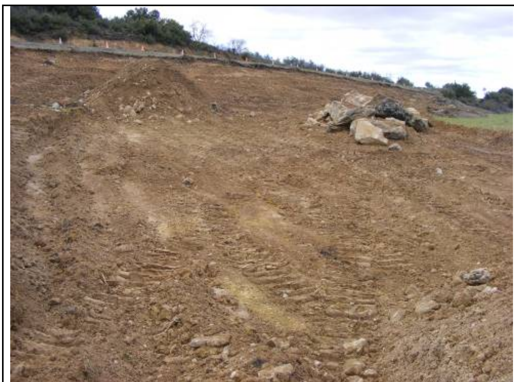
Foto 16: Camí d'accés al Parc Eòlic de Sant Antoni (camí de les Girones). Control dels rebaixos realitzats a tocar de la Carretera C-242
