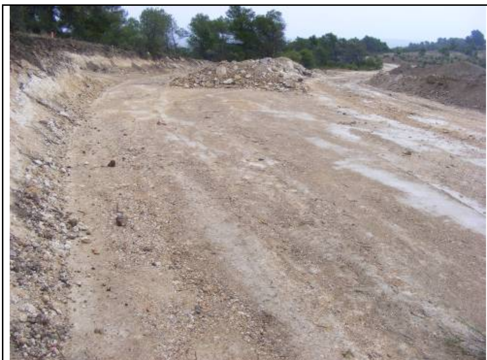
Foto 2: camí entre l'A.G. 1 i l'A.G. 2, zona amb rebaixos per ampliar el camí.
