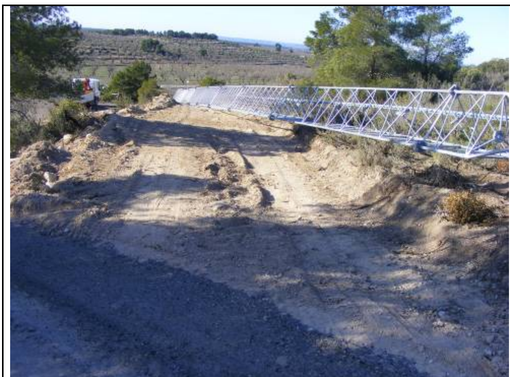
Foto 22: zona erma on s'està construint l'antena de medició.
