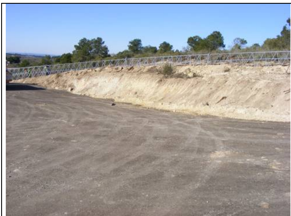
Foto 21: Seccions resultants dels rebaixos.
