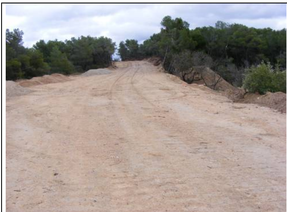
Foto 12: camí entre l'A.G. 5 i l'A.G. 6, zona amb rebaixos per ampliar el camí.
