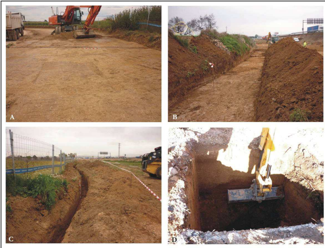
Fig. 76: Procés de neteja en el Sector III. B. Procés de neteja relacionat amb la rasa de la fibra òptica. C. Rasa per a la instal·lació de la llum. D. Rebaix per a la instal·lació d'una de les torres de la llum.
