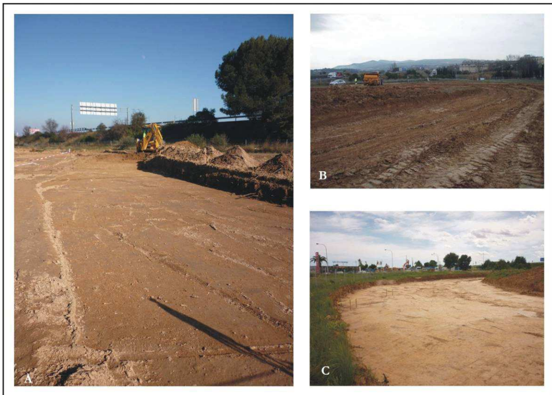
Fig. 75: A. Procés de neteja del vial principal del Sector I.. B. Procés de moviment de terres en el Sector II. C. Àrea d'excavació arqueològica dins el vial del Sector III.
