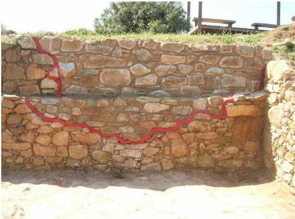
Vista frontal dels murs UE-2685 i UE-2625 un cop finalitzada la restauració.
