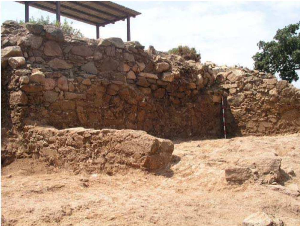
Vista general del recinte 36 amb els murs UE-2585 i UE 2625, al fons durant el procés d'excavació.
