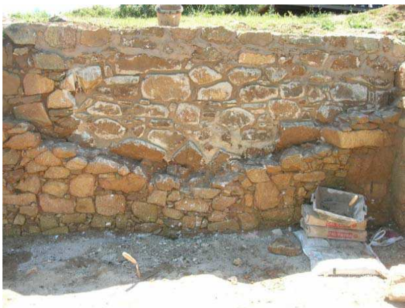
Vista frontal del mur UE-2585 un cop finalitzada la col·locació de pedres i en primer terme el mur UE-2625 just avanç de la consolidació.
