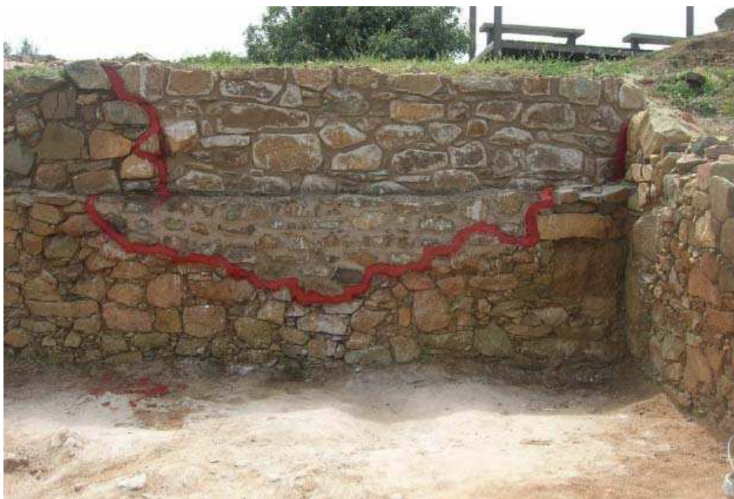
Vista frontal del murs UE-2685 i UE-2625 un cop aplicada la cinta diferenciadora.
