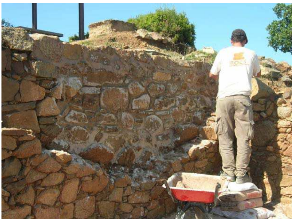
Detall del procés de consolidació del mur UE-2585
