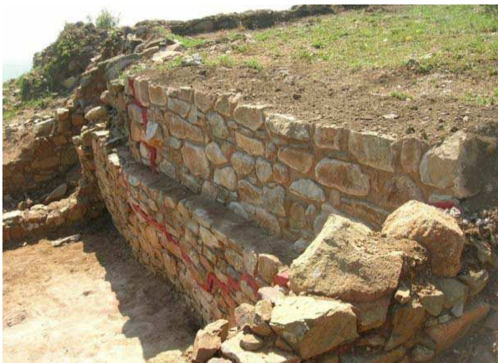
Vista lateral dels murs UE-2685 i UE-2625 un cop finalitzada la restauració.
