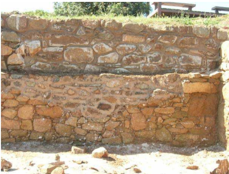
Vista frontal del mur UE-2625 un cop finalitzada la col·locació de pedres.
