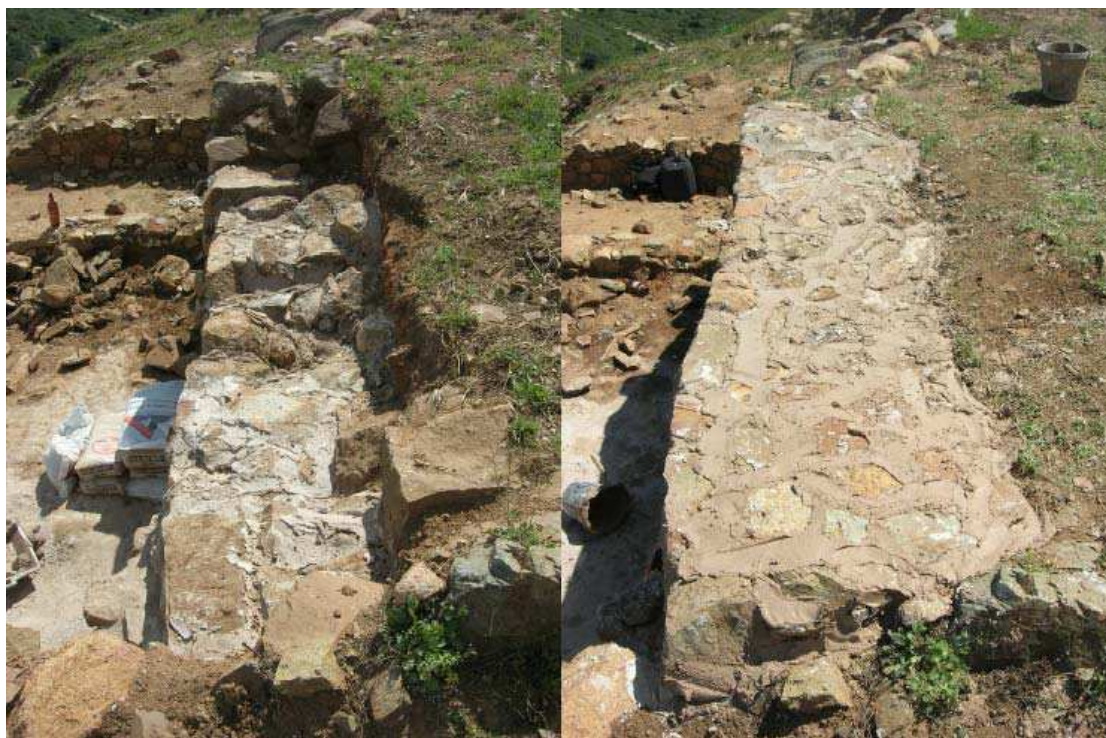
Detall del procés de consolidació del mur UE-2585, fotografia superior esquerra: col·locació de filades de pedra; fotografia superior dreta: finalització de la consolidació del mur.
