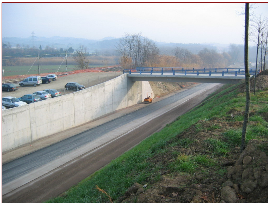
Vista d'un tram de la carretera gairebé finalitzada.
