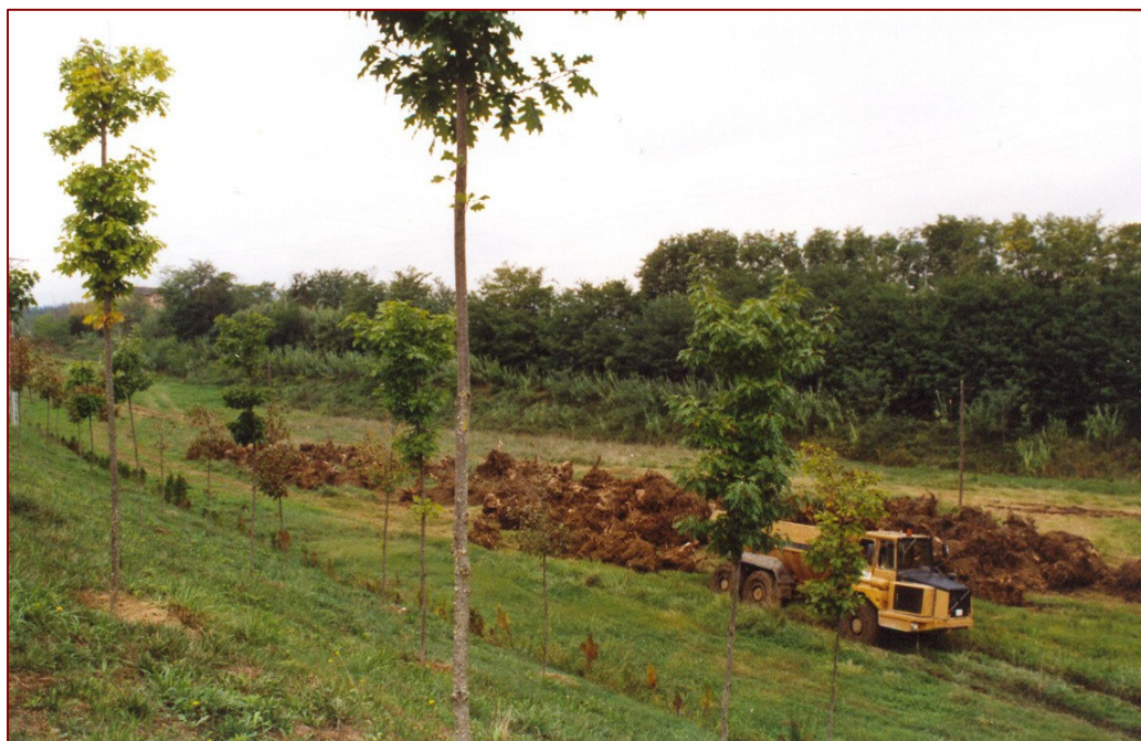
Zones afectades per les obres abans de començar la mateixa.
