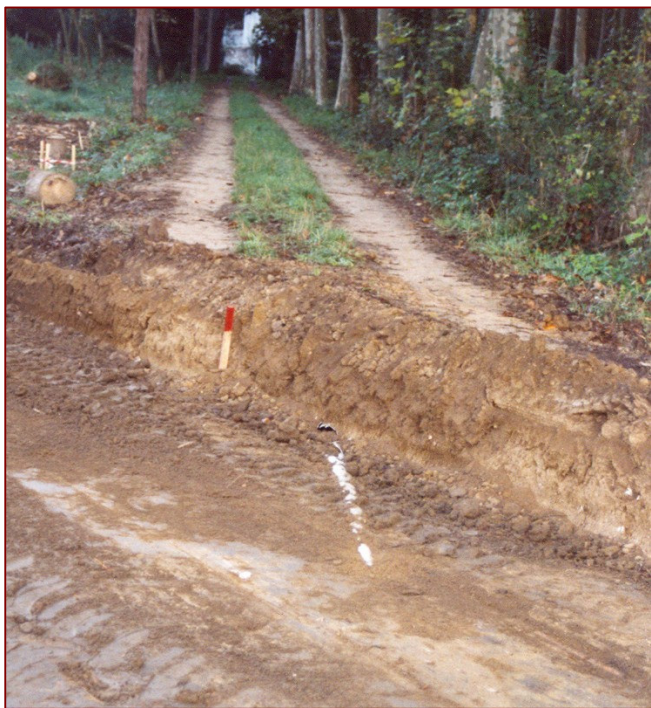
Detall dels rebaixos a la traça de la nova carretera on s'observa algun dels serveis contemporanis que afectaven la traça.
