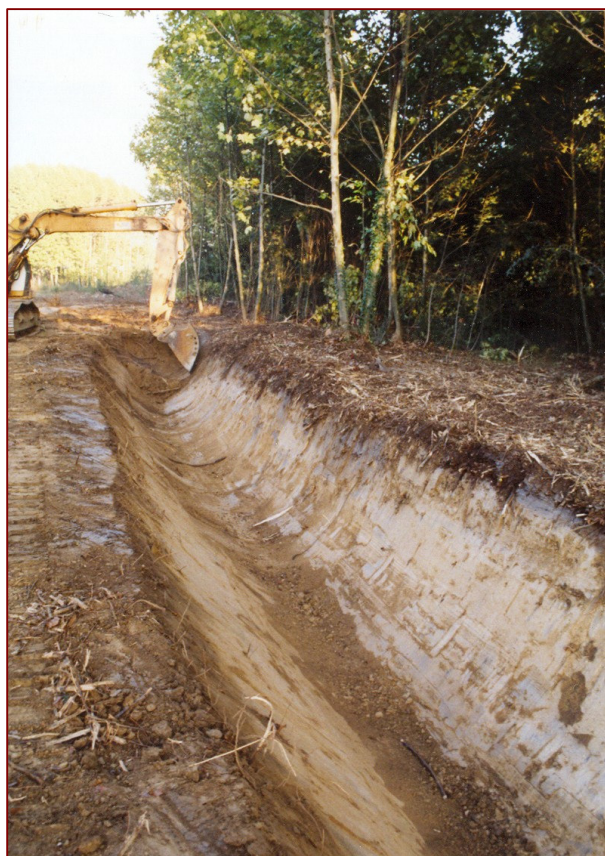
Detall dels rebaixos relacionats amb les obres d'acondicament de la futura via.
