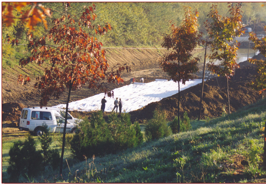
Condicionament de la traça un cop feta la excavació.
