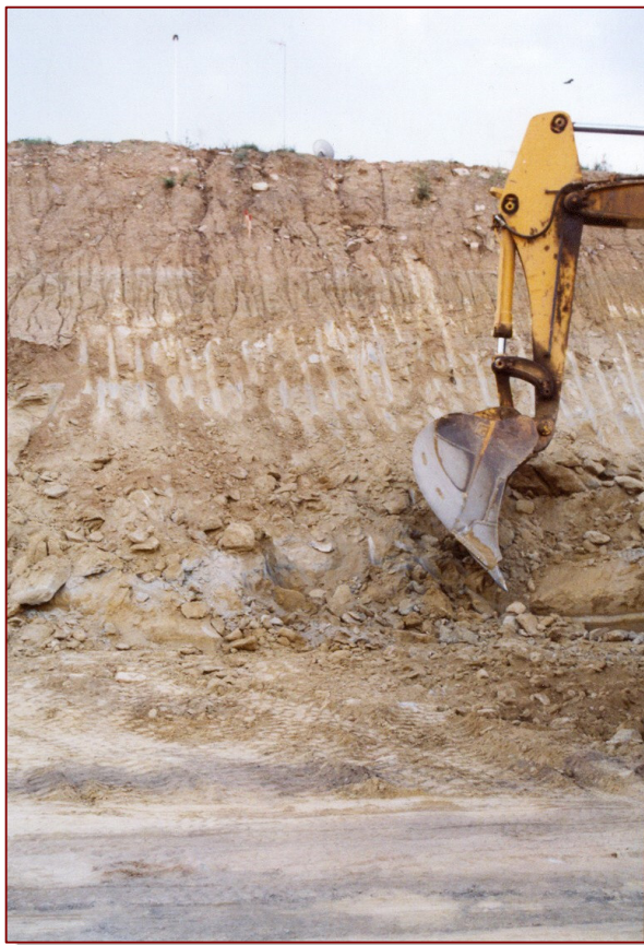
Detall d'uns dels talussos de la obra.
