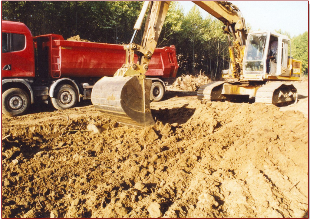
Inici dels rebaixos a la traça de l'obra.
