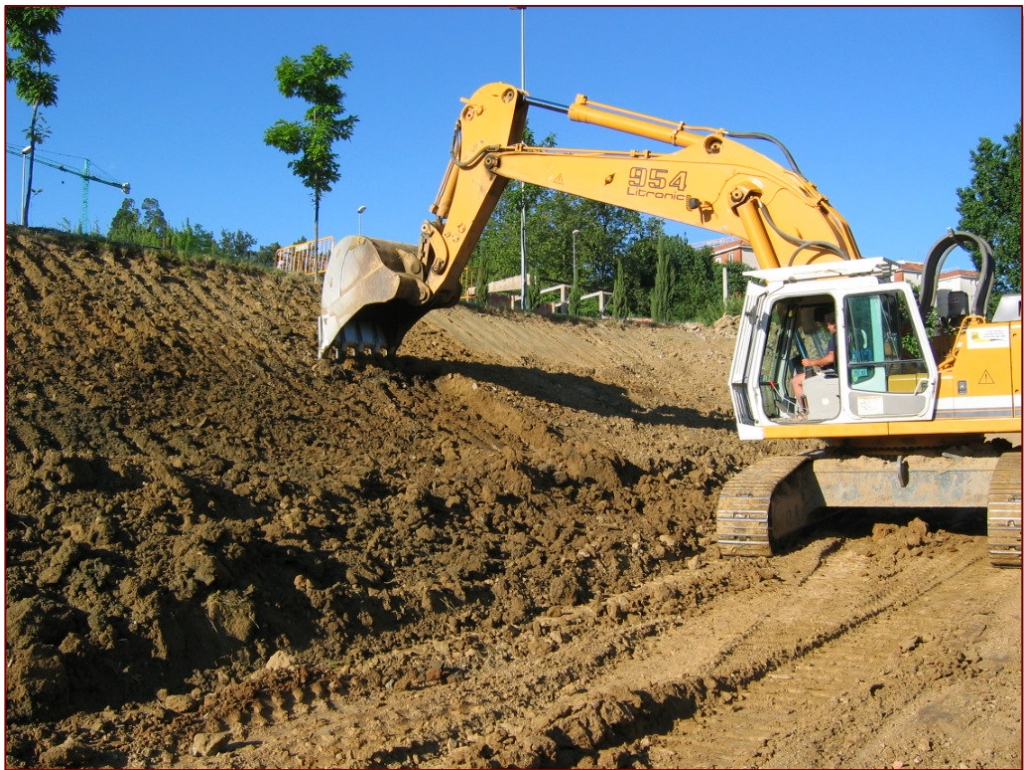
Detall d'uns dels talussos de la obra.
