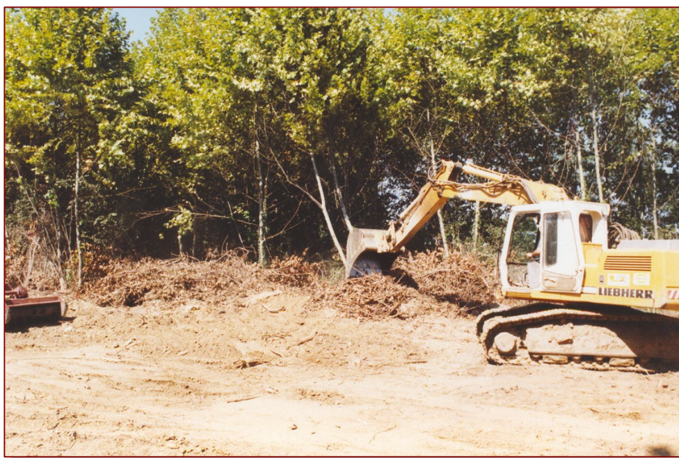
Detall de l'extracció de la capa vegetal a la traça de la obra.
