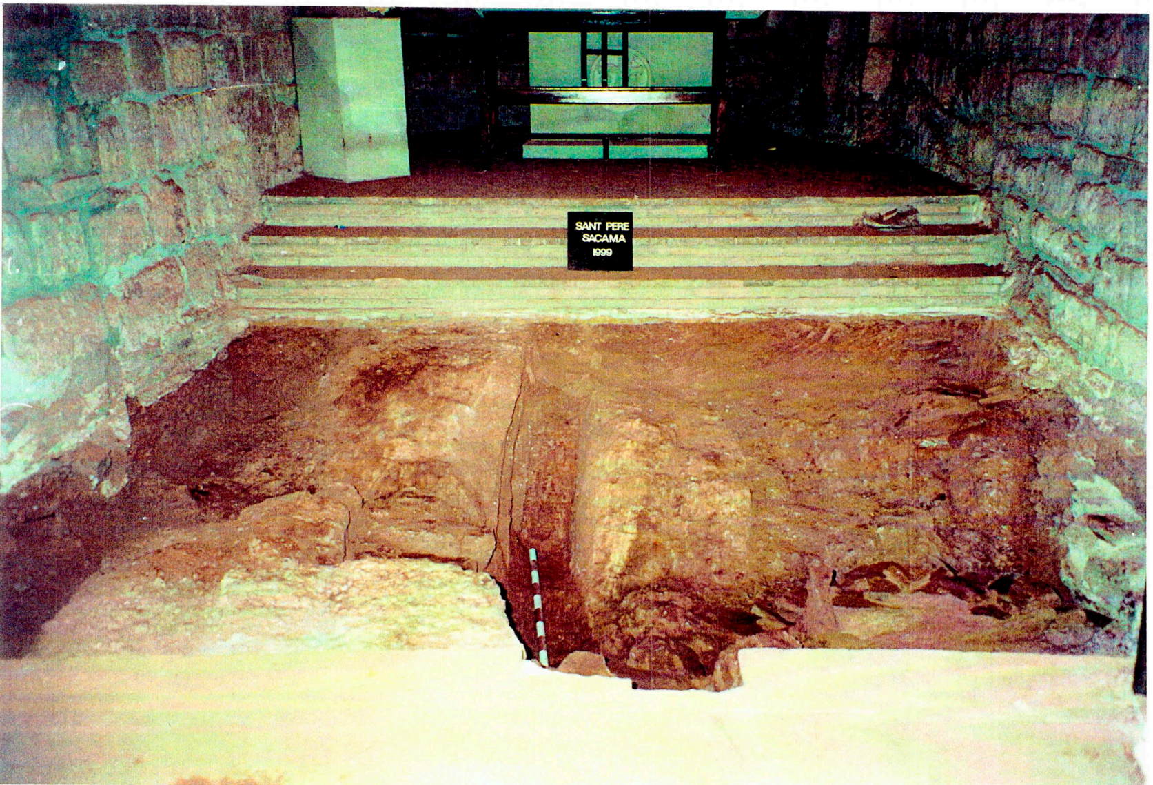
FOTO 2. Zona intervinguda. Vista general un cop acabada la intervenció
