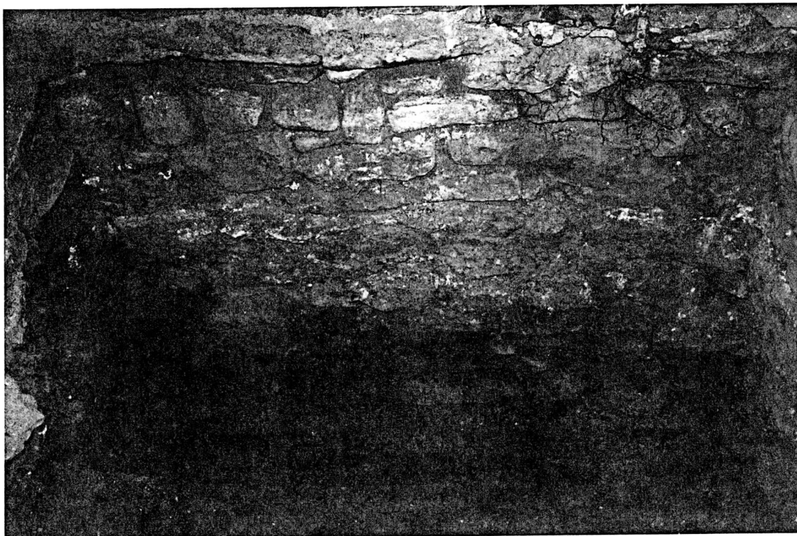
Sondeig interior. Fonaments del mur oest de la torre.
