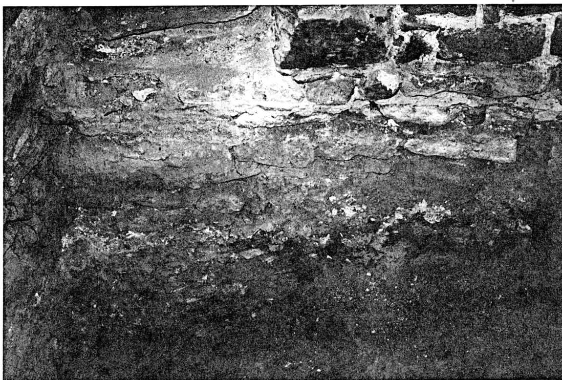
Sondeig interior. Fonaments del mur nord de la torre.
