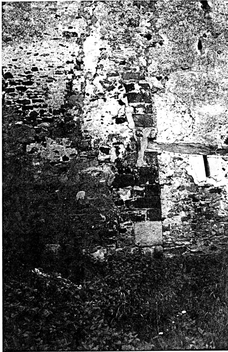
Mur nord. Cantonera de les fases I i II. Probablement va ser modificada.
