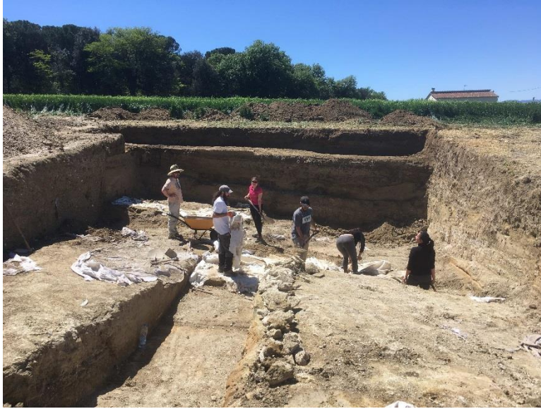
Fig. 2. Neteja de la superfície d'excavació
