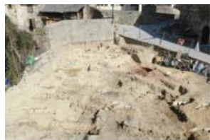
os aèries durant els treballs (1
