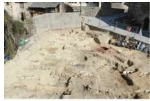
os aèries durant els treballs (4)
