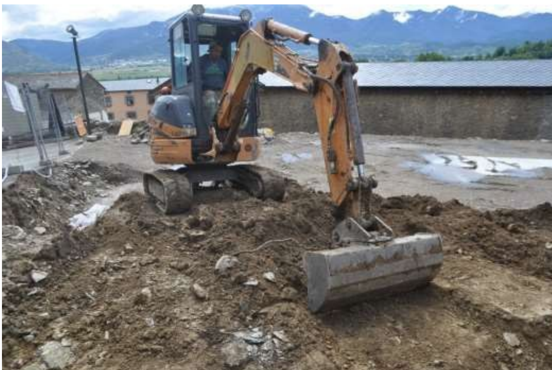
Excavació mecànica de les capes superficials del solar
