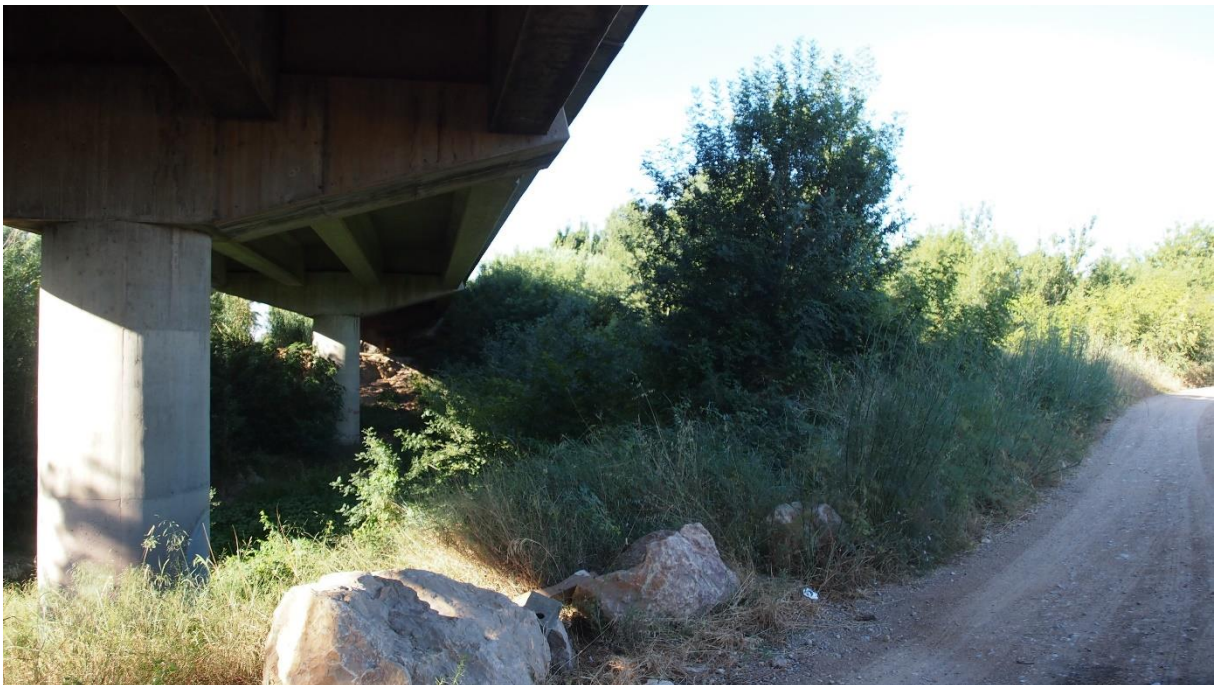
Viaducto Muga, zona ampliación estado actual
