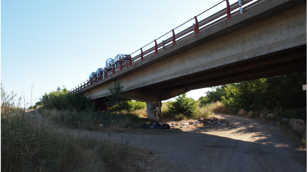
Viaducto Muga, zona de ampliación estado actual
