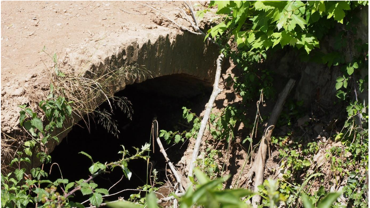
Detalle puente AE5
