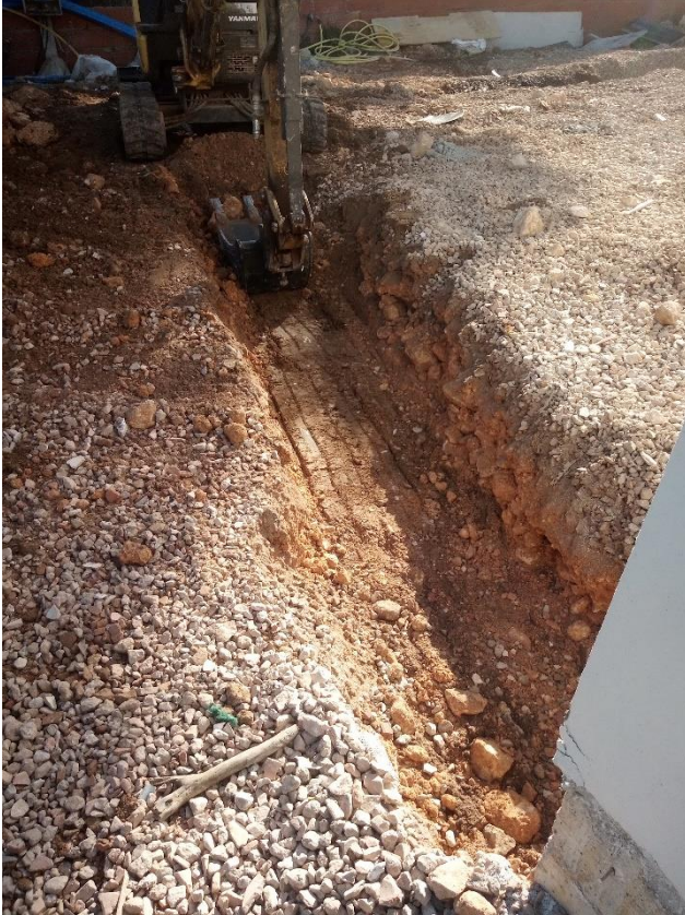
Fig. 19. Realització de la rasa 3. Vista des del N.
