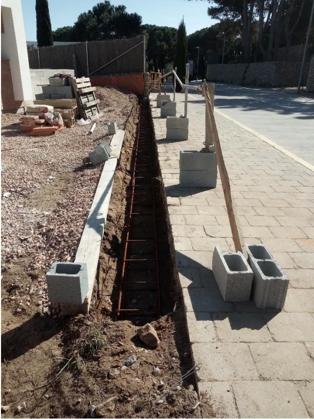
Fig. 15. Rasa 2 realitzada, i amb l'armadura a dins. Vista des del N.
