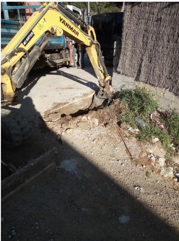
Fig. 10. Realització de la rasa 1. Vista des del SE.
