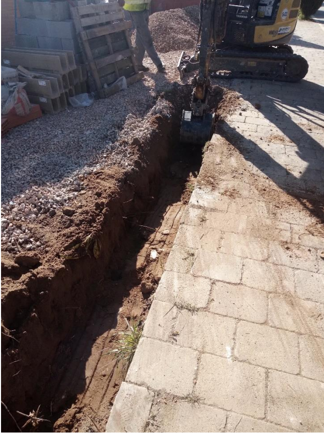
Fig. 13. Realització de la rasa 2. Vista des del N.
