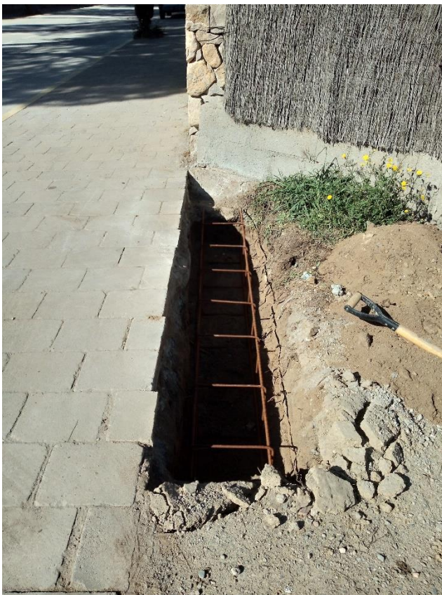
Fig. 12. Rasa 1 realitzada, i amb l'armadura a dins. Vista des del S.
