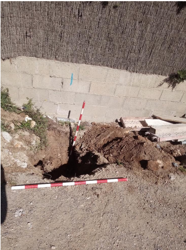
Fig. 16. Cala 1 realitzada. Vista des del S.
