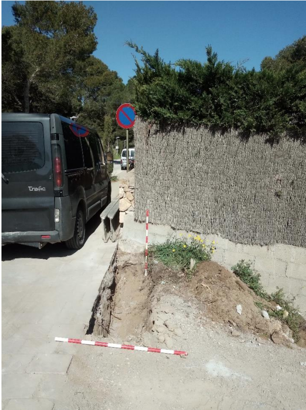
Fig. 11. Rasa 1 realitzada. Vista des del S.
