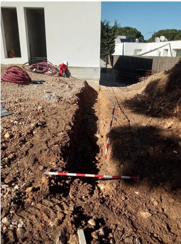
Fig. 20. Rasa 3 realitzada. Vista des del S.
