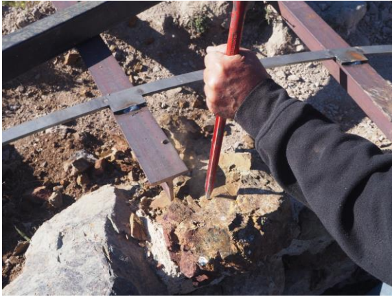
Fig. 3 i 4. Vista dels retocs puntuals que es van realitzar per tal d'assentar l'estructura metàl·lica sobre la torre. A la dreta, l'estructura presentada sobre les restes de la torre un cop anivellada.
