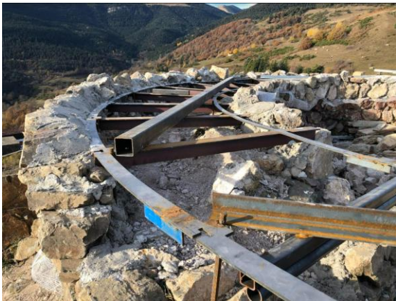
Fig. 5 i 6. Vista de l'estructura metàl·lica col·locada sobre la torre i amb la fulla interna i externa refetes, embolcallant el que serà el fonament de l'estructura metàl·lica superior. A la dreta, la fulla exterior de la torre on es pot observar el tram inferior original i el superior refet, separat pel mallatex.
