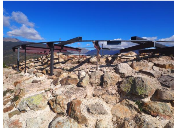
Fig. 3 i 4. Vista dels retocs puntuals que es van realitzar per tal d'assentar l'estructura metàl·lica sobre la torre. A la dreta, l'estructura presentada sobre les restes de la torre un cop anivellada.
