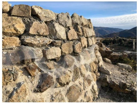
Fig. 5 i 6. Vista de l'estructura metàl·lica col·locada sobre la torre i amb la fulla interna i externa refetes, embolcallant el que serà el fonament de l'estructura metàl·lica superior. A la dreta, la fulla exterior de la torre on es pot observar el tram inferior original i el superior refet, separat pel mallatex.
