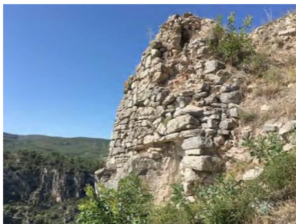
Vista general de l'estat que presentava el tram del mur (ue 501) abans de procedir a les actuacions de condicionament de l'aparell constructiu del seu parament.
