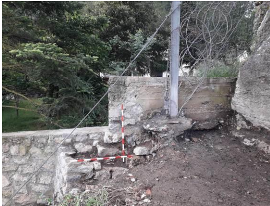
Detall dels ancoratges de l'estructura de l'escala directament sobre el substrat rocós (ue 100) o de les estructures associades a la tanca perimetral de delimitació de la finca.
