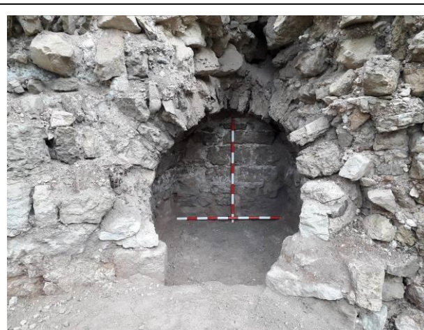
Detall de l'estructura que s'obre a l'interior del mur de tancament de la torre (ue 305).
