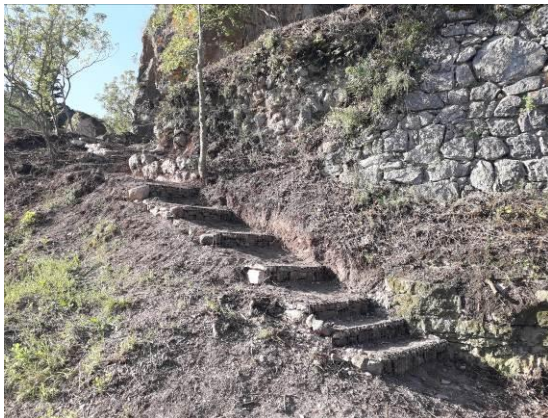
Vista del tram on es va habilitar un graonat reversible disposat sobre el nivell de terres superficials (ue 101) i vista del vial habilitat aprofitant el pas ja existent associat a la malla disposada com a contenció de desprendiments del basament rocós (ue 100).
