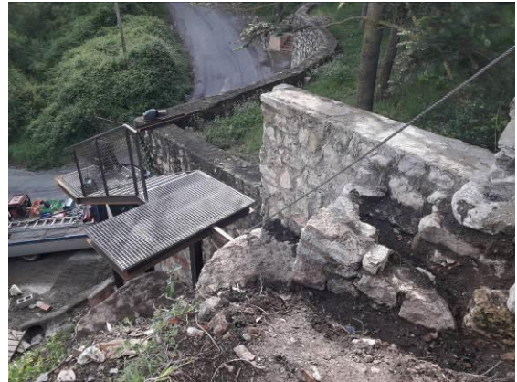
Detall dels ancoratges de l'estructura de l'escala directament sobre el substrat rocós (ue 100) o de les estructures associades a la tanca perimetral de delimitació de la finca.
