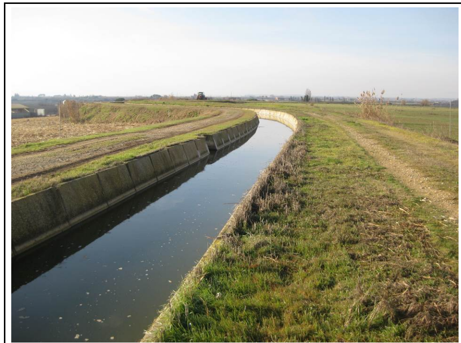
Foto 7. Tram de la sèquia dels Reguers que passa per la banda sud-est de la zona afectada pel projecte.
