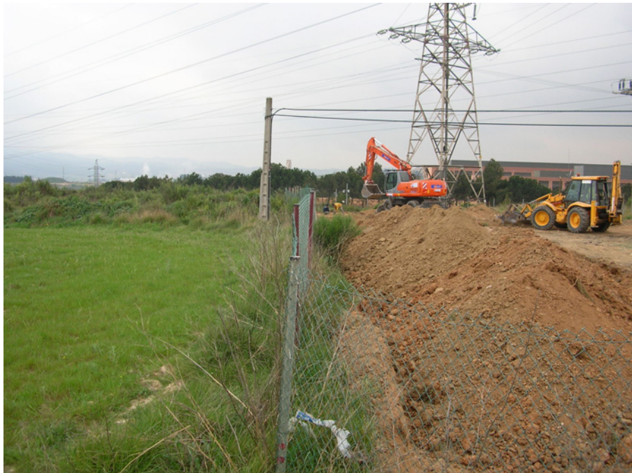
Màquines realitzant els treballs d'excavació
