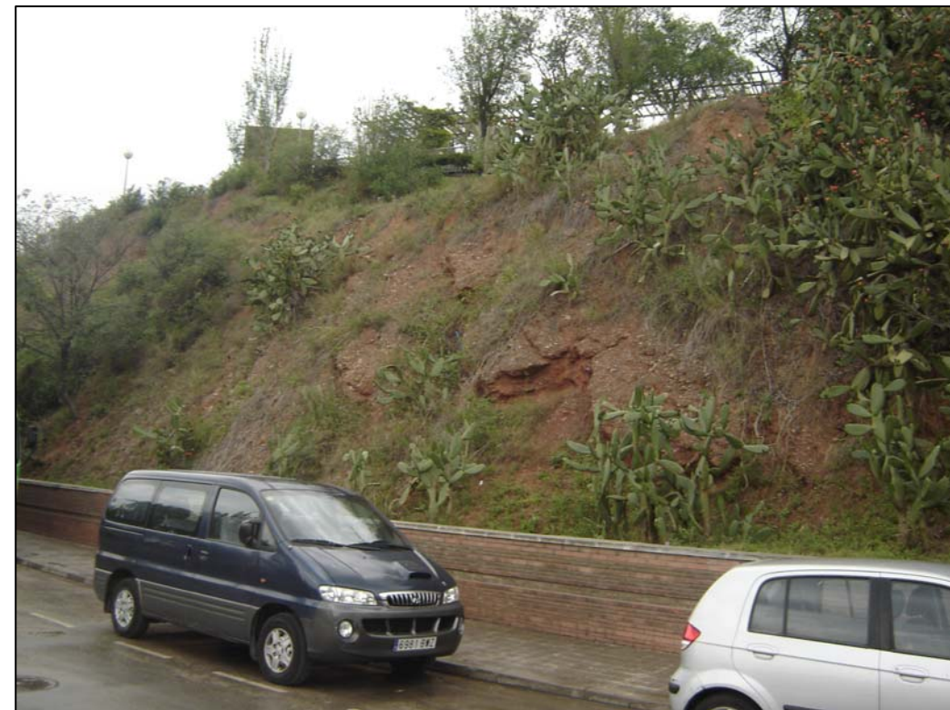
Talús de terres del Parc del Molinet, des de l'Avinguda de la Generalitat
