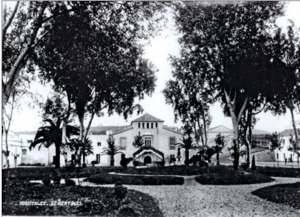
Fotografia frontal de la masia La Remonta. Font: AMH
