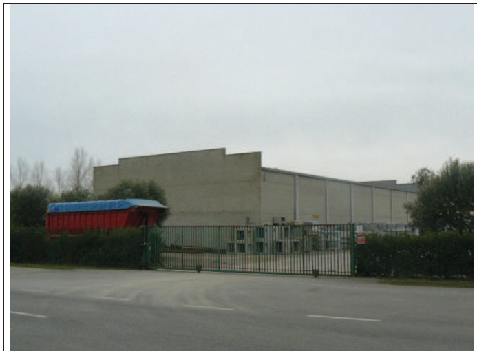
Foto 12: A.P. 1, Nau que fa de magatzem de materials de construcció.
