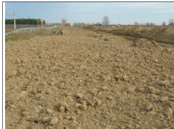
Foto 30: A.P. 3, A tocar de la carretera, obres de canalització d'aigües.
