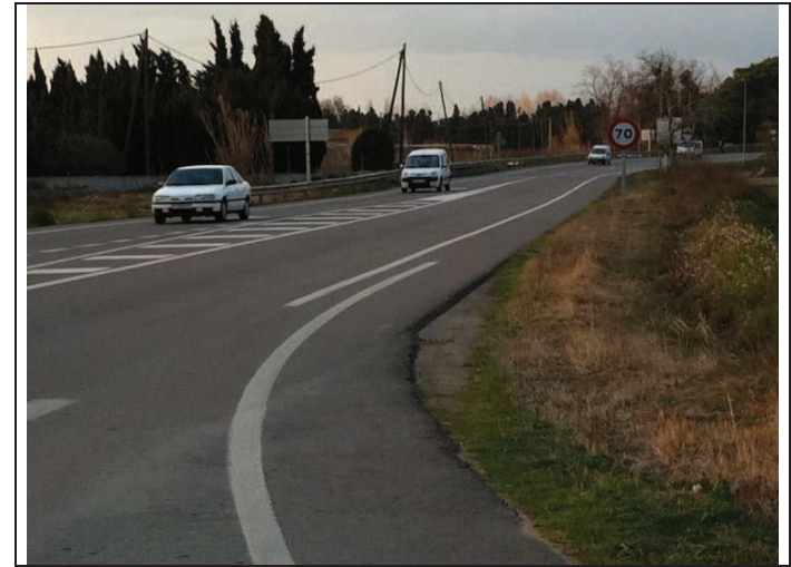
Foto 62: A.P. 6, Carretera C-31 un cop passat el pont sobre el riu Ter.
