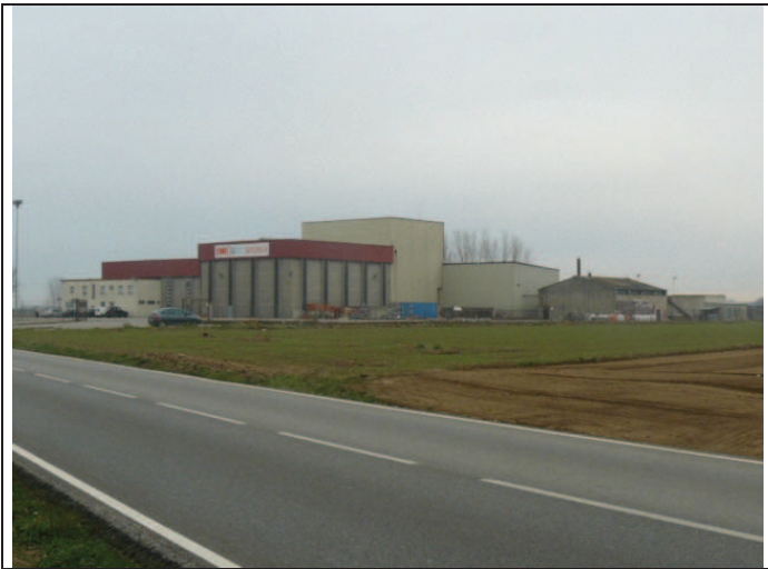
Foto 16: A.P. 1, Antiga nau d'emmagatzematge i processament de fruita i actualment destinada a magatzem de material constructiu.
