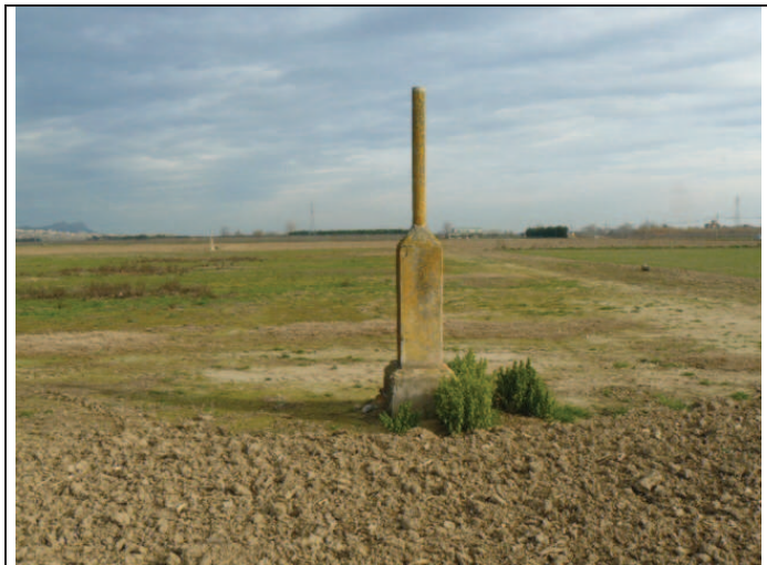
Foto 75: EH 1: Estructura hidràulica. Sifó.
