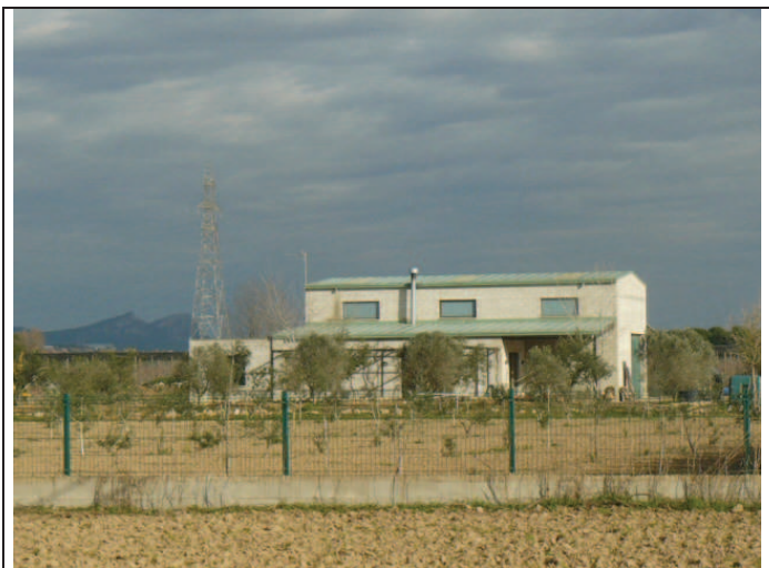
Foto 28: A.P. 3, casa i magatzem situada a prop de la traça.
