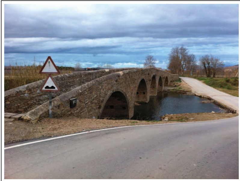
Foto 1: PA 1: A.P. 6. Pont de Gualta.
