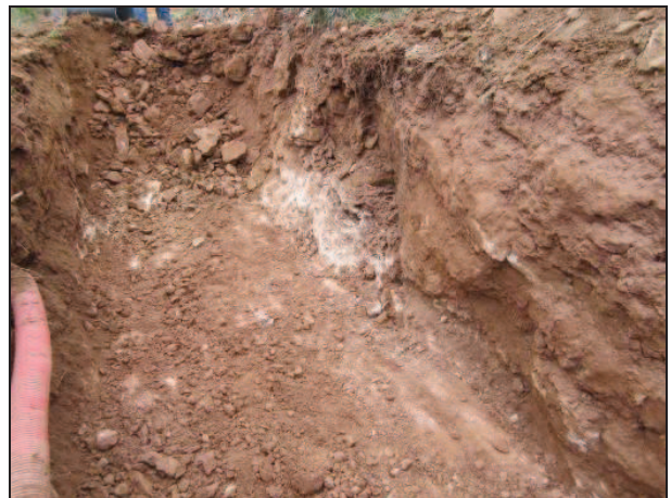
20. Treballs a la Rasa 5
