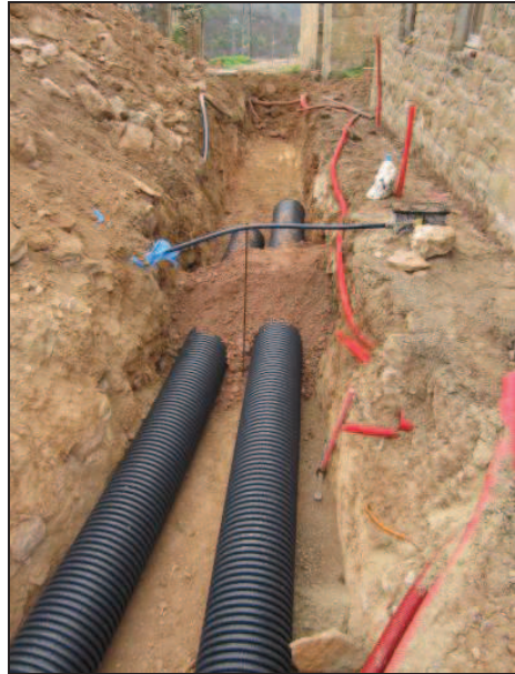
18. Vista general de la Rasa 5
