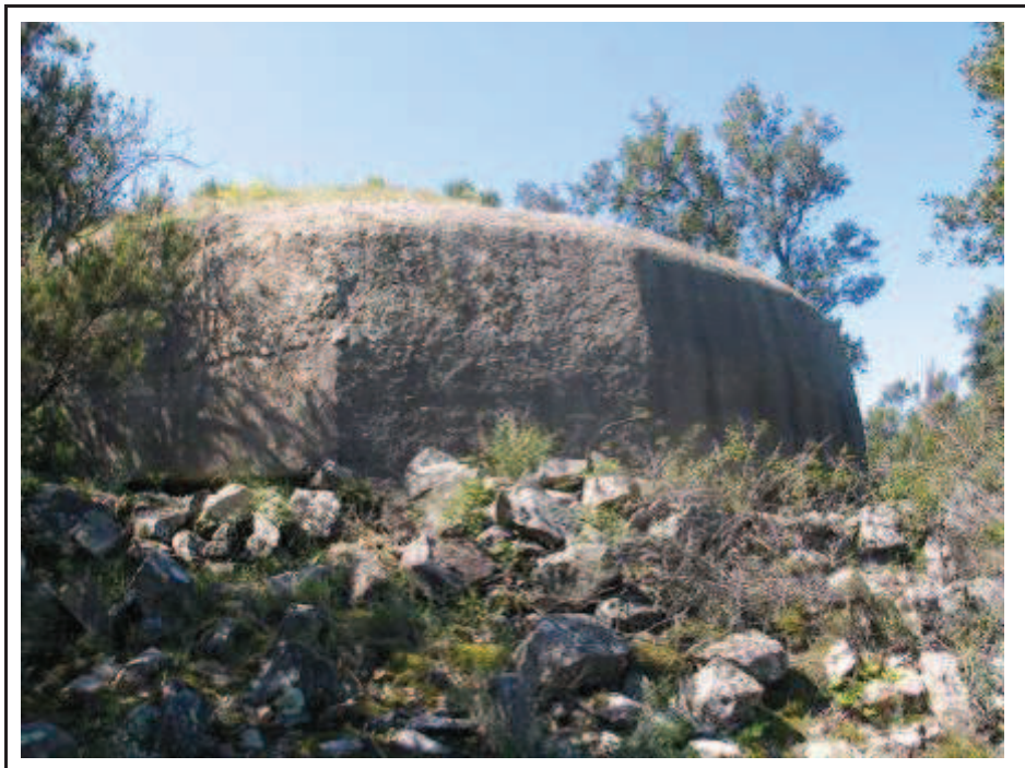
Foto 84: Vista lateral del búnquer (ELP 1).
