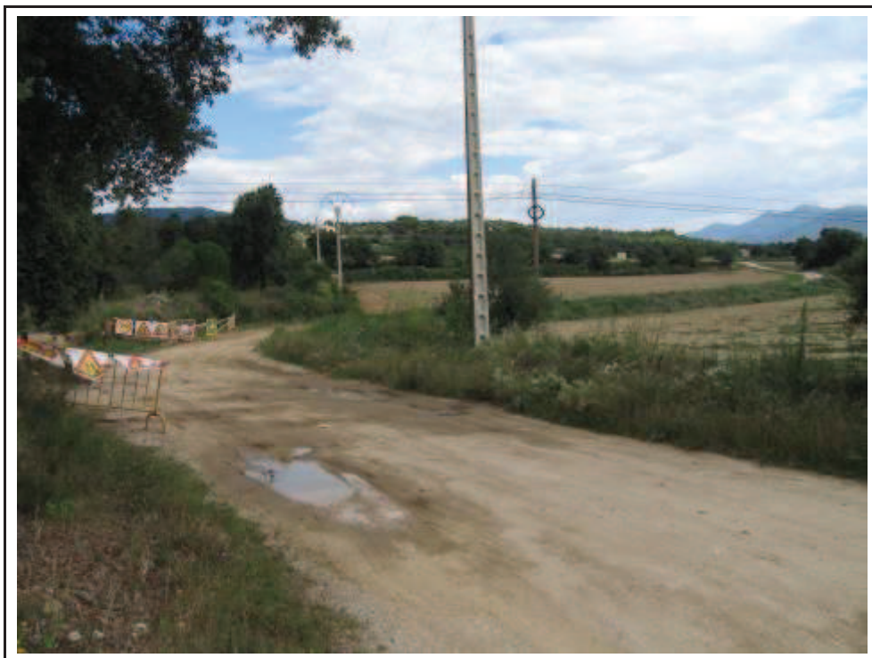
Foto 27: Inici de la via d'accés a l'aerogenerador 2 desde la carretera GI-500. Direcció nord.
