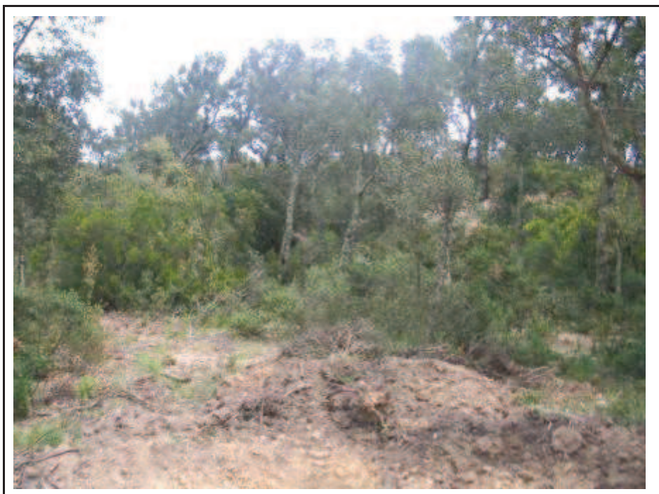
Foto 40: Nova obertura de camí per on va la rasa de connexió.
