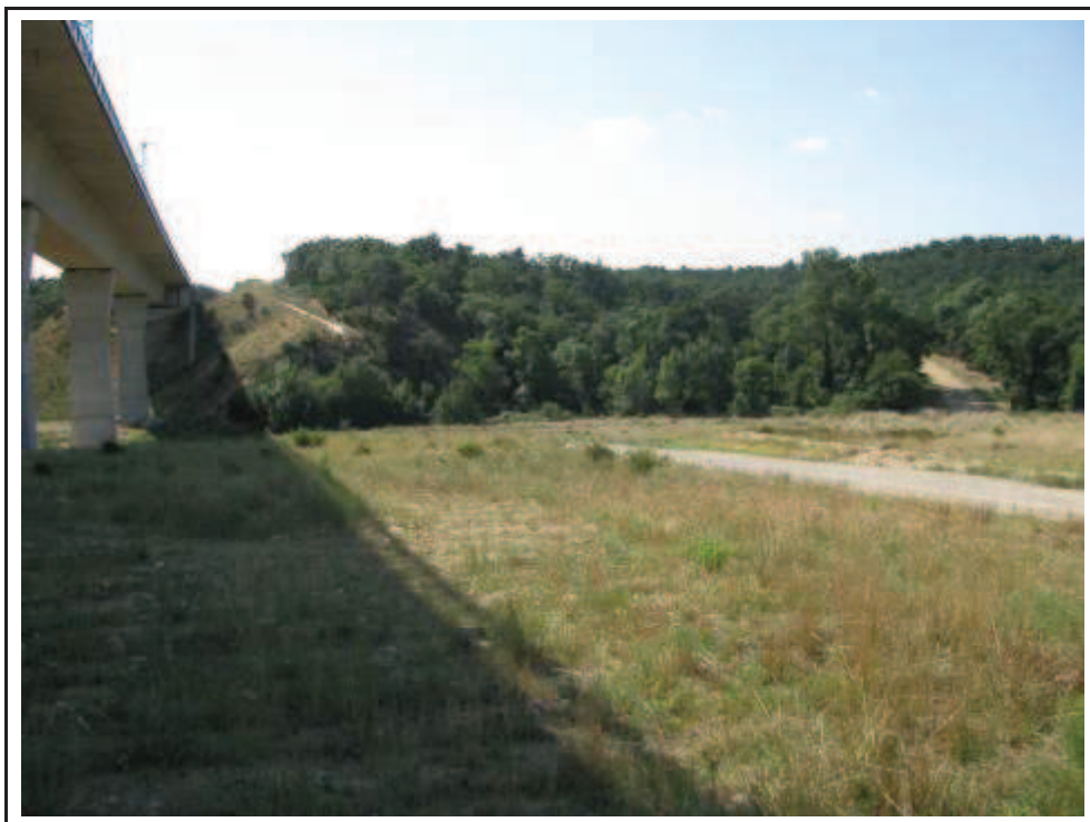
Foto 31: La rasa de connexió ressegueix i aprofita la via de servei oest del TGV (AP 3)
