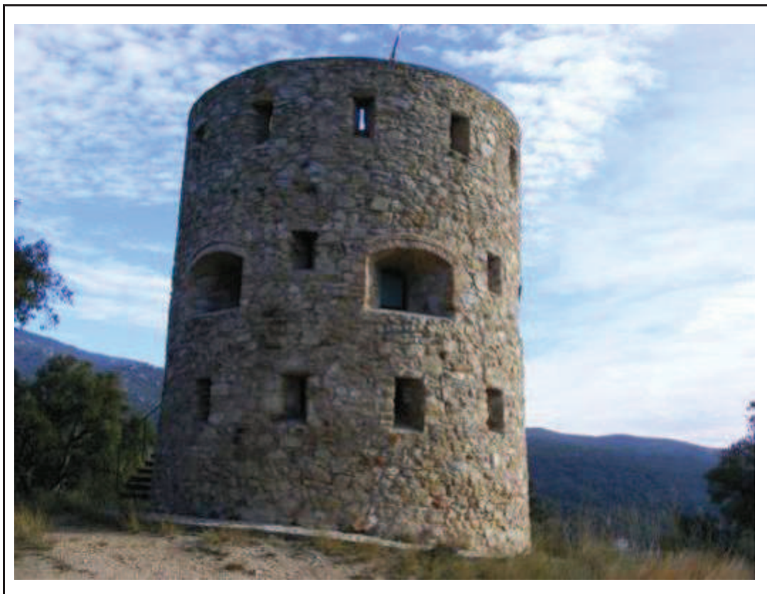
Foto 1: BCIN 1, Torre del Serrat de la Plaça.
