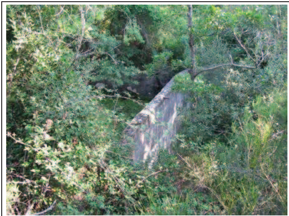
Foto 88: Vista general de l'EH 1. Resclosa o dic del Còrrec del Mestre Bernat
