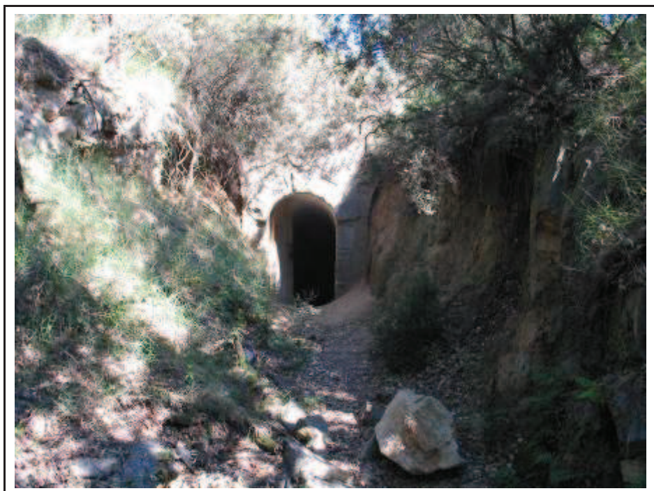
Foto 49: Entrada 1 al niu de metralladora .
