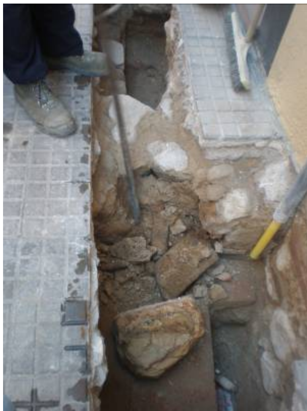
Foto 21: Procés d'eliminació del mur UE 3
