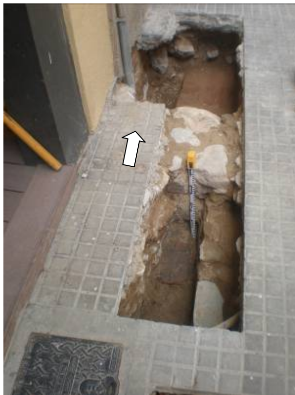
Foto 12: Finca núm. 25. Habitació 1. Murs UE 3 i UE 11 i paviment UE 16
