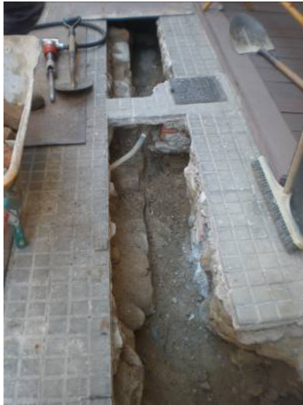
Foto 25: Després de l'eliminació del mur menor UE 15
