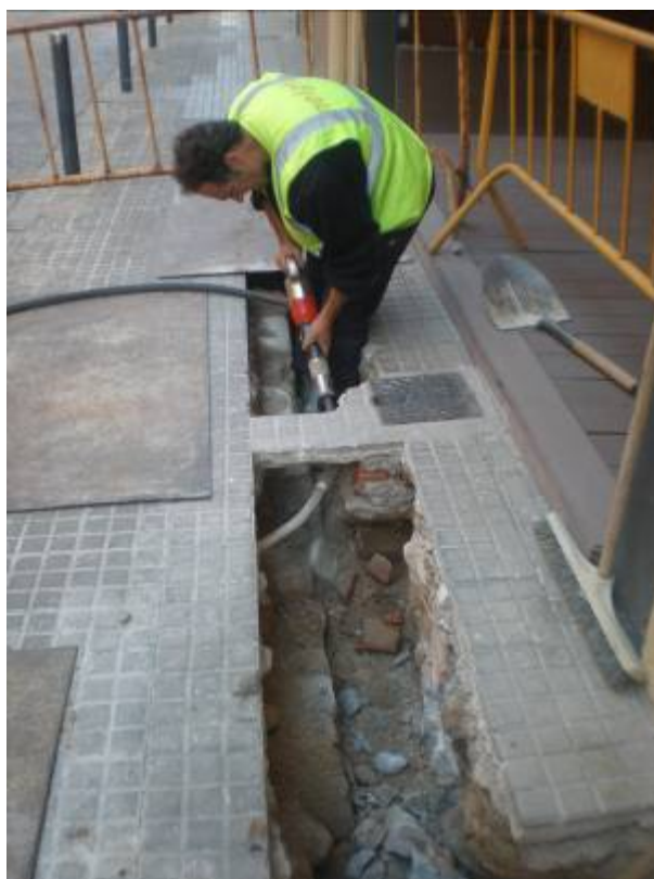
Foto 24: Procés d'eliminació del mur UE 15
