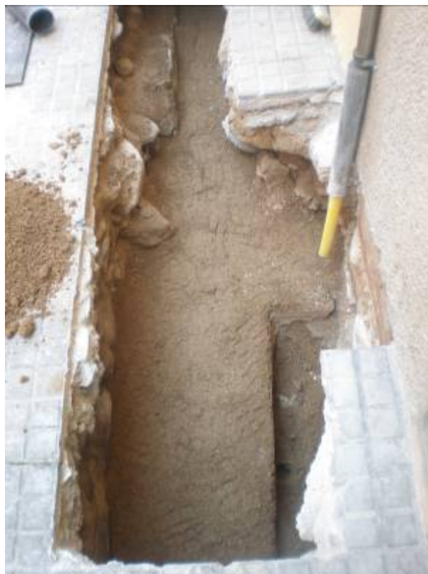
Foto 26: Anivellament amb sauló per a la instal·lació del tub
