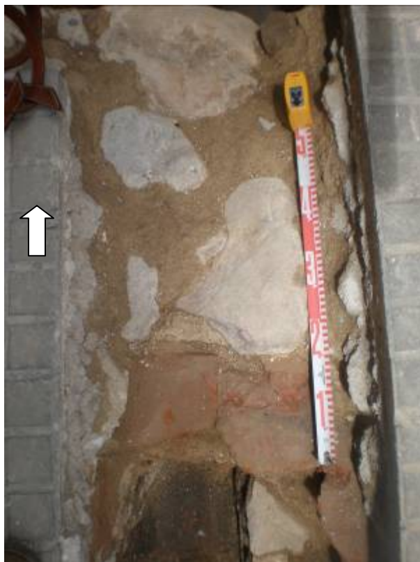
Foto 7: Finca núm. 25. Habitació 1. Detall mur UE 3 i paviment UE 2
