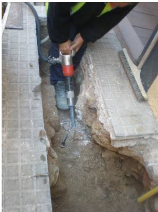
Foto 23: Procés d'eliminació del mur UE 3
