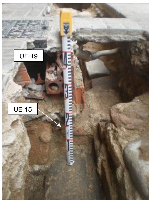
Foto 16: Finca núm. 25. Habitació 2. Detall del mur menor UE 15, cara S
