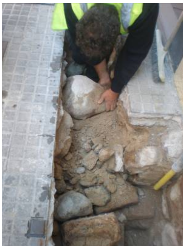
Foto 22: Procés d'eliminació del mur UE 3
