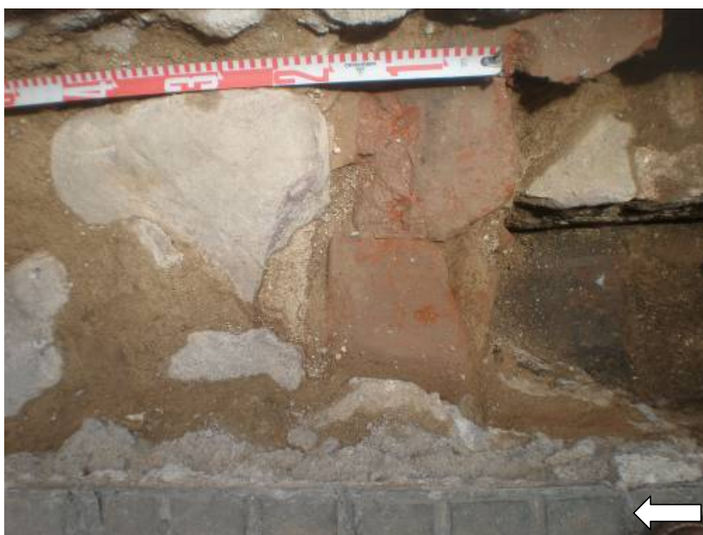
Foto 8: Finca núm. 25. Habitació 1. Detall mur UE 3 i paviment UE 2
