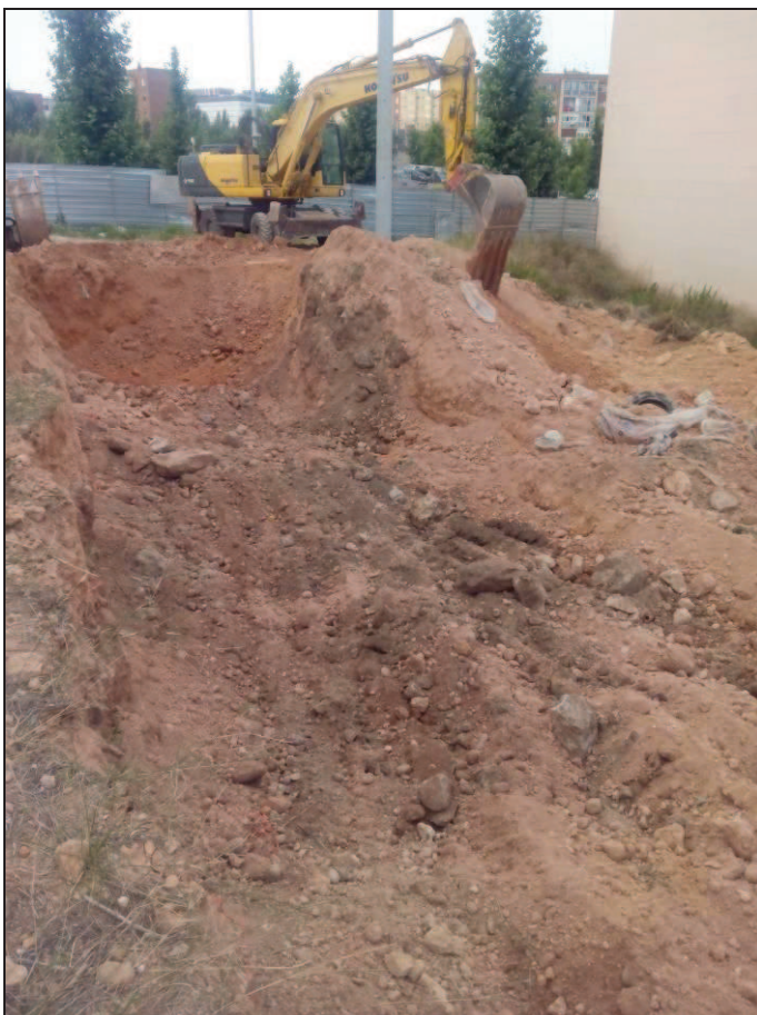
5. Detall del solar, on es pot veure com per sota de la capa de tapàs superficial –UE 1-, apareix un estrat de terra de coloració fosca amb restes de runa i plàstics –UE 2-.
