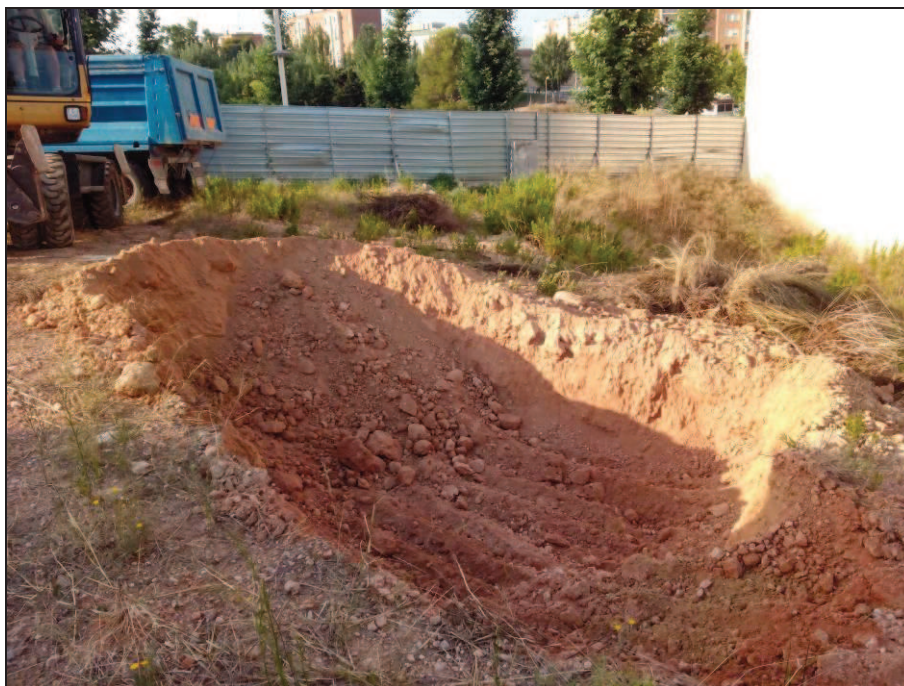
2. Vista general del solar durant el procés de rebaix, extraient l'estrat de tapàs aportat – UE 1- que forma nivell superficial.
