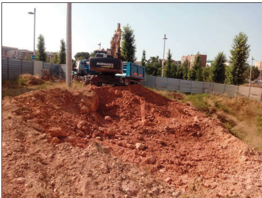
3. Vista general del solar durant el procés de rebaix, extraient l'estrat de tapàs aportat – UE 1- que forma nivell superficial.
