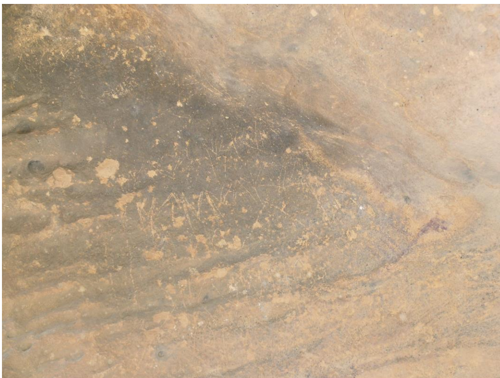
Zona superior del conjunt. Son evidents les descamacions i la crosta negra d'origen biològic.
