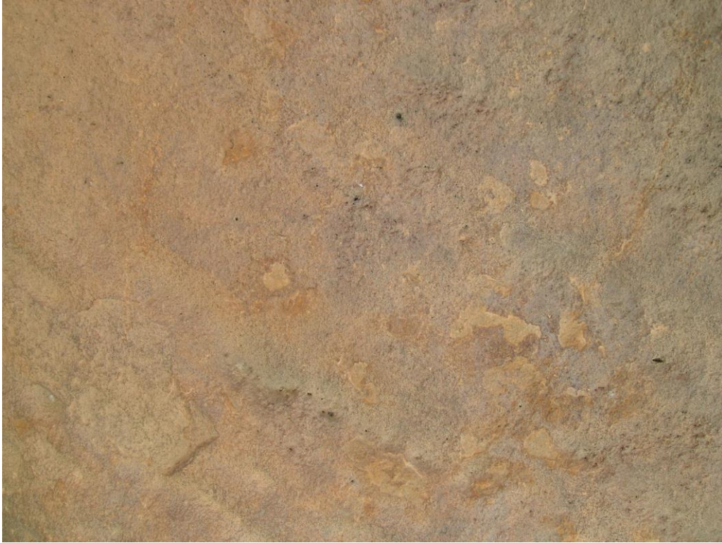
Cérvol de la part exterior abans de l' intervenció. Les descamacions son d'origen natural.
