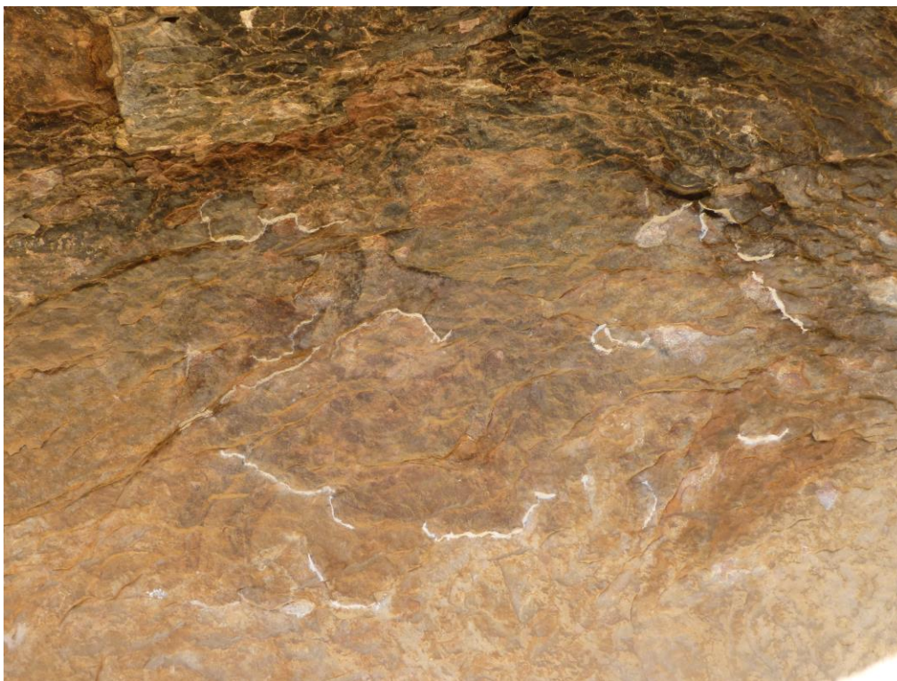
Fissures reomplertes amb morters de calç.
