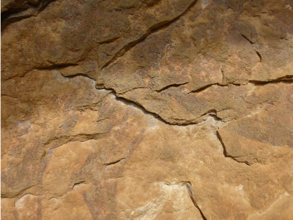
Exemple de tractament d'una fissura. Abans de la consolidació.
