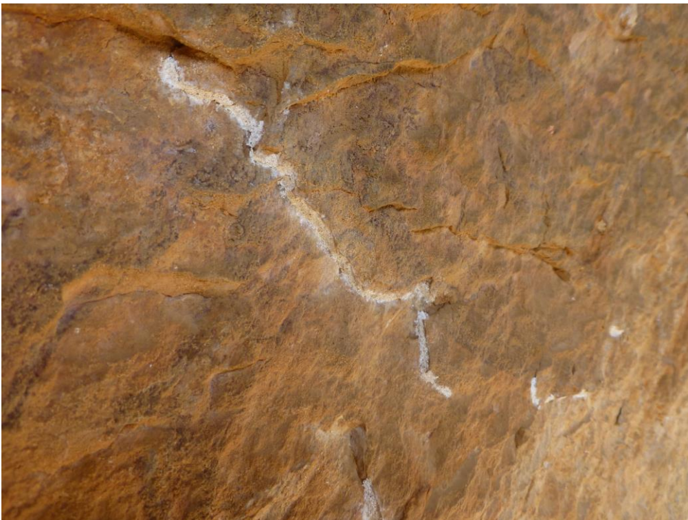
Reomplert amb morter de calç i sorra.
