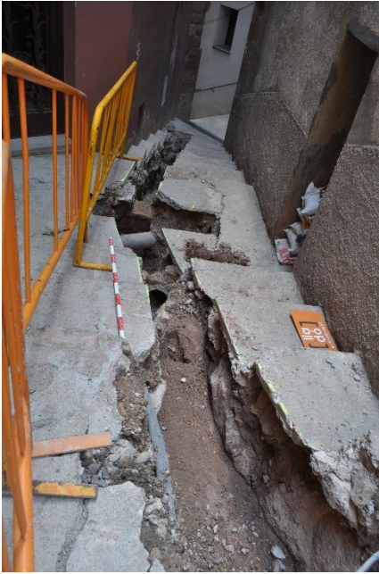
Imatge (7) de la potència del formigó en la zona de les escales
