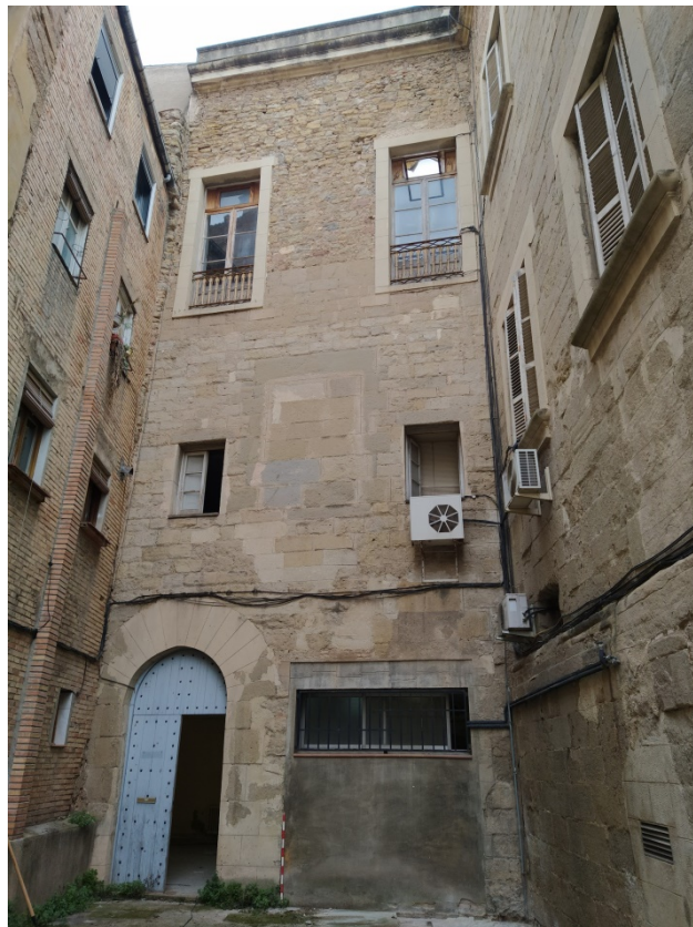
Fig.56.- Visió general de la façana de l'edifici de l'il·lustre col·legi de procuradors, conjuntament amb els edificis amb que es relaciona.
