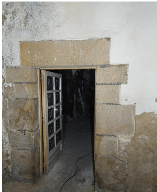
Fig.88.- Imatge de la porta interior amb llindes quadrangulars de factura pètria.
