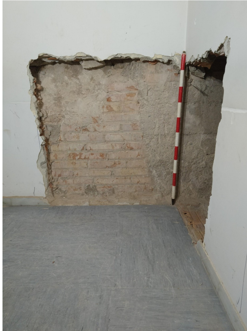
Fig.32.-Fotografia final de la Cala parietal 3 enfocada en el mur Sud.
