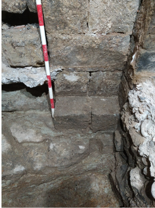
Fig.-112.-Basament de l'arc (UE 2019) sobre l'estrat geològic.
