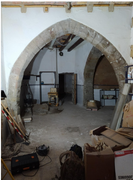
Fig.80.- Imatge d'un dels arcs apuntats de l'antic edifici de la Creu Roja.
