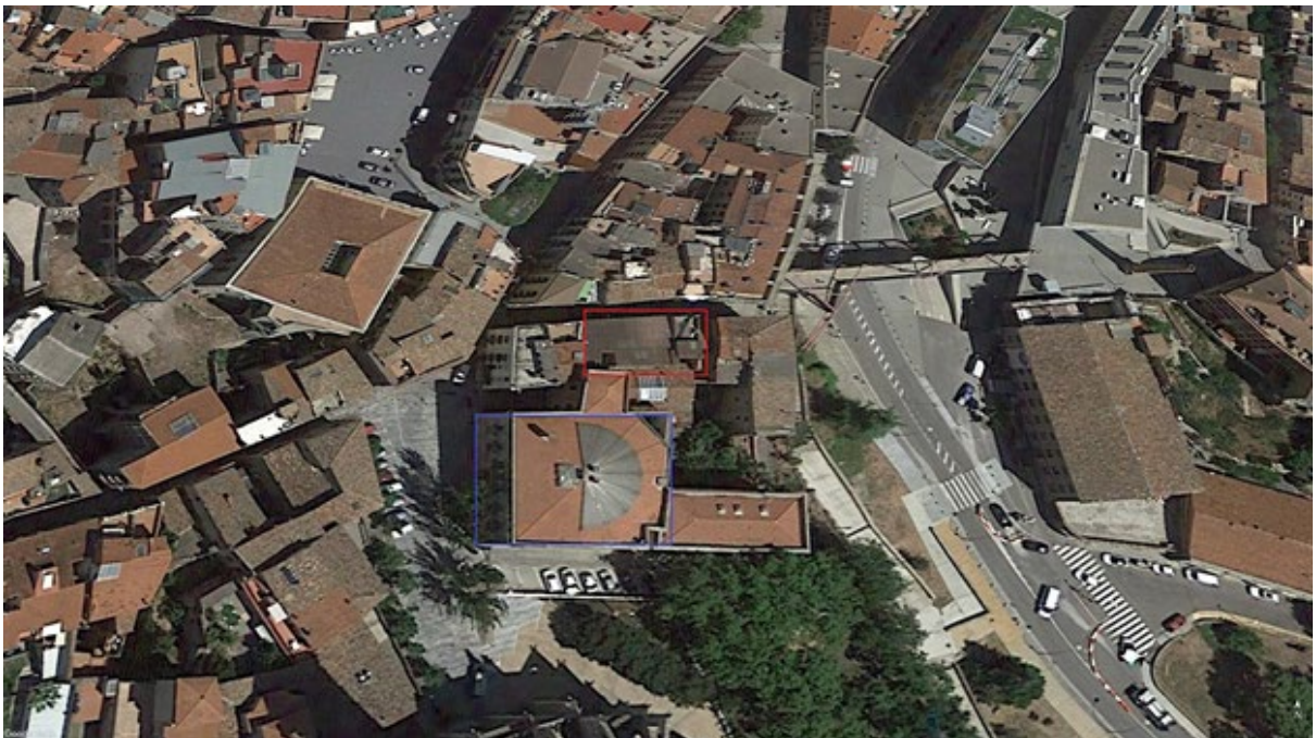
Fig.1.-Imatge satel·lital de l'emplaçament dels dos edificis que constitueixen l'objecte d'estudi. En blau trobem Baixada de la Seu 2 i en vermell Galcerán andreu 6-8.
