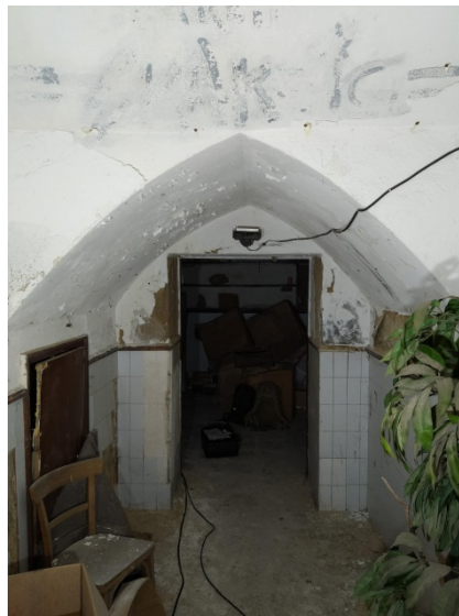
Fig.92.-Possible volta apuntada just al passar pel vestíbul de l'edifici de l'antiga creu roja.
