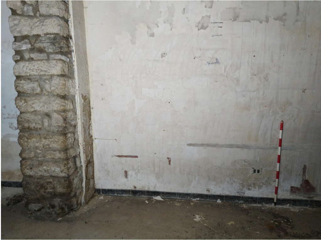
Fig.94.-Fotografia inicial de la Cala parietal 1.
