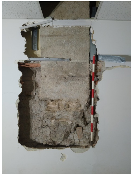
Fig.27.- Foto final de la Cala parietal 2 on s'observa la continuació de l'arc al sostre.
