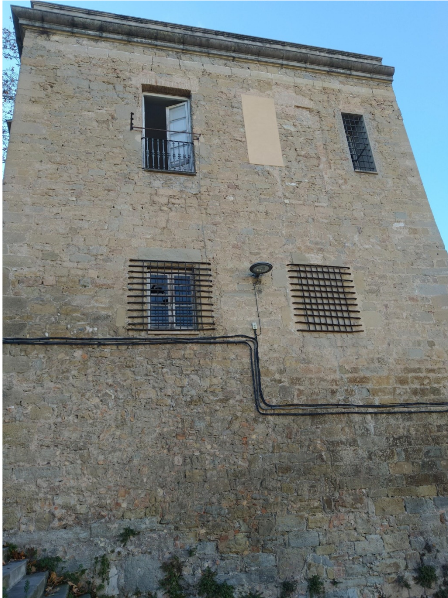
Fig.17.-Imatge de la vessant est de l'anomenada "sala gòtica"
