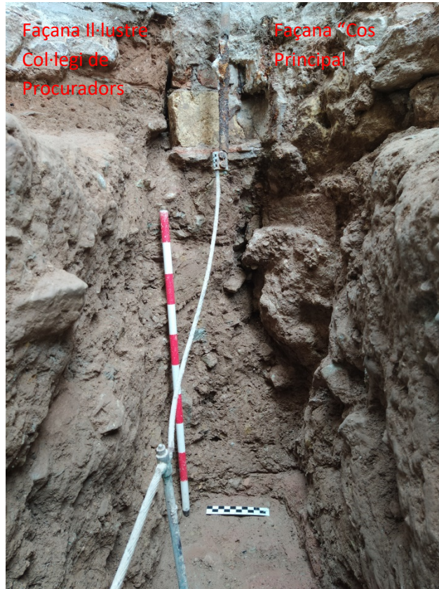
Fig.-67.- Fotografia de la vessant sud-est del sondeig on s'observa com la façana de l'il·lustre col·legi de procuradors s'adossa al mur nord del cos principal de l'edifici dels "antics jutjats".
