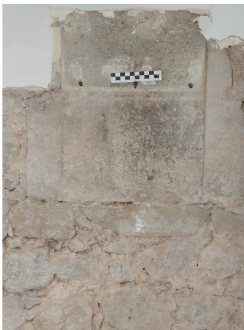
Fig.37.-Fotografia final de la Cala parietal 4 on s'observa la base de l'arc integrada en l'estructura del mur antic.
