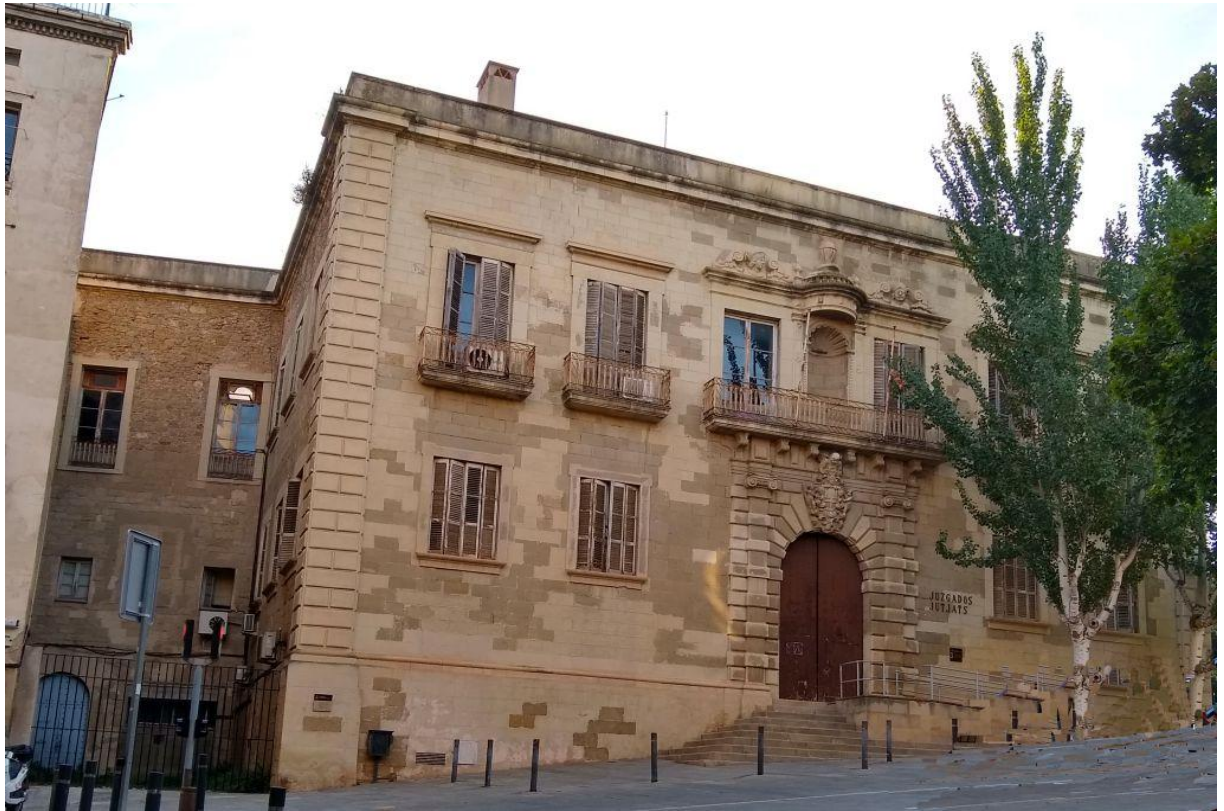
Fig.3.- Façana de l'edifici situat a Baixada de la Seu núm.2
