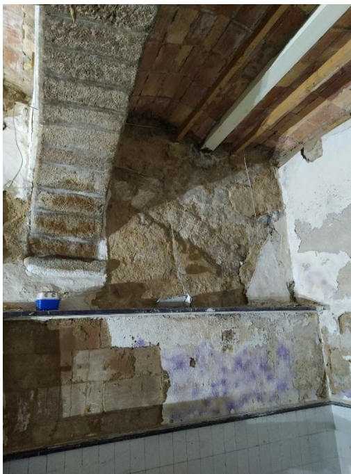
Fig. 83.-Imatge de l'arc de mitja volta, on se n'aprecia un altre tapiat a la paret.
