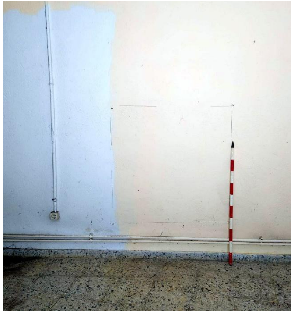
Fig.38.-Fotografia inicial de la Cala parietal 5.
