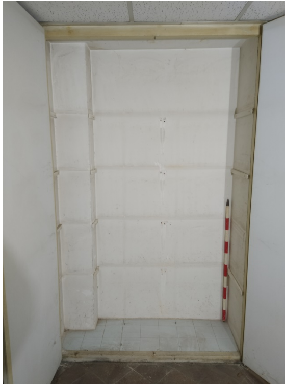
Fig.40.-Fotografia inicial de la Cala parietal 6
