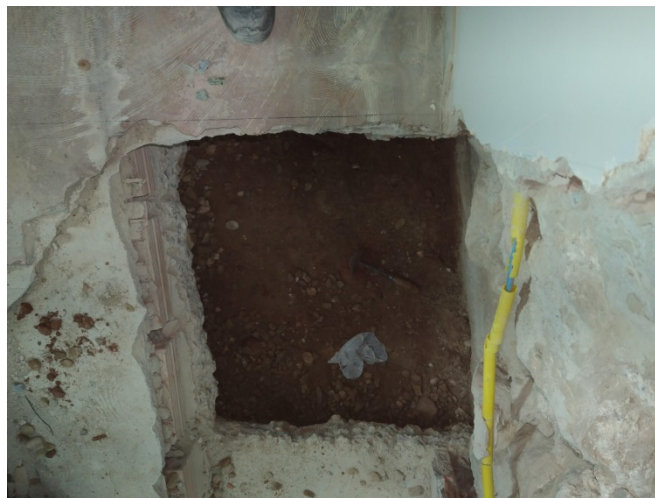
Fig.49.-Imatge del final de la UE 1010 amb la bossa de plàstic
