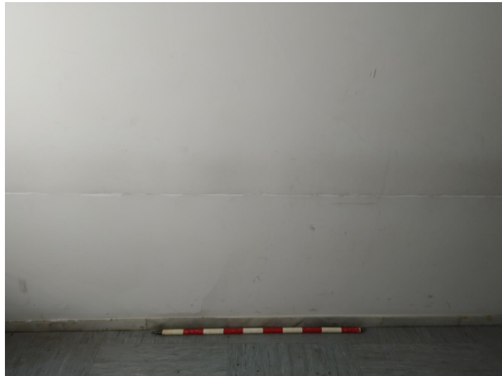
Fig.21.- Fotografia inicial de la cala parietal 1
