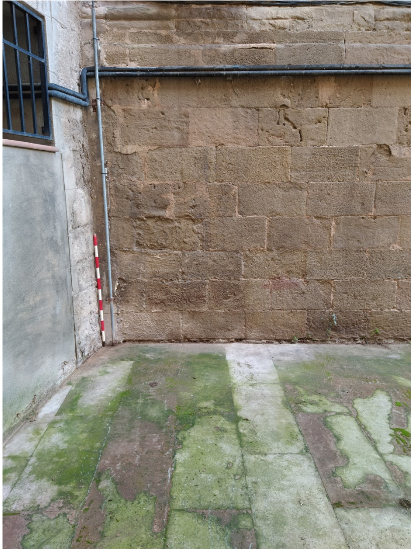
Fig.58.-Fotografia inicial del sondeig 3, en relació al mur nord del cos principal de l'edifici de Baixada de la Seu nº2.
