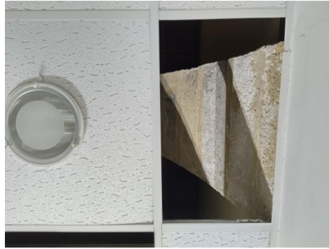
Fig.20.- Arc número 2 del qual volíem saber-ne el funcionament mitjançant la cala parietal 1 i el sondeig 1.
