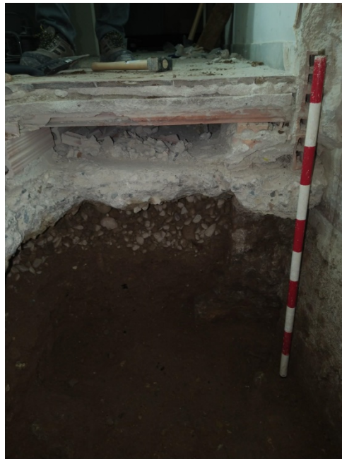
Fig.51.- Foto de la UE 1013 en relació a la pavimentació de l'edifici, que confirma que es tracta de terres aportades per a sostenir la mateixa.
