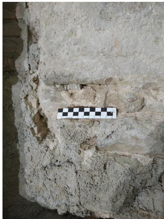
Fig.29.- Detall de la base de l'arc en relació al formigó contemporani.
