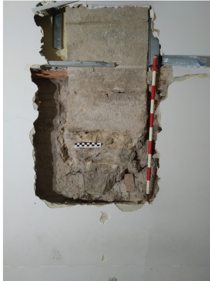
Fig.28.- Fotografia final de la Cala Parietal 2 on s'observa com no té la base original de suport, i queda penjat sobre un mur compost de maó i formigó contemporani.
