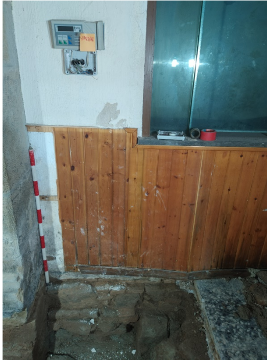
Fig.103.-Fotografia inicial de la Cala parietal 4.
