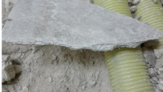
Fig.129.- Fotografia d'un dels sondejos de l'interior de Jutjats Vells on va aparèixer el fibrociment.
