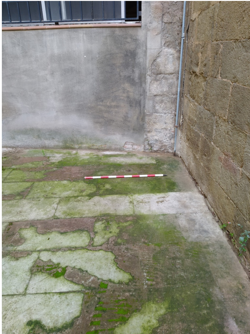
Fig.57.- Fotografia inicial del Sondeig 3 en relació al mur de la façana de l'edifici de l'il·lustre col·legi de procuradors.
