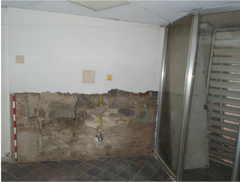
Fig.43.- Fotografia final de la Cala 7.
