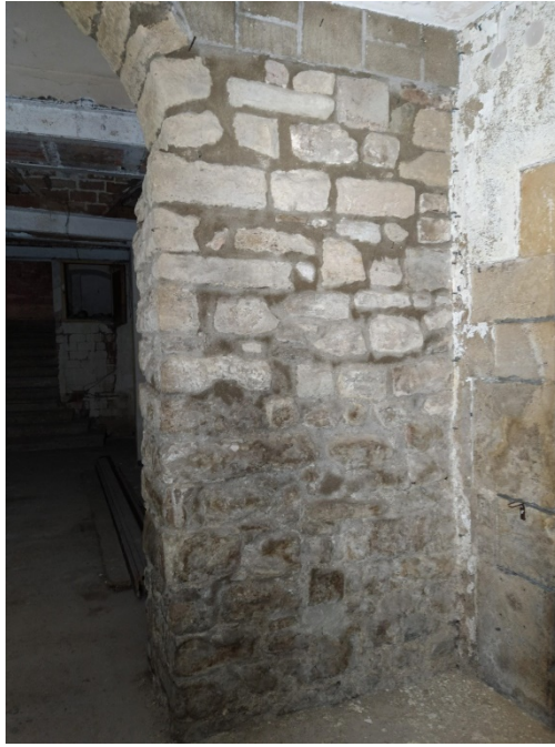
Fig.91.-Imatge de com es relaciona l'arc respecte la paret on trobem la porta amb llindes quadrangulars.
