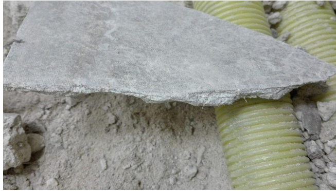
Fig.55.- Fibrociment trobat durant el Sondeig 2.
