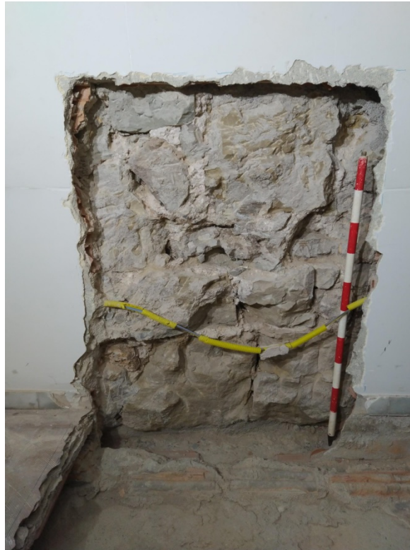
Fig. 45.-Foto de la cala parietal 1 en relació al paviment de formigó. S'observa formigó en la mateixa paret, el que indica o una reforma recent o el fet de que el mur sud pugui haver estat afectat per la reforma de l'any 1979.
