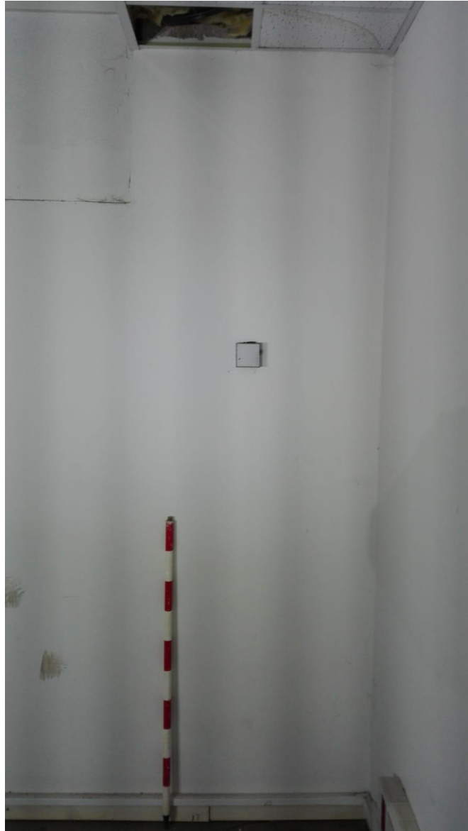
Fig.35.-Fotografia inicial de la Cala parietal 4.
