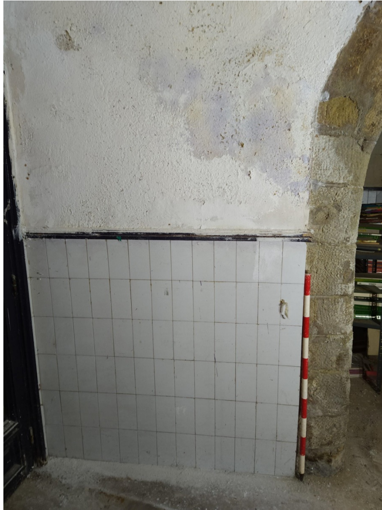
Fig.97.-Fotografia inicial de la Cala parietal 2.
