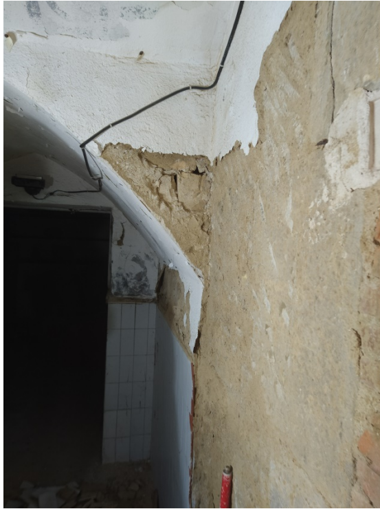
Fig.106.- Fotografia final de la Cala parietal 5, amb especial èmfasi en la volta apuntada.
