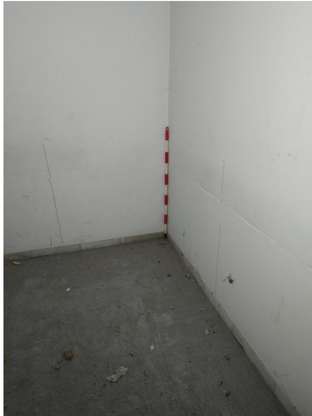
Fig.30.- Fotografia inicial de la Cala parietal 3.
