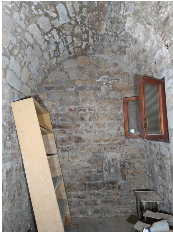
Fig.79.-Habitació feta amb carreus de pedra i volta de canó.
