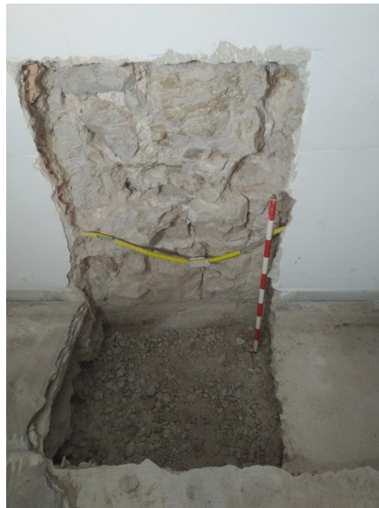
Fig.47.-Foto inicial del sol d'anivellació sorrenc (UE 1010) del sondeig 1, on s'aprecia la filera de maons arrebossats amb morter (UE 1011) a sota de la base de pedra (UE 1005) de l'arc 2 a la cala parietal 1.
