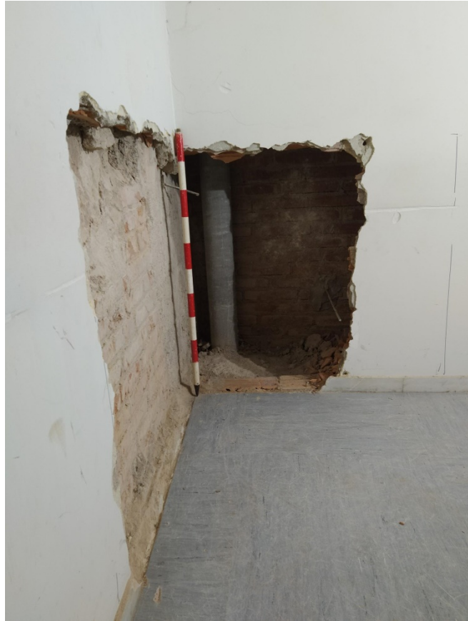
Fig.33.-Fotografia final de la Cala parietal 3 enfocada en el mur de tancament de la “sala gòtica”.
