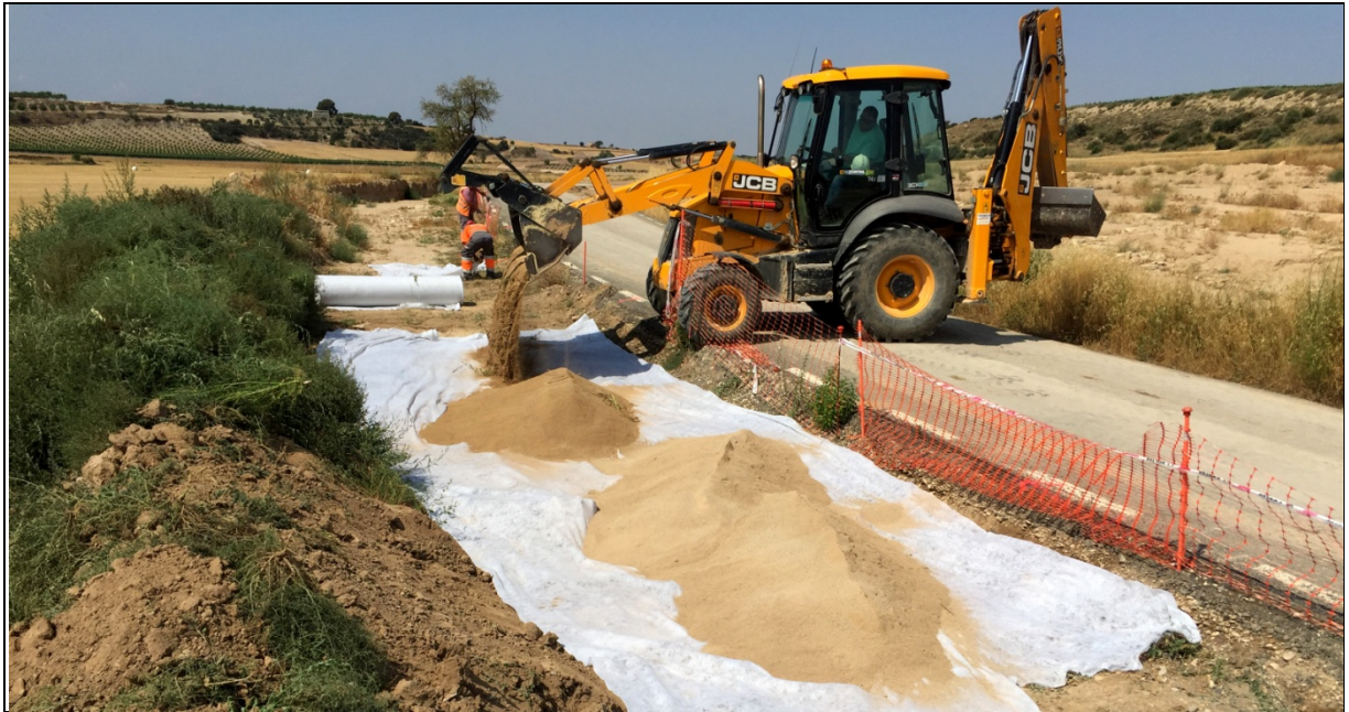
FOTO 16. Vista del procés de cobriment amb sauló de la capa de geotèxtil col·locada inicialment.
