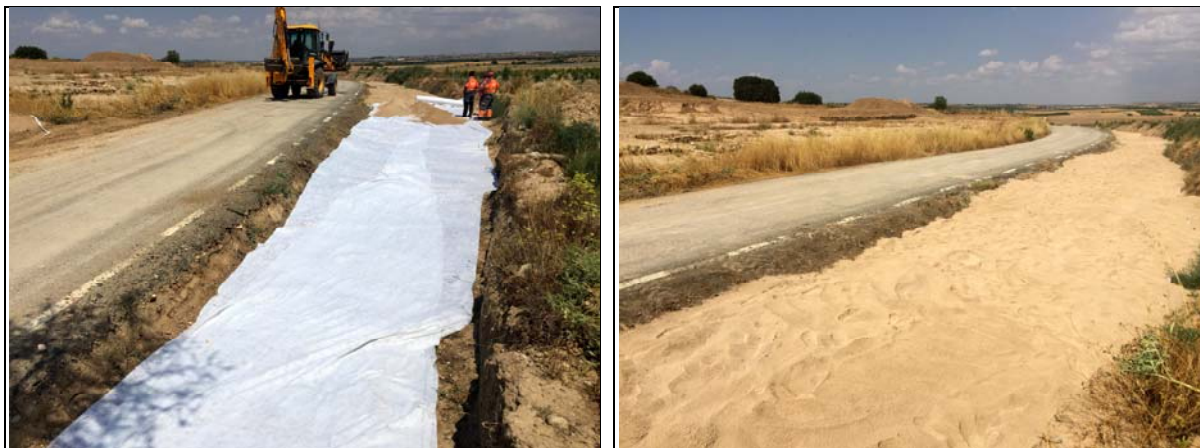
A l'esquerra, cobriment amb geotèxtil. A la dreta, capa de sauló abocada damunt del geotèxtil.
