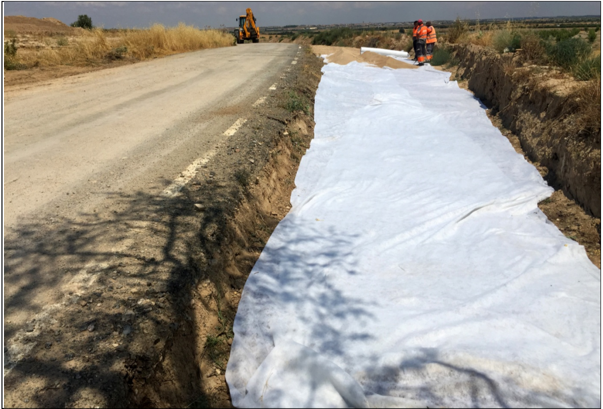
FOTO 14. Vista dels treballs de cobriment amb geotèxtil de la zona d'intervenció arqueològica.
