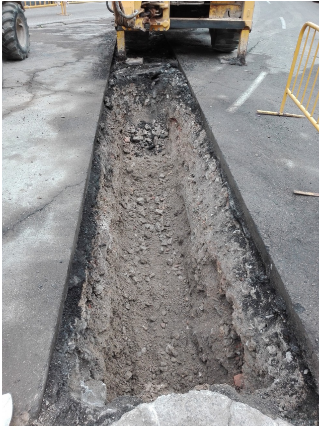
PSACBC-2018-4: Retirada reblert obertura rasa.
