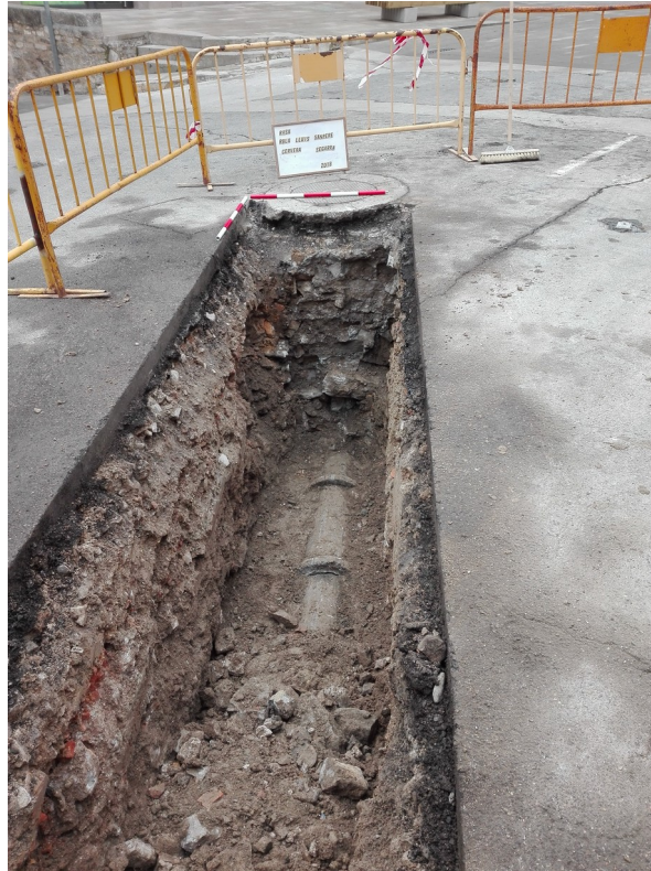
Detall de la claveguera existent.
