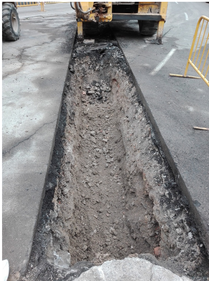
Obertura de la rasa.
