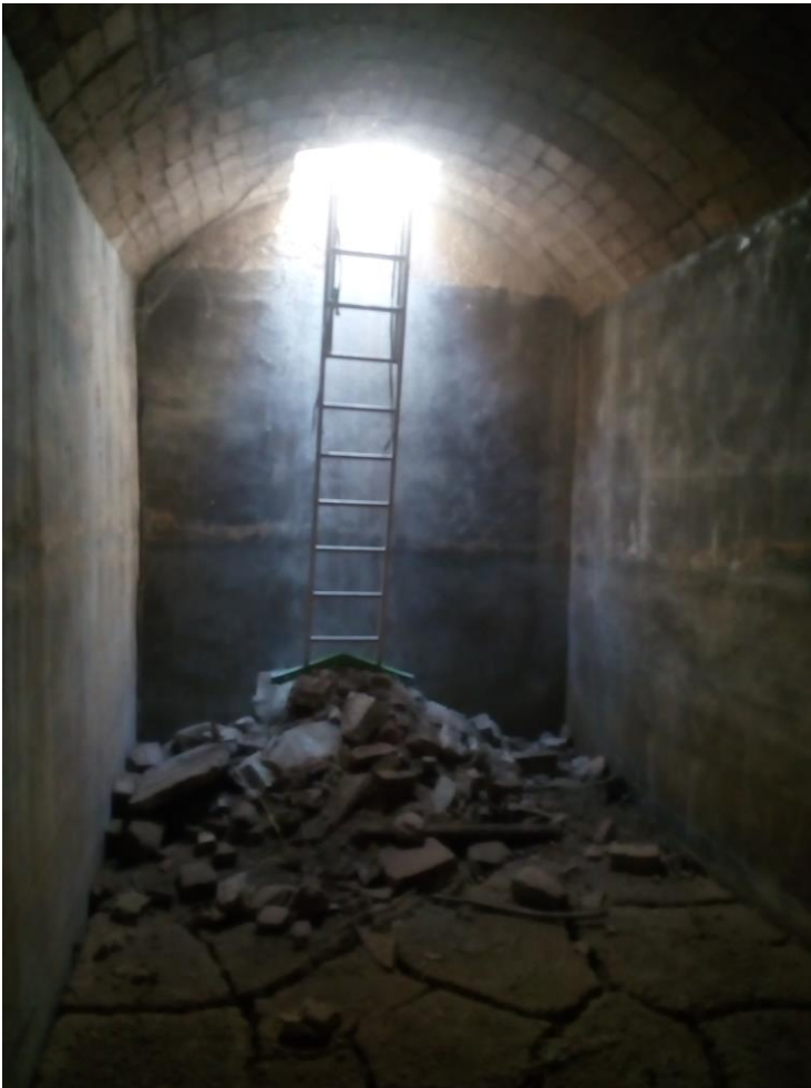
vista de l'interior de la cisterna.
