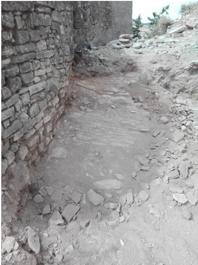
Detall del empedrat al costat de la torre, destruït al costat del mur de talús.
