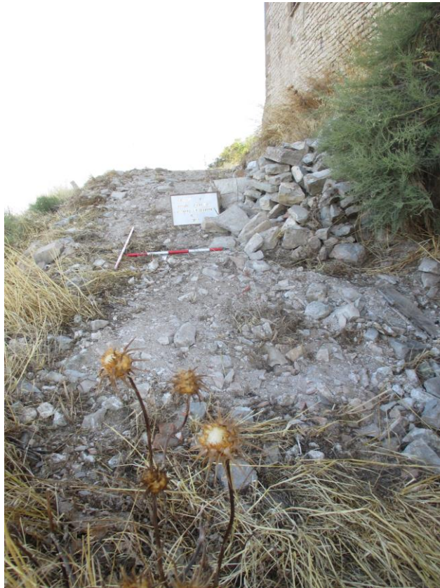
Estat inicial en que es trobava l'accés a la rampa principal
