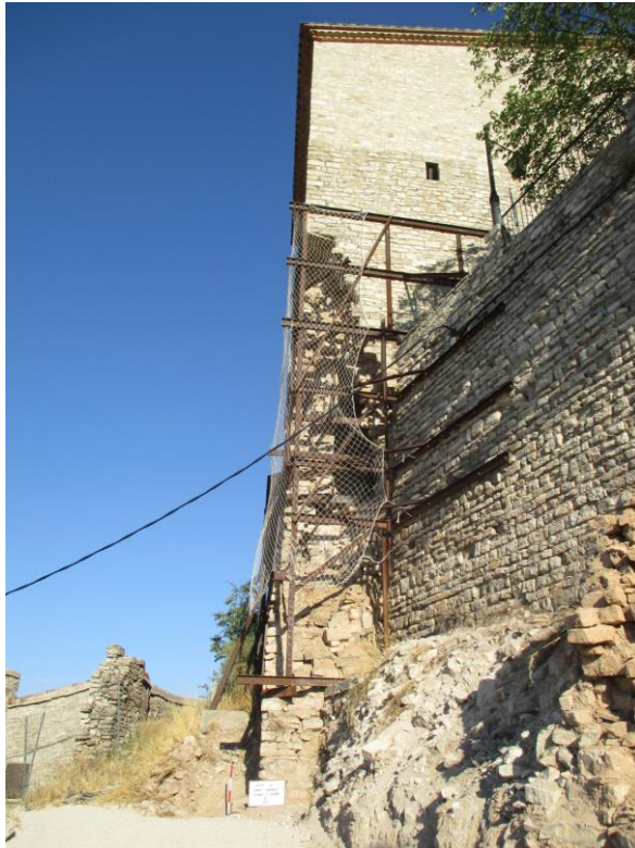
Obertura de la rasa per a micro pilotatges.
