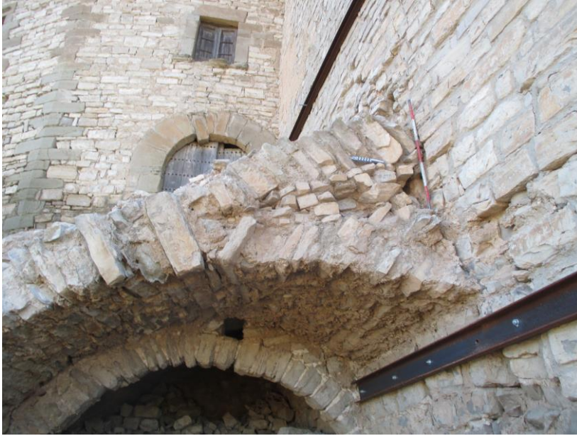
Detall de l'arc amb la seva ampliació i la construcció del remunt.
