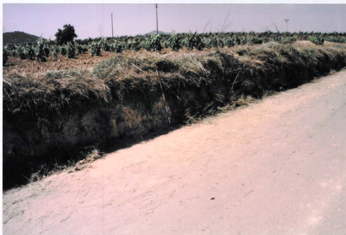
Dos detalls de les restes localitzades a uns metres a l'oest de la sitja, que podrien ser les traces d'un paleocanal tallat pel camí.
