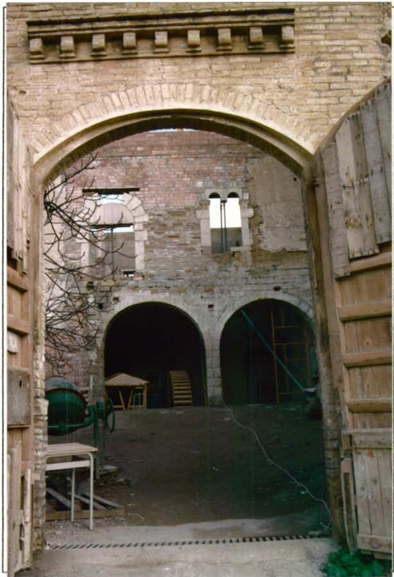
Vista frontal de l'ambit B. Es poden observar les arcades que s'obren al pati i també la porta i la finestra que donaven accés a la planta pis des de la balconada.
