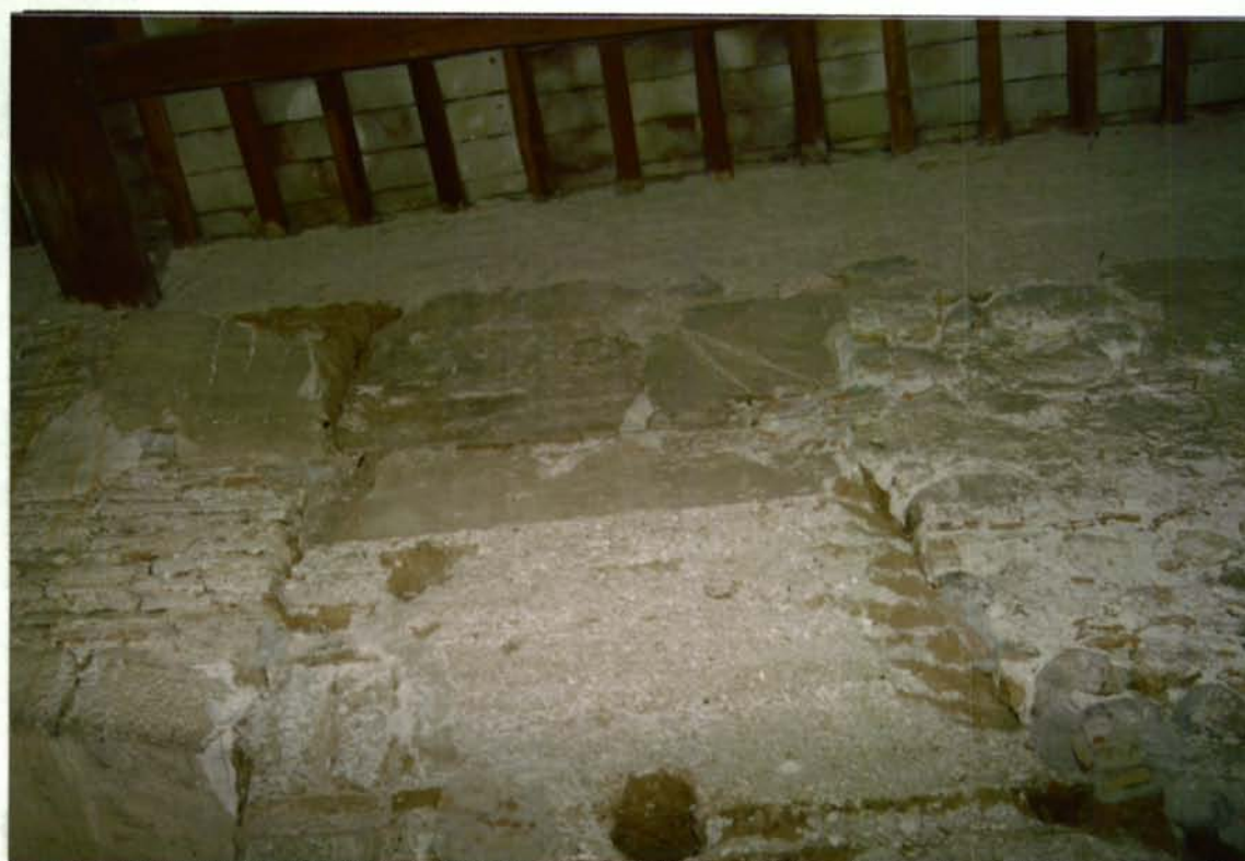
Ilustr. Detall de l'interior de la façana. Es pot veure la reparació en mamposeria de la cantonada amb el mur nord del castell.
