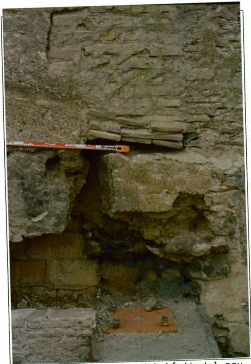
Detall de l'exterior del límit del nou cos. Es pot veure com els merlets s'encavalquen per sobre les estructures antigues.
