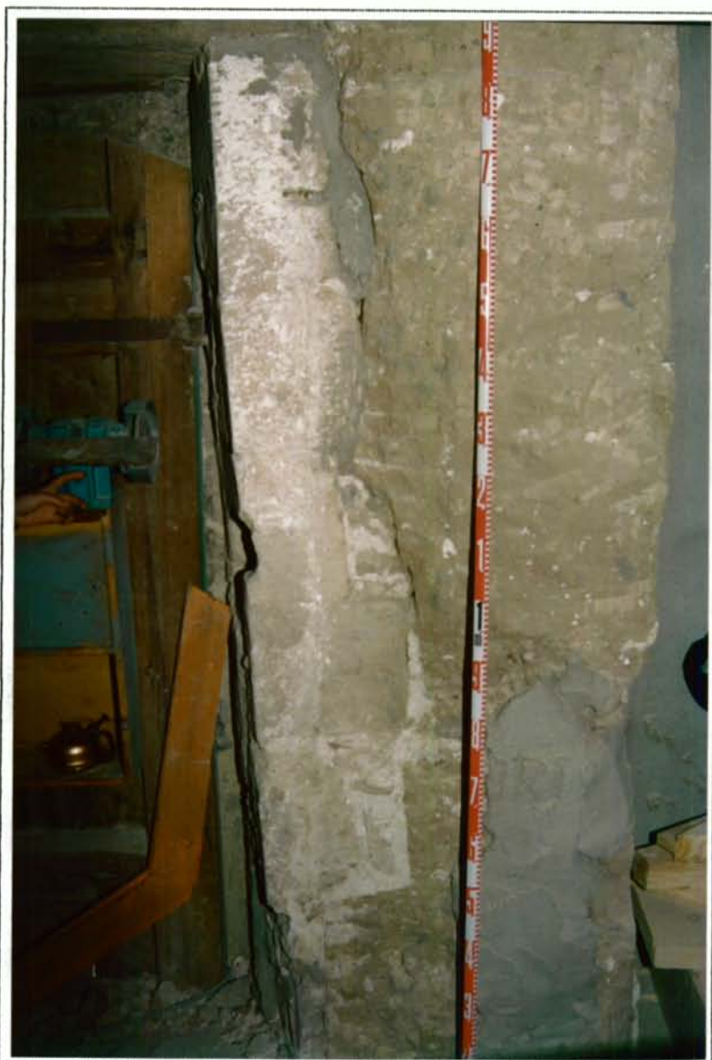
Detall de la porta d'accés a la balconada des del cos est. S'observa com amb la seva construcció es talla l'antic mur de tancament.
