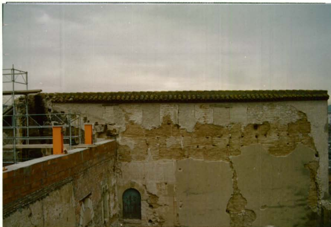
Ilustr. Visió de la part posterior de la nova teulada. Es poden observar els merlets antics tapiats.
