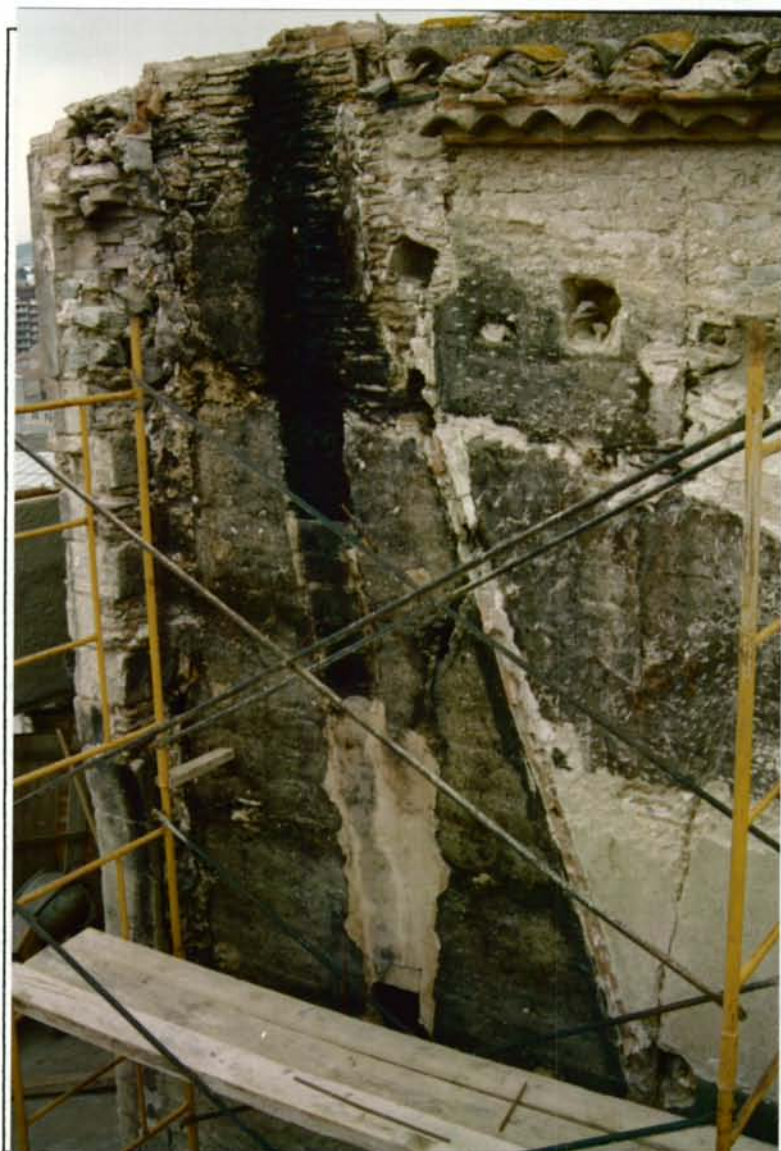
Detall de les traces que han deixat la xemeneia i la seva campana sobre el mur del castell.
