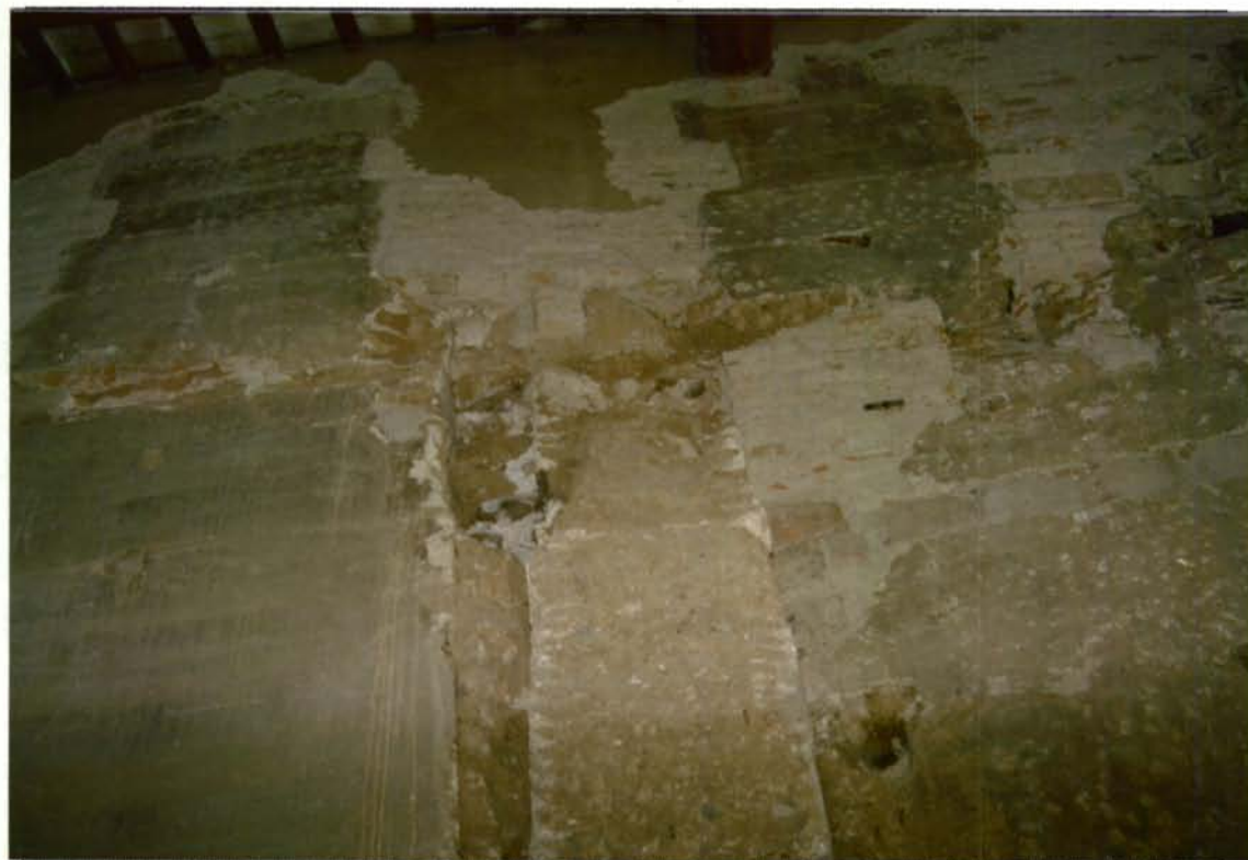
Ilustr. Detall de l'interior del cos est. Es poden veure els antics merlets de castell un cop integrats en el mur que sosté l'enbigat de la teulada.
