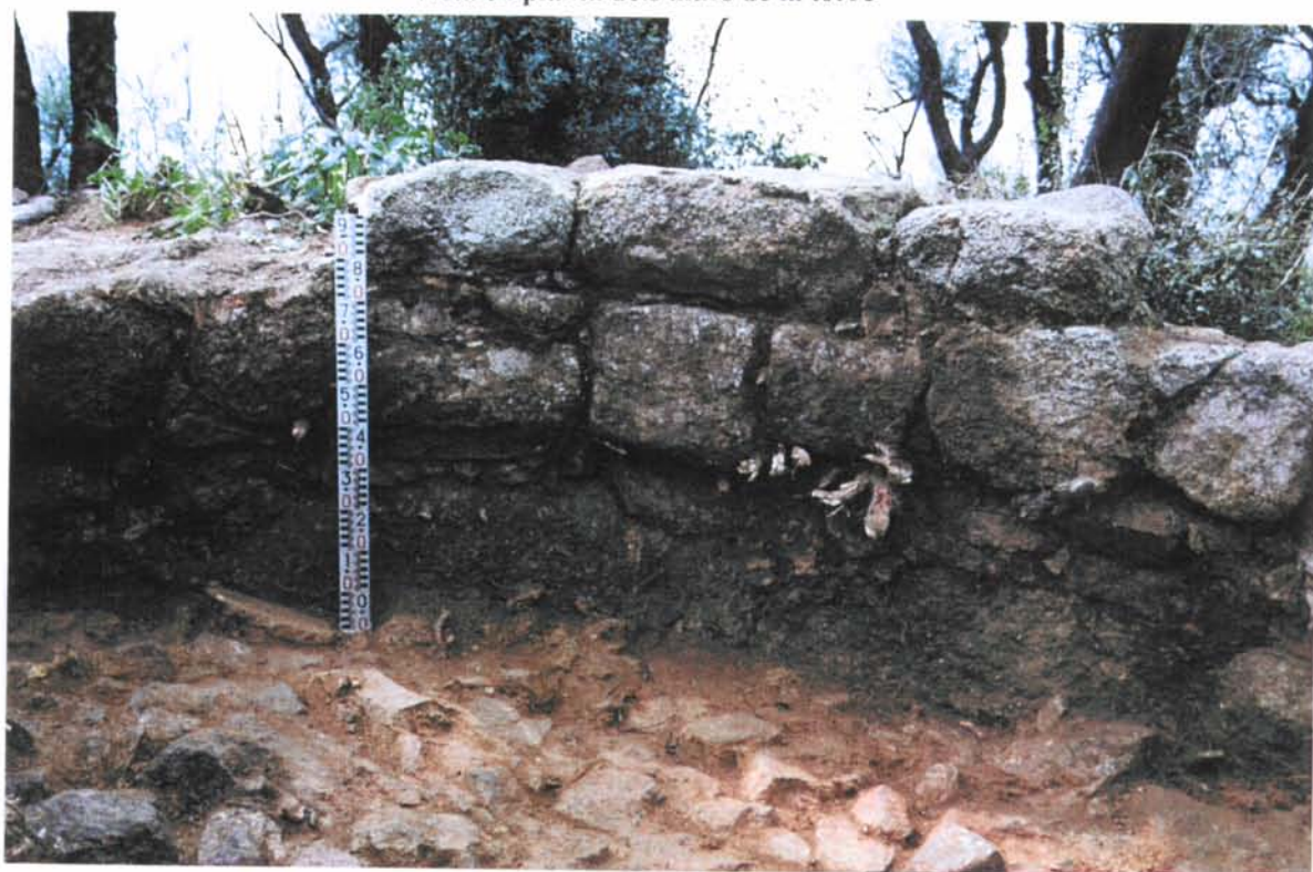
Cara interior dels murs de la torre
