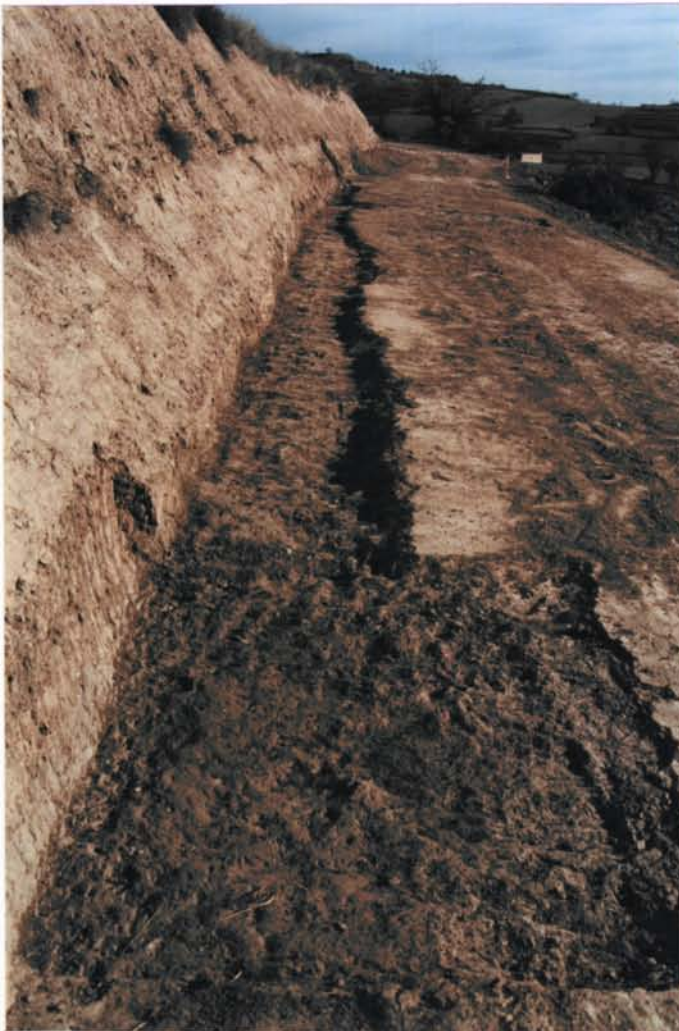
Fotografia 2. Vista de la rasa realitzada al llarg del marge del camí.
